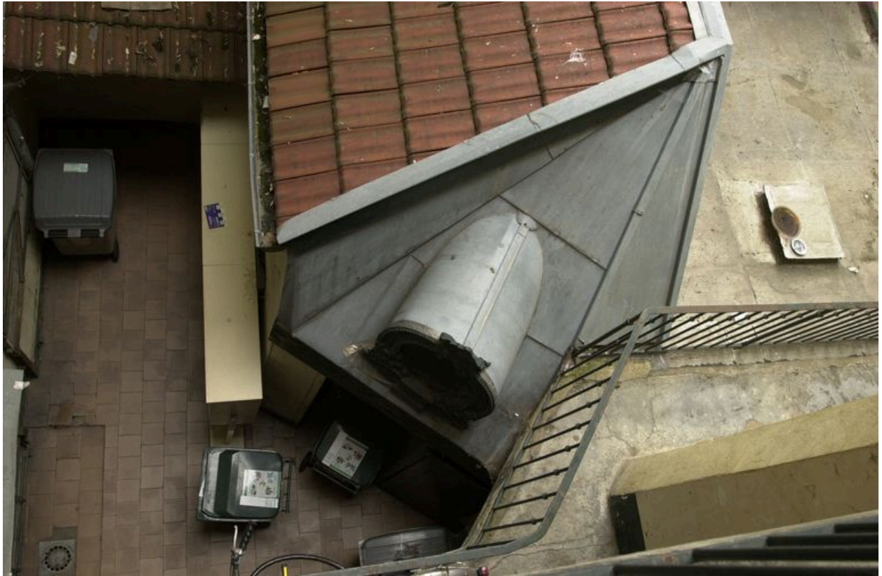
Vue de la loge de concierge dans la cour
