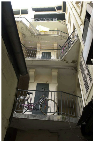
Vue des coursières depuis la cour IVR82_20026902816NUCA
