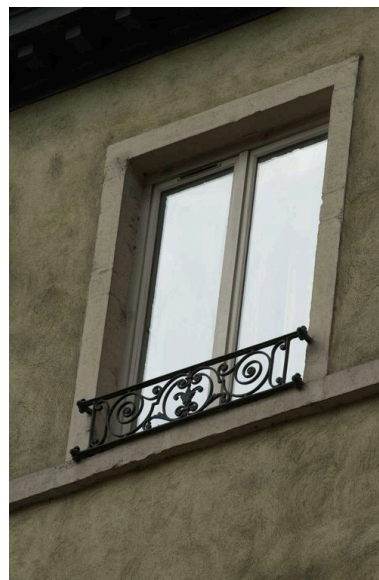
Détail d'un garde-corps, 3e étage Grande rue de la Guillotière IVR82_20026902811NUCA
