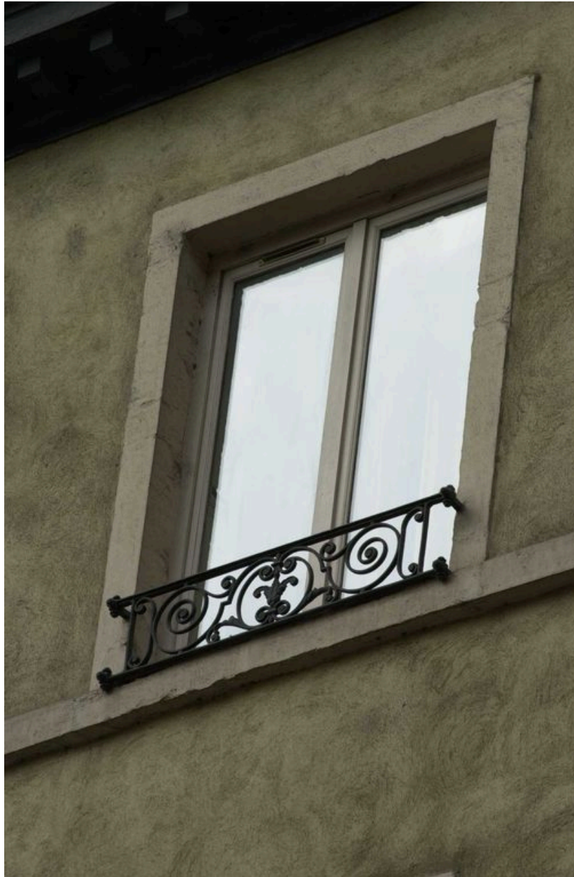
Détail d'un garde-corps, 3e étage Grande rue de la Guillotière
