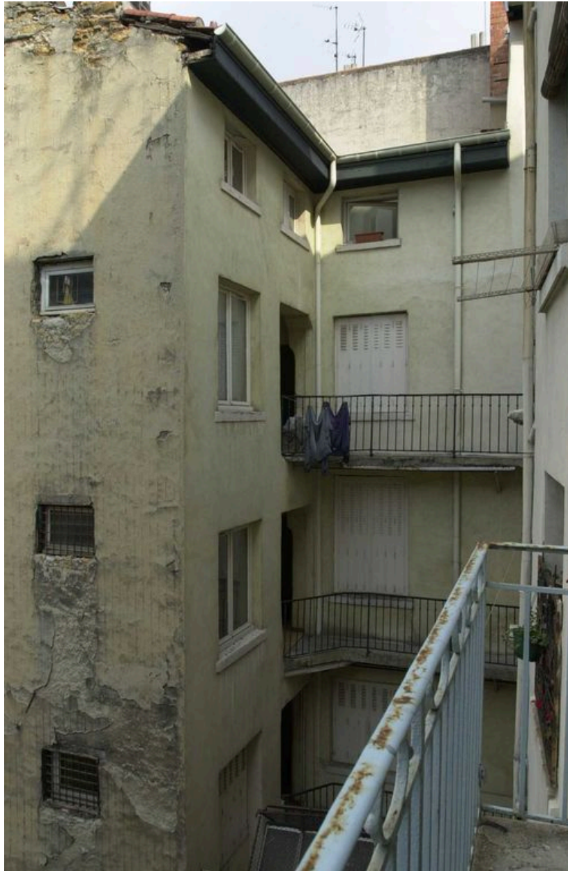
Vue des coursières sur 3 étages à l'arrière de l'immeuble
