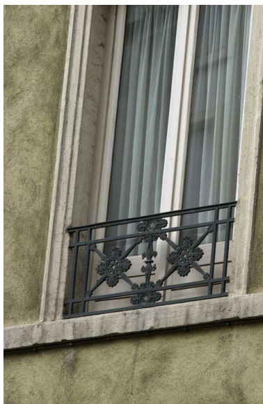
Détail d'un garde-corps, 2e étage Grande rue de la Guillotière IVR82_20026902812NUCA
