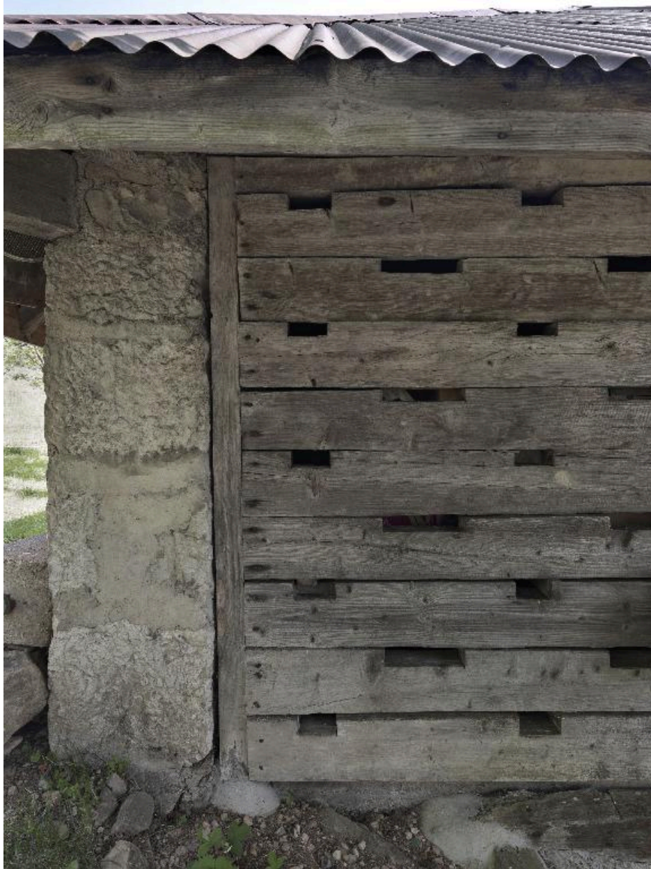
Vue du mur en madrier du freidi.
