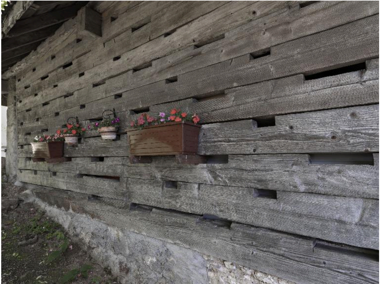
Vue du mur en madrier du freidi.
