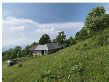
Vue générale depuis le sud-ouest (sortie de l'étable). Phot. Eric Dessert IVR82_20137302079NUCA
