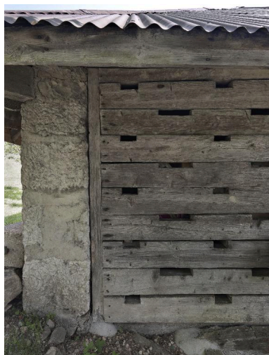
Vue du mur en madrier du freidi. Phot. Eric Dessert IVR82_20137302077NUCAQ
