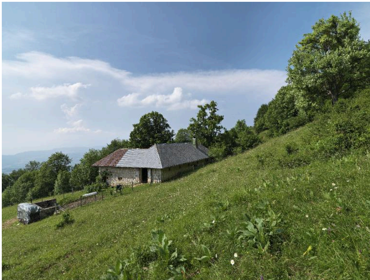
Vue générale depuis le sud-ouest (sortie de l'étable).
