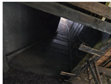
Vue intérieure : salle de fabrication, conduit de la cheminée. Phot. Eric Dessert IVR82_20137302070NUCAQ
