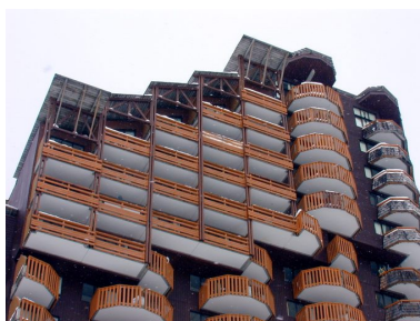
Façade sud. Détail des niveaux supérieurs de la partie est Phot. Jean-François Lyon-Caen, Phot. C. Salomon-Pelen IVR82_20087401316NUCA
