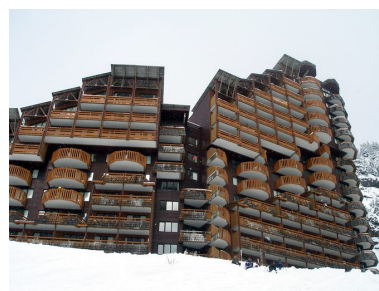
Façade sud Phot. Jean-François Lyon-Caen, Phot. C. Salomon-Pelen IVR82_20087401314NUCA
