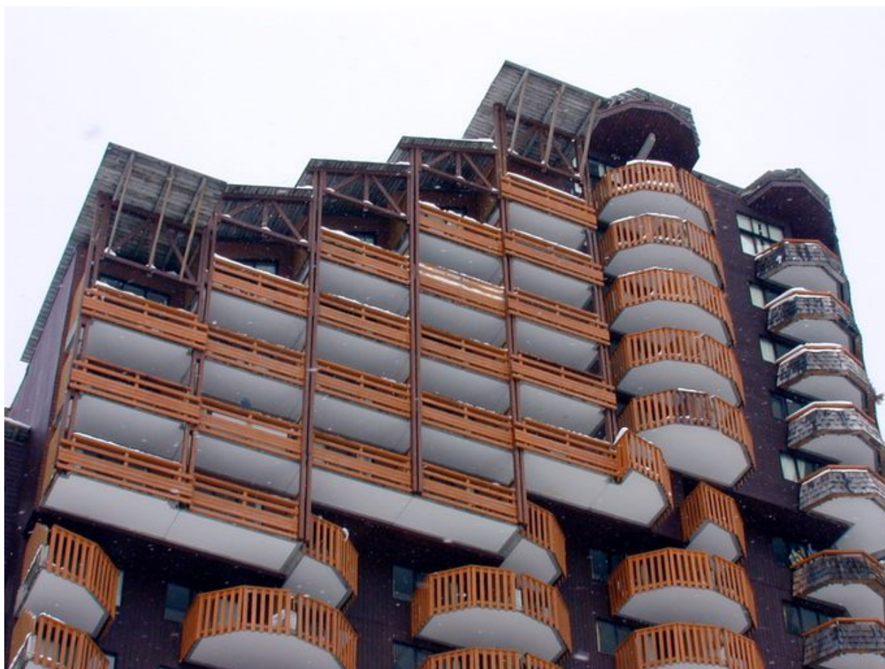
Façade sud. Détail des niveaux supérieurs de la partie est
