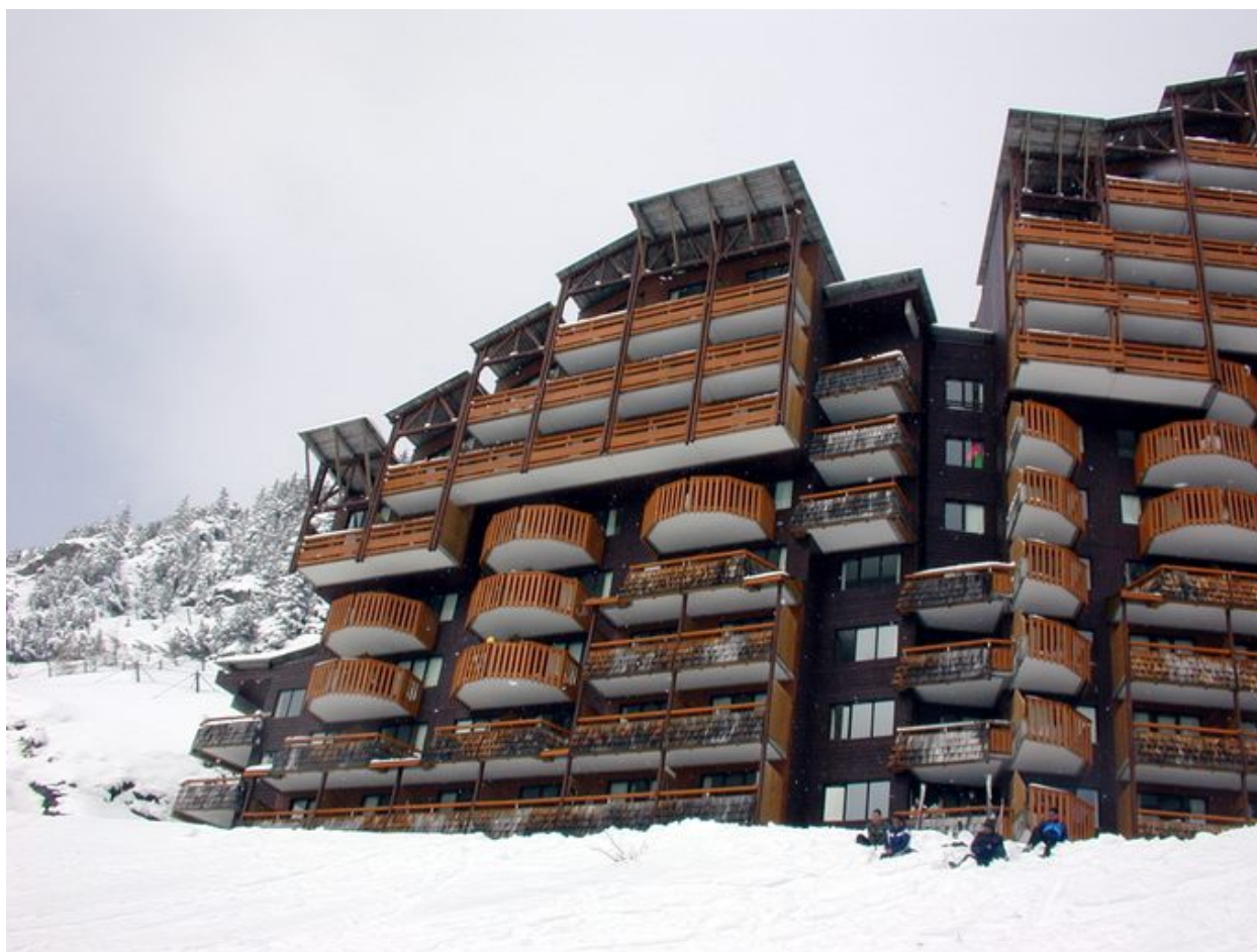
Façade sud. La partie ouest
