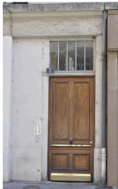
Vue rapprochée de la porte d'entrée Phot. Catherine Guégan IVR82_20156900964NUCA
