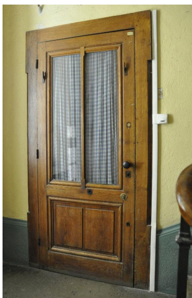
Vue intérieure : une porte palière Phot. Catherine Guégan IVR82_20156900967NUCA
