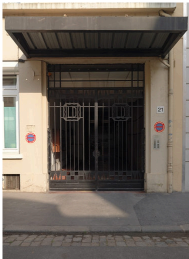
Entrée principale avec auvent et ferronnerie en décor L D : Ligne Droite Phot. Martial Couderette IVR82_20096900316NUCA
