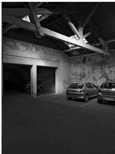
Détail charpente bois rez-de-chaussée Phot. Martial Couderette IVR82_20096900302NUC
