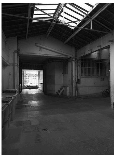
Vue d'ensemble des espaces du rez- de-chaussée actuellement garage Phot. Martial Couderette IVR82_20096900307NUC
