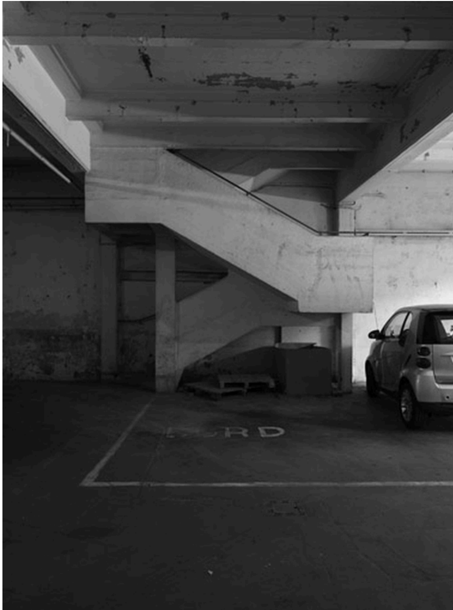
Escalier technique du rez-de-chaussée au 1er étage
