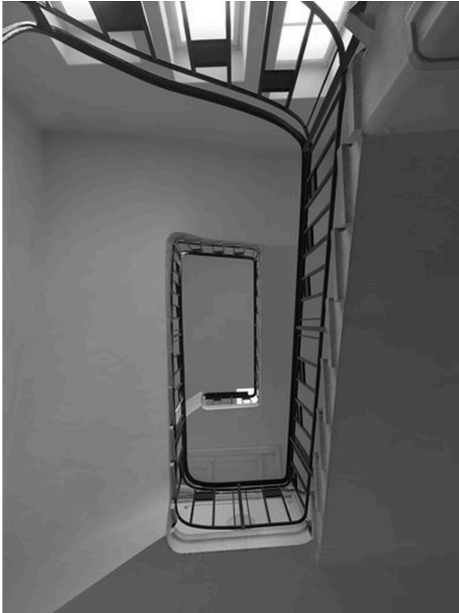
Vue d'ensemble de l'escalier principal
