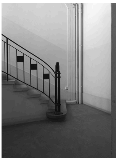
Détail escalier Phot. Martial Couderette IVR82_20096900315NUC
