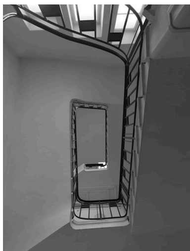
Vue d'ensemble de l'escalier principal Phot. Martial Couderette IVR82_20096900314NUC
