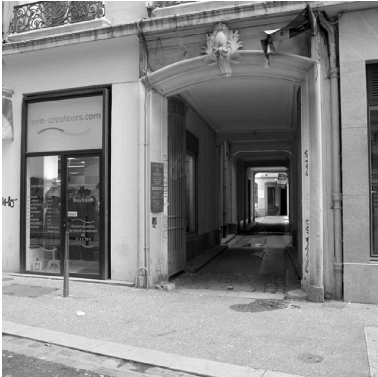
Entrée principale, rue Romarin
