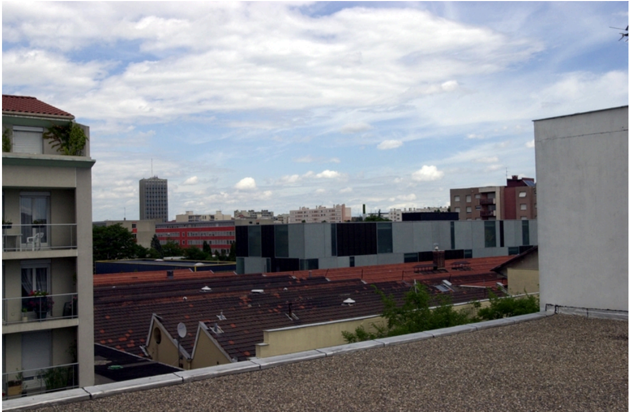
Vue zénitale toiture
