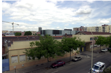
Vue générale du site est-ouest de la rue Bataille Phot. Nadine Halitim-Dubois IVR82_20016900626NUCA
