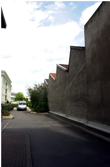
Vue sud-ouest façade et toit shed Phot. Nadine Halitim-Dubois IVR82_20016900628NUCA
