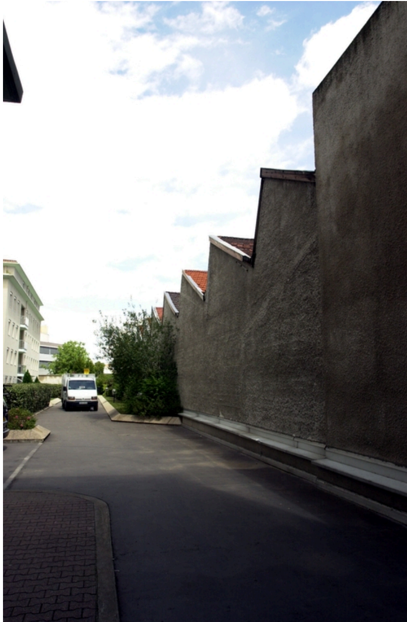
Vue sud-ouest façade et toit shed
