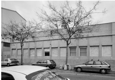
Vue générale sud Phot. Martial Couderette IVR82_20016903167P
