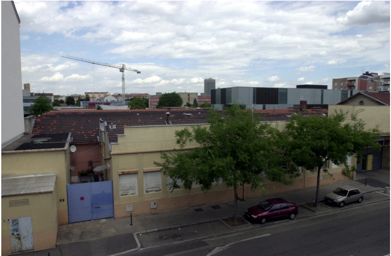
Vue d'ensemble façade sud
