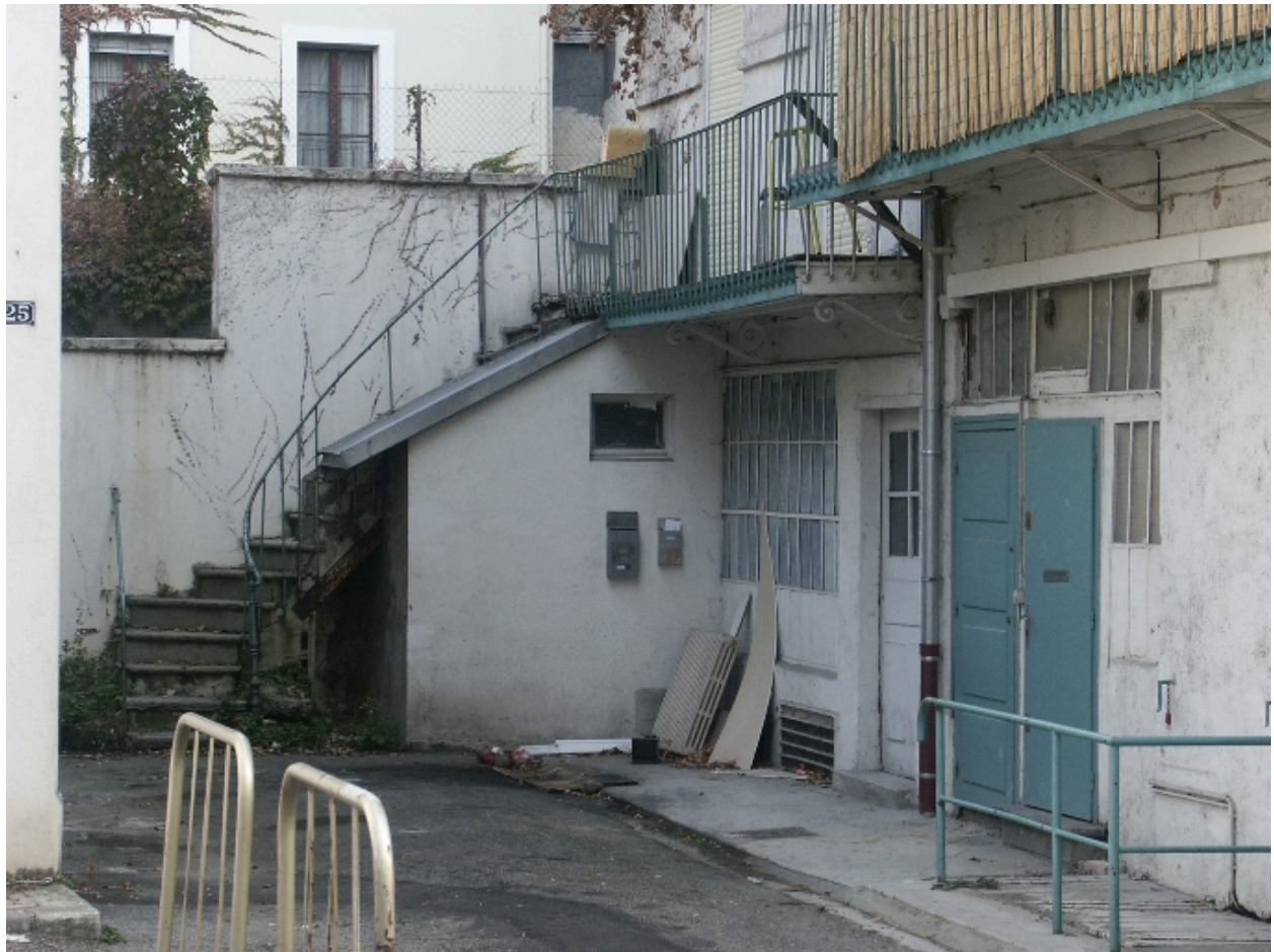
Détail de la façade sur cour
