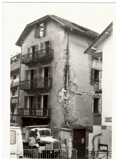
Vue du bâtiment nord, maison Jarrier Repro. François Fouger IVR82_20077300826NUCB
