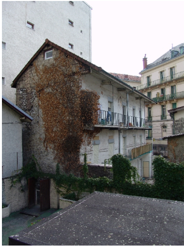
Vue générale depuis l'est Phot. François Fouger IVR82_20057300762NUCA
