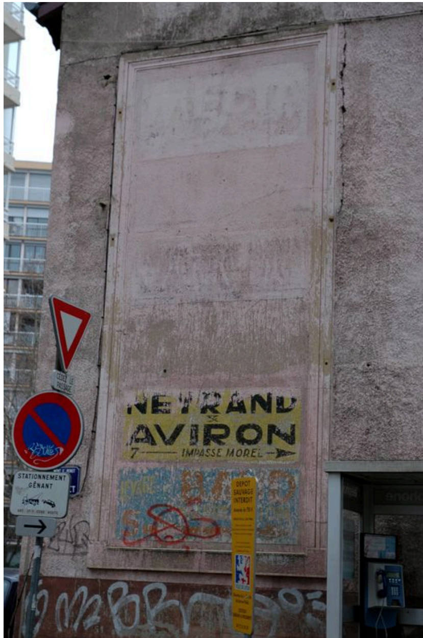
Détail de la publicité sur l'élévation latérale
