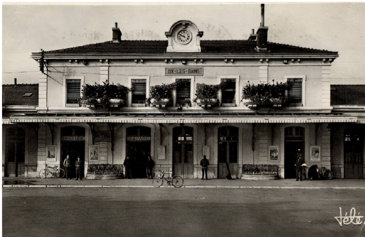
La façade du bâtiment central
