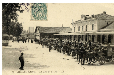
La gare vue du nord Repro. François Fouger IVR82_20077300134NUCB
