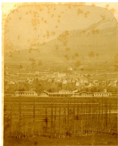
Vue dans le site prise de l'ouest Repro. François Fouger IVR82_20077300142NUCB
