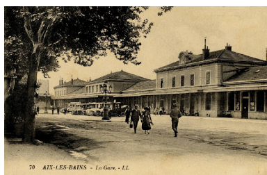
Vue d'ensemble prise du nord-est Repro. François Fouger IVR82_20077300137NUCB
