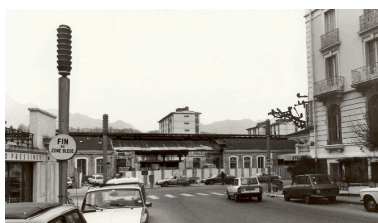
Travaux sur le bâtiment central vus depuis l'avenue Charles-de-Gaulle Repro. François Fouger IVR82_20077300141NUCB
