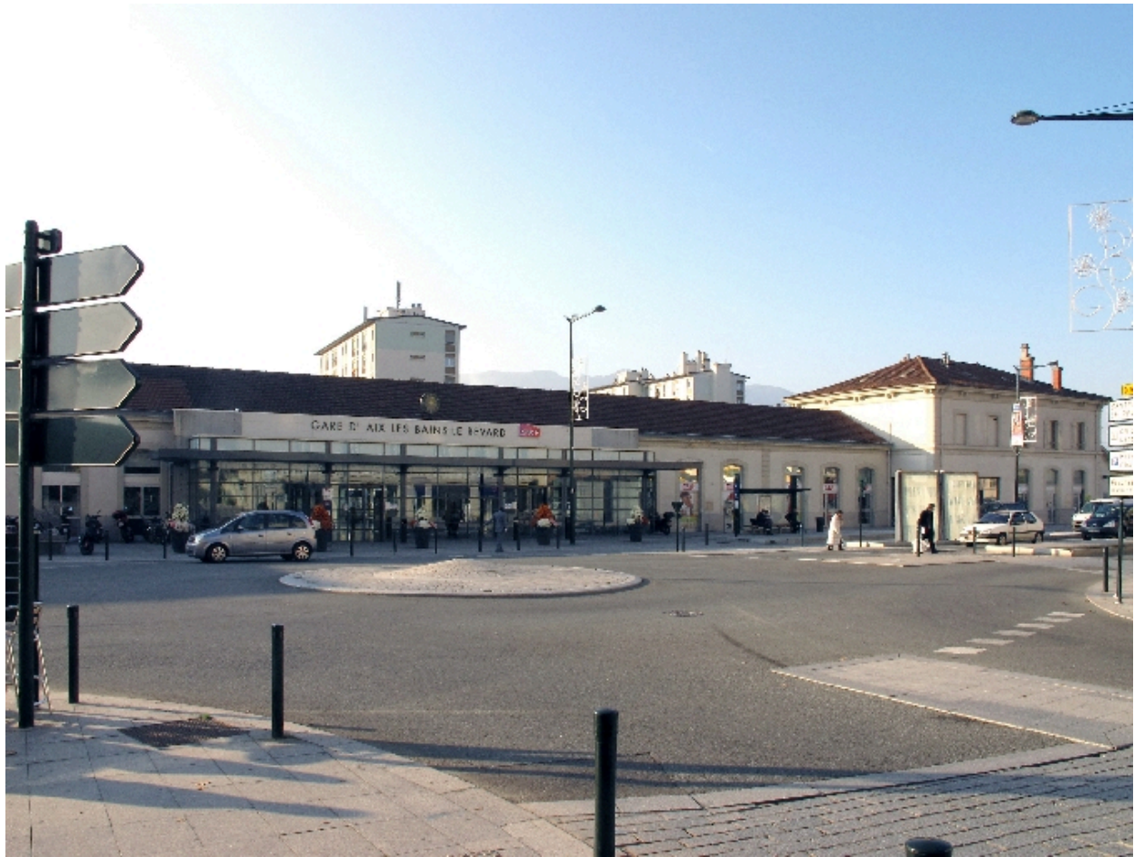
Elévations principales après les travaux de 2010
