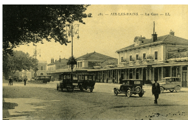
Façades antérieures du bâtiment des voyageurs Repro. François Fouger IVR82_20077300420NUCB
