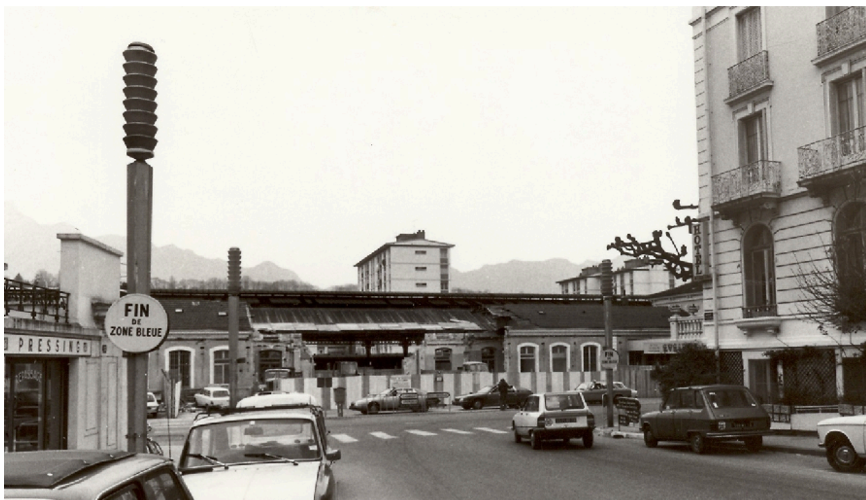
Travaux sur le bâtiment central vus depuis l'avenue Charles-de-Gaulle
