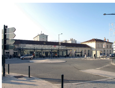
Elévations principales après les travaux de 2010 Phot. François Fouger IVR82_20127300122NUCA
