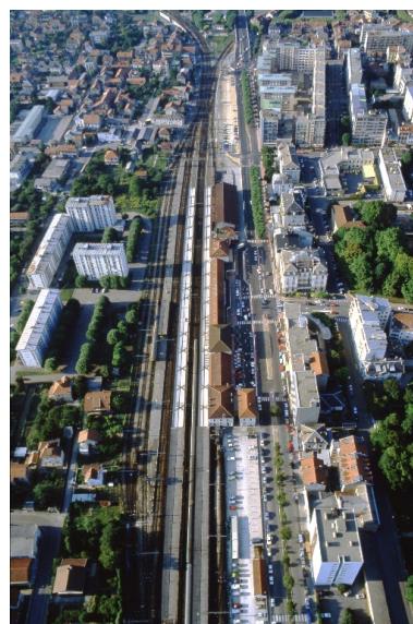
Vue aérienne, 1985 Repro. François Fouger IVR82_20127301047NUCB
