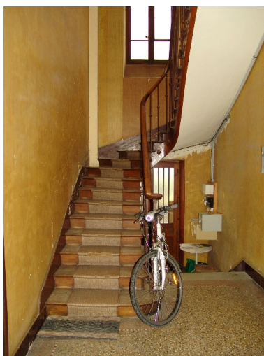
Départ de l'escalier Phot. François Fouger IVR82_20077300303NUCA
