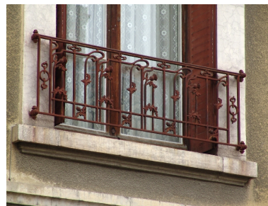
Détail d'un garde-corps Phot. François Fouger IVR82_20077300301NUCA
