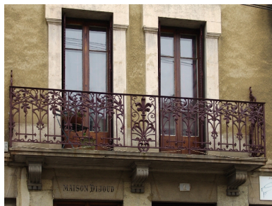
Détail d'un balcon double Phot. François Fouger IVR82_20077300300NUCA
