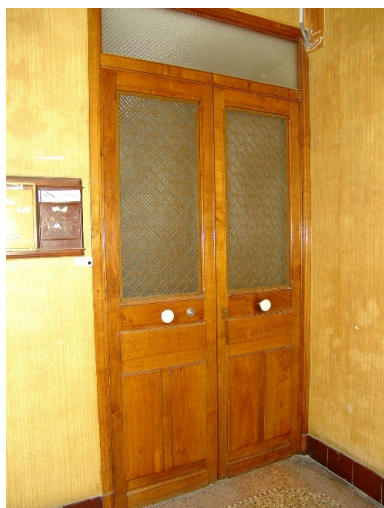
Porte donnant sur le vestibule Phot. François Fouger IVR82_20077300305NUCA
