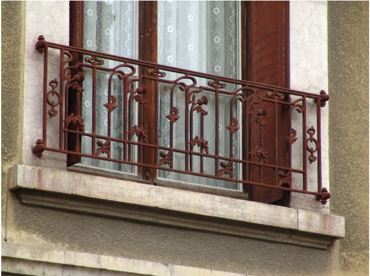
Détail d'un garde-corps
