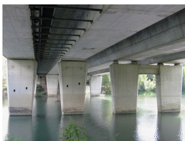
Tabliers vus de dessous (depuis la rive droite) Phot. I. Havard IVR82_20106902917NUCA
