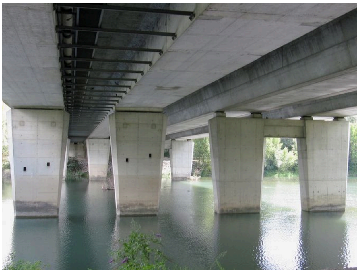
Tabliers vus de dessous (depuis la rive droite)
