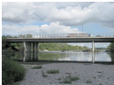
Vue générale, face aval Phot. I. Havard IVR82_20106907419NUCA
