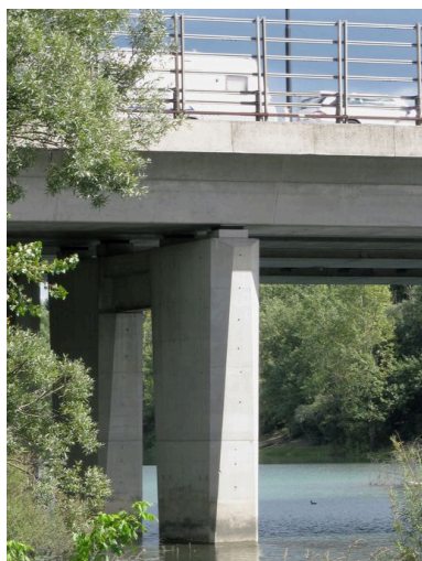
Piles (depuis la rive droite, aval) Phot. I. Havard IVR82_20106902920NUCA
