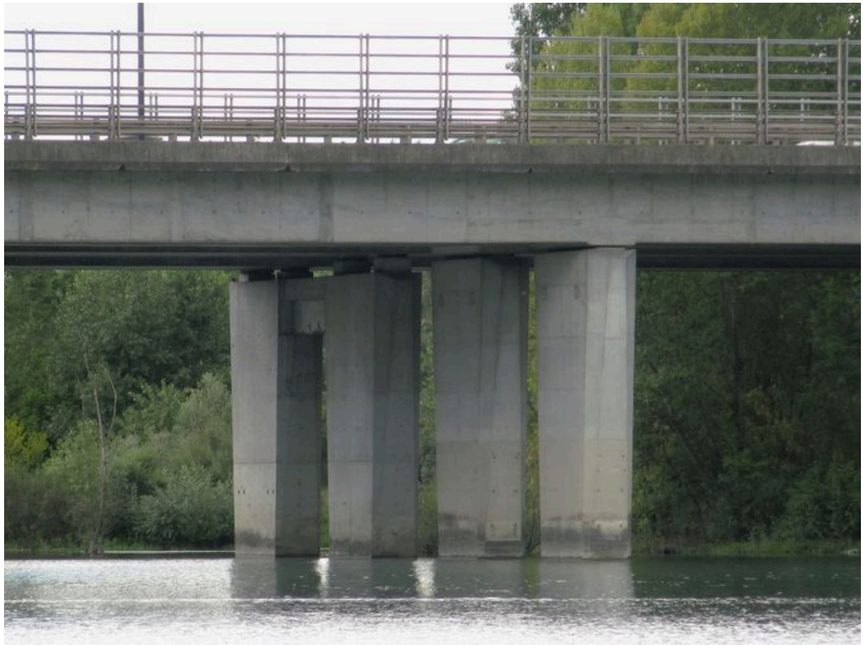
Piles (depuis la rive gauche, amont)
