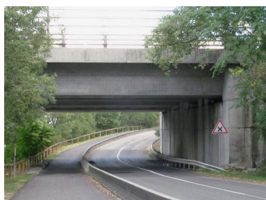
Extrémité rive gauche, face aval ; culée Phot. I. Havard IVR82_20106907421NUCA
