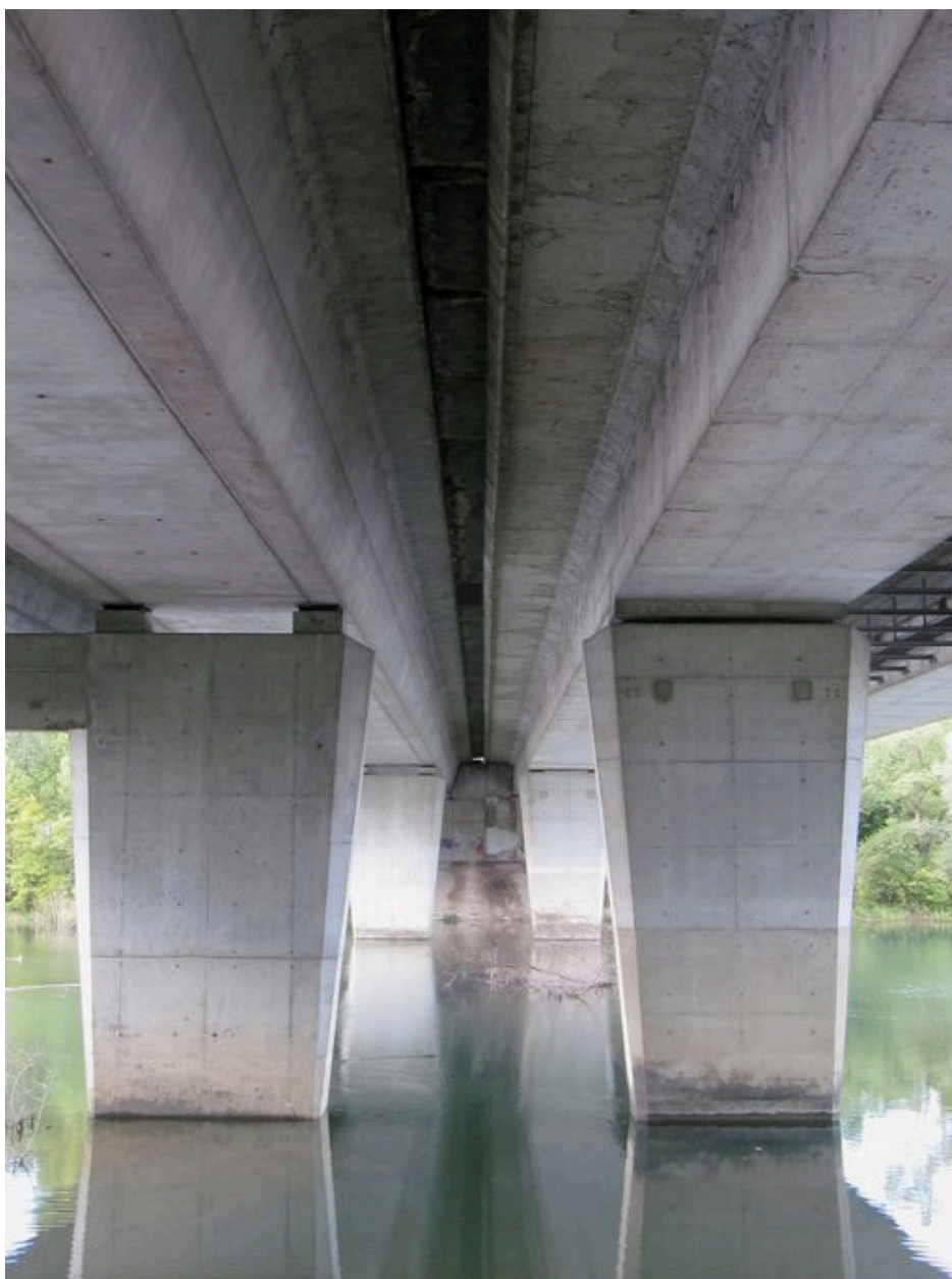
Tabliers vus de dessous : intersections des deux tabliers (depuis la rive gauche)
