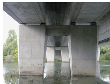
Pile double du tablier aval Phot. I. Havard IVR82_20106907420NUCA
