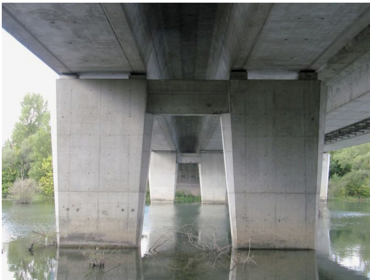
Pile double du tablier aval
