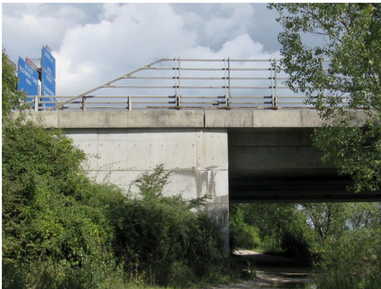
Culée de la rive droite, face aval
