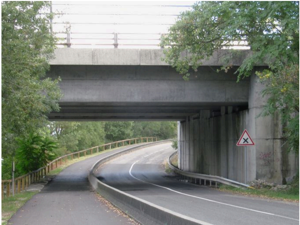
Extrémité rive gauche, face aval ; culée
