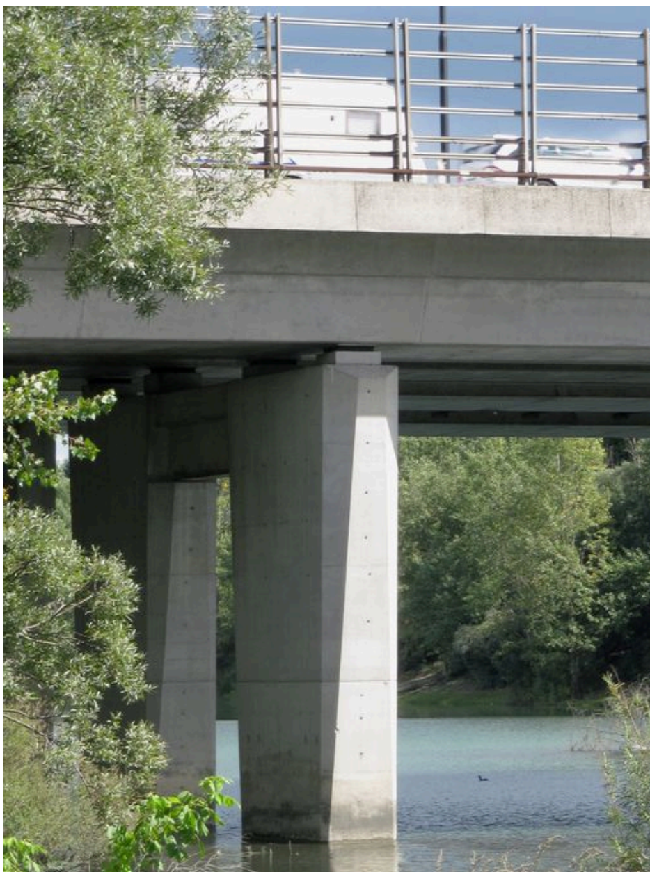
Piles (depuis la rive droite, aval)
