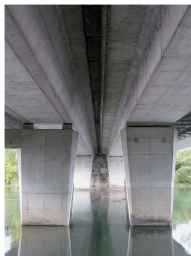
Tabliers vus de dessous : intersections des deux tabliers (depuis la rive gauche) Phot. I. Havard IVR82_20106902922NUCA
