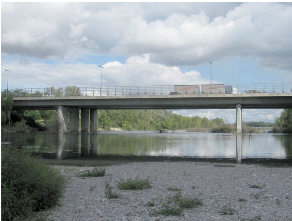
Vue générale, face aval
