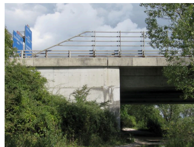
Culée de la rive droite, face aval Phot. I. Havard IVR82_20106902919NUCA
