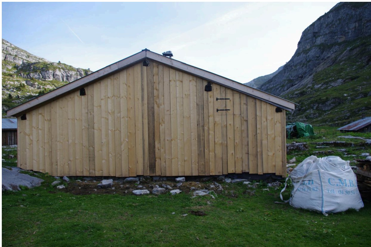
Vue du mur pignon nord
