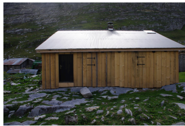
Vue de la façade antérieure est Phot. Samir Mahfoudi IVR84_20227402305NUCA
