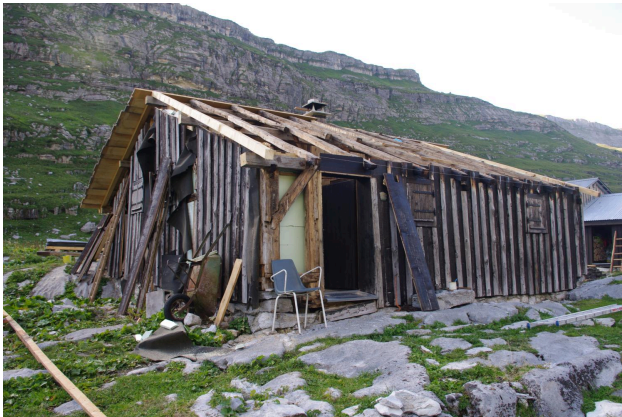
Prise de vue du chantier de 2016, autre vue de l'élévation sud-est (AP)
