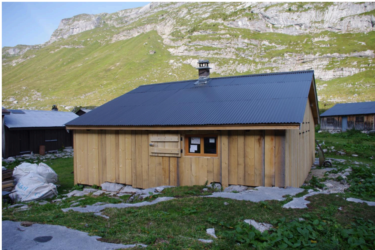
Vue d'ensemble du bâtiment
