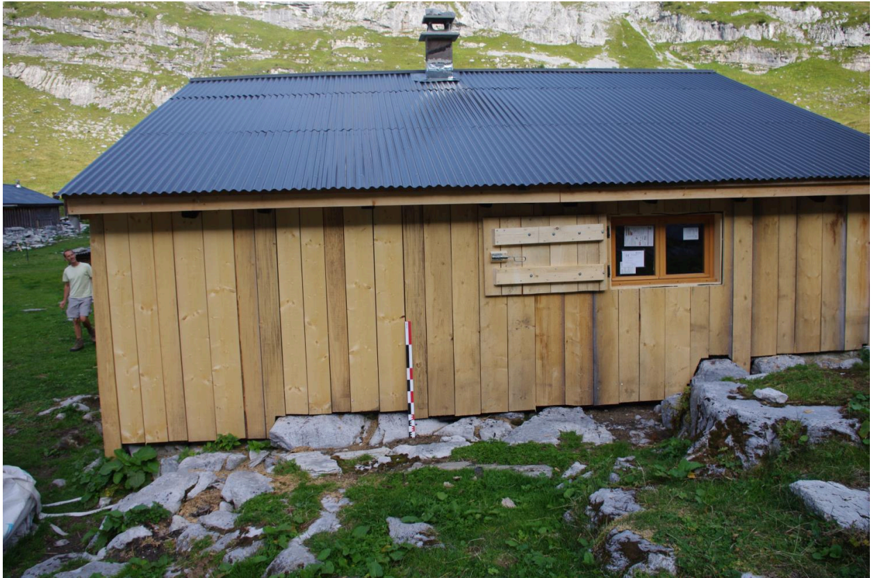
Vue de la façade postérieure ouest
