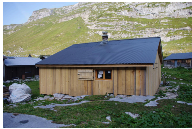
Vue d'ensemble du bâtiment Phot. Samir Mahfoudi IVR84_20227402304NUCA
