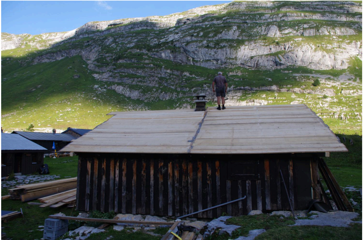
Prise de vue du chantier de 2016, vue de la façade postérieure ouest (AP)
