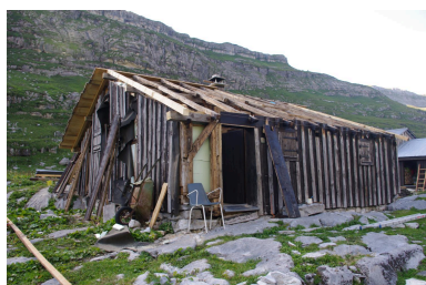
Prise de vue du chantier de 2016, vue du mur pignon sud (AP) IVR84_20227402295NUCA
