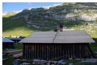
Prise de vue du chantier de 2016, vue générale du bâtiment (AP) IVR84_20227402297NUCA
