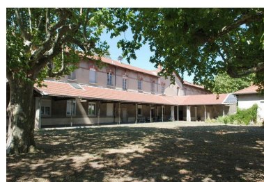
Bâtiment 456-457, façade postérieure (est), partie sud
