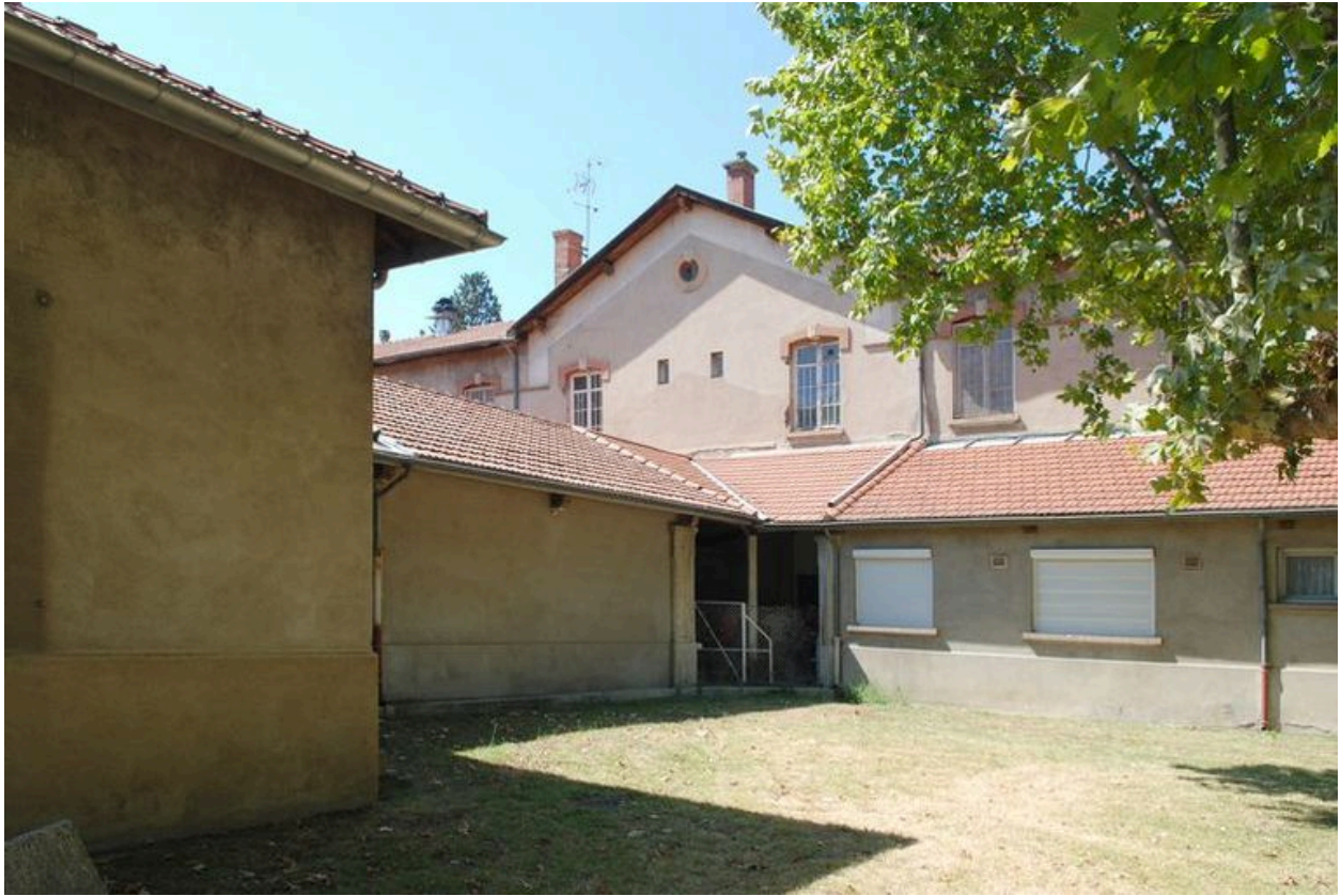
Bâtiment 456-457, façade postérieure (est), détail du pignon central : baies avec arcs segmentaire et oculus en briques
