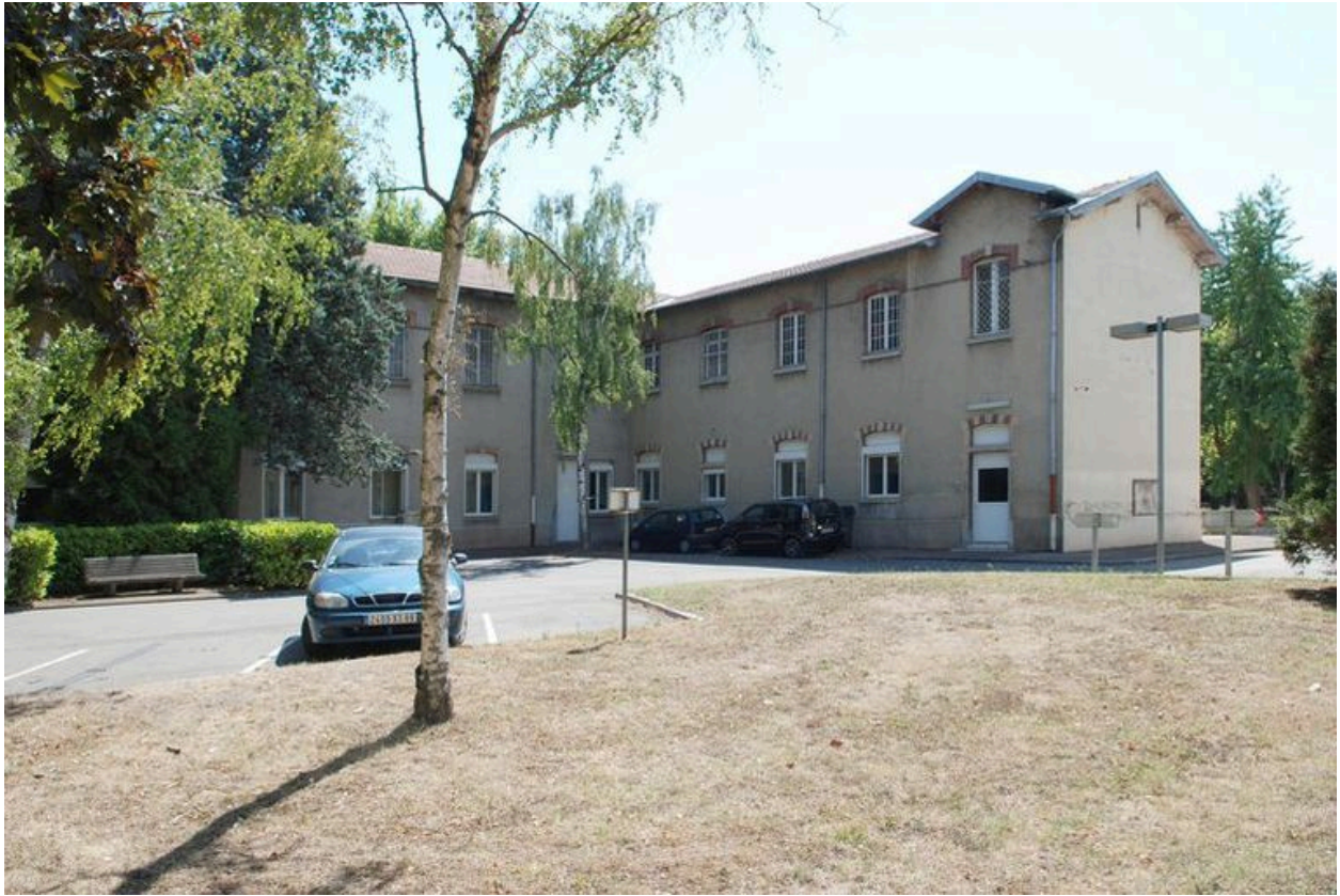
Bâtiment 456-457, façade principale (ouest), aile sud
