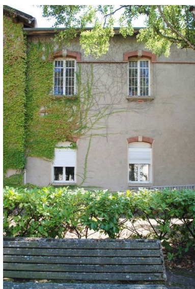
Bâtiment 456-457, façade principale (ouest), détail des baies : arcs segmentaires en briques et clés en pierre Phot. Catherine Guégan IVR82_20096904425NUCA
