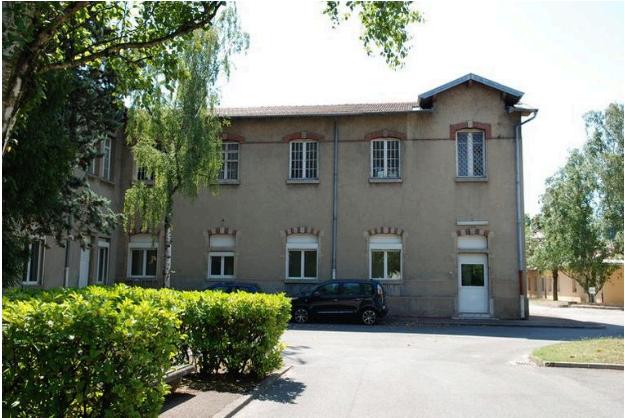
Bâtiment 456-457, façade principale (ouest), aile sud
