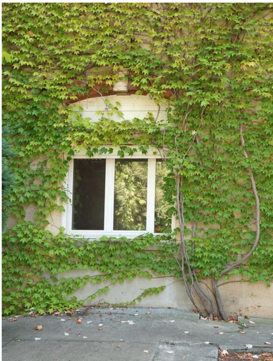
Bâtiment 456-457, façade principale (ouest), détail d'une baie
