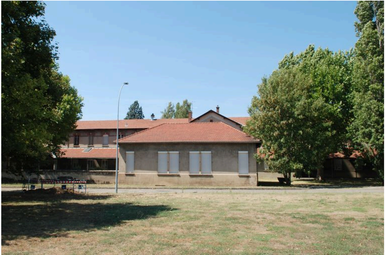
Bâtiment 456-457, façade postérieure (est) : au centre, l'ancienne buanderie remaniée
