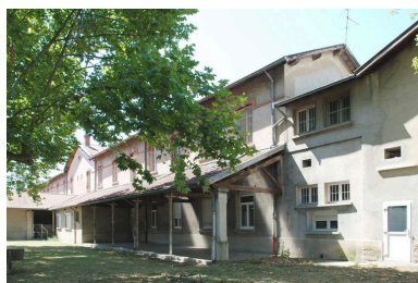
Bâtiment 456-457, façade postérieure (est), partie nord Phot. Catherine Guégan IVR82_20096904434NUCA
