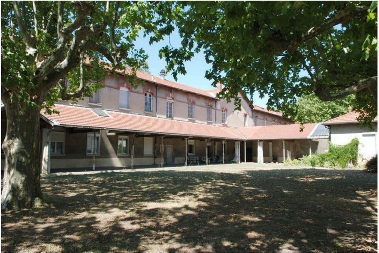
Bâtiment 456-457, façade postérieure (est), partie sud
