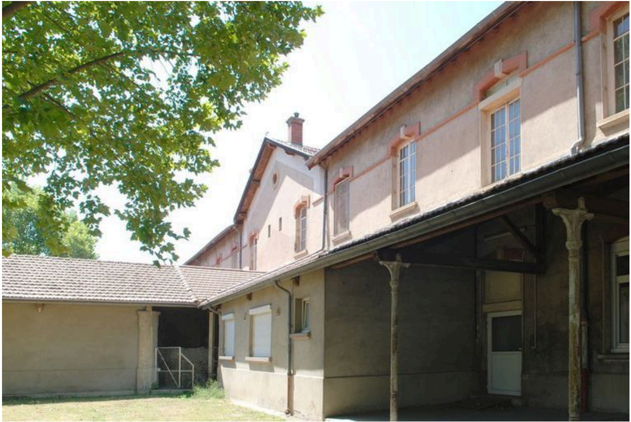
Bâtiment 456-457, façade postérieure (est), détail du portique nord : colonnettes en fonte et piliers en pierre
