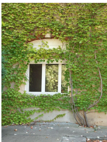
Bâtiment 456-457, façade principale (ouest), détail d'une baie Phot. Catherine Guégan IVR82_20096904426NUCA
