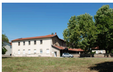
Bâtiment 456-457, aile sud, façade sud Phot. Catherine Guégan IVR82_20096904431NUCA
