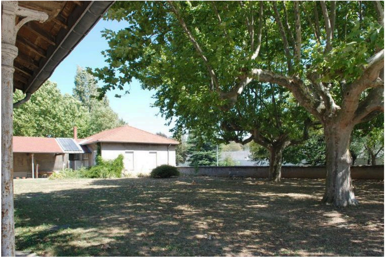
Bâtiment 456-457, façade postérieure (est) : l'ancienne buanderie remaniée
