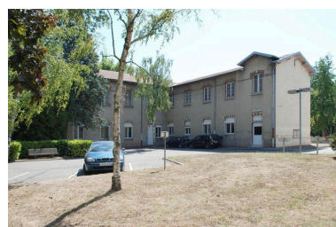
Bâtiment 456-457, façade principale (ouest), aile sud Phot. Catherine Guégan IVR82_20096904427NUCA
