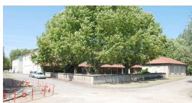
Bâtiment 456-457, vue d'ensemble depuis le sud-est Phot. Catherine Guégan
