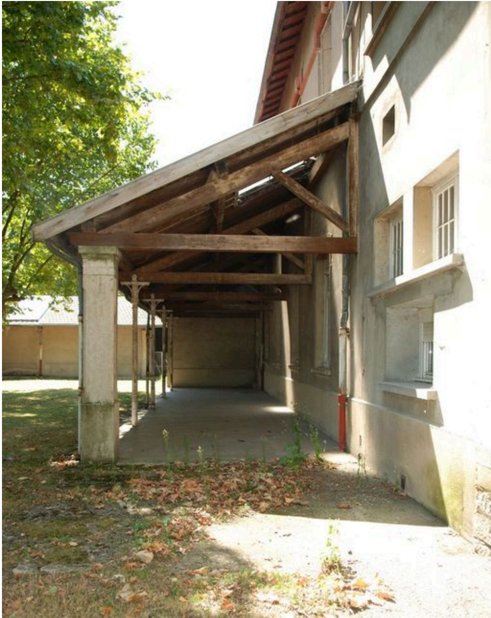
Bâtiment 456-457, façade postérieure (est), détail de la charpente du portique nord
