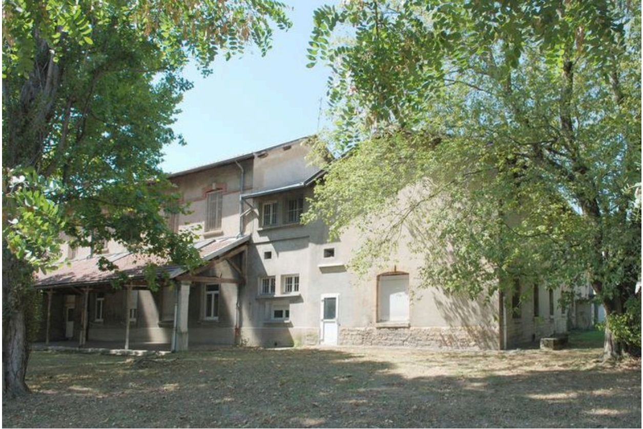
Bâtiment 456-457, façade postérieure (est) vue du nord-est. L'aile nord et le corps principal ont été reliés par un bâtiment à une date inconnue
