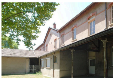
Bâtiment 456-457, façade postérieure (est), détail du portique nord : colonnettes en fonte et piliers en pierre Phot. Catherine Guégan IVR82_20096904435NUCA
