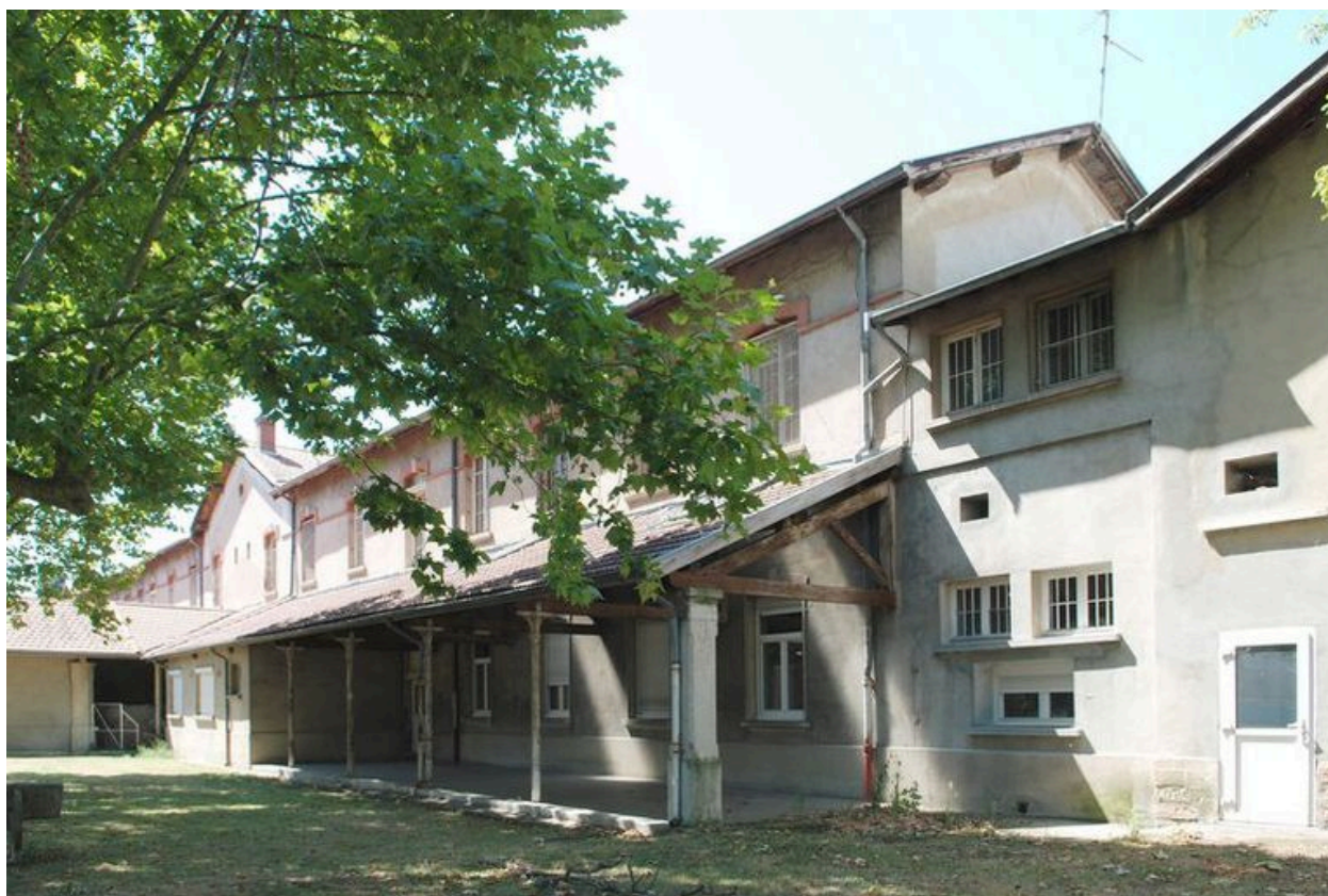
Bâtiment 456-457, façade postérieure (est), partie nord
