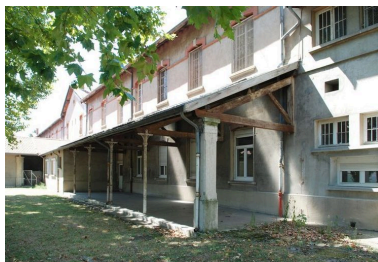
Bâtiment 456-457, façade postérieure (est), détail du portique sud Phot. Catherine Guégan IVR82_20096904504NUCA
