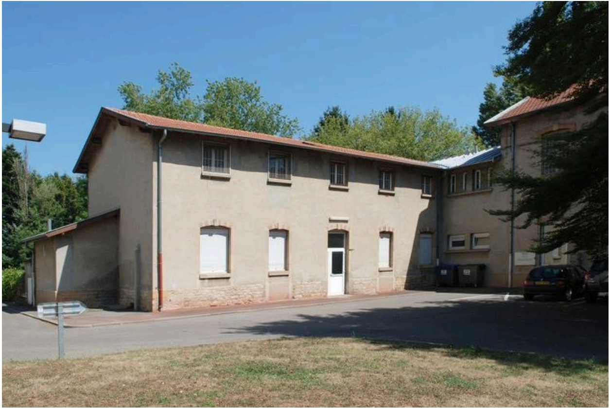
Bâtiment 456-457, façade principale (ouest), aile nord
