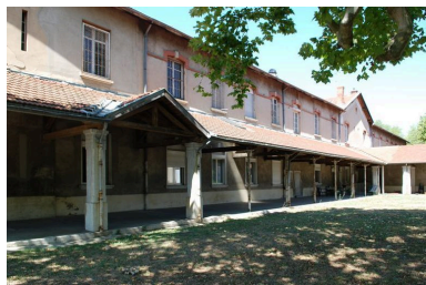
Bâtiment 456-457, façade postérieure (est), portique sud : piliers en pierre de taille et colonnettes en fonte Phot. Catherine Guégan IVR82_20096904503NUCA
