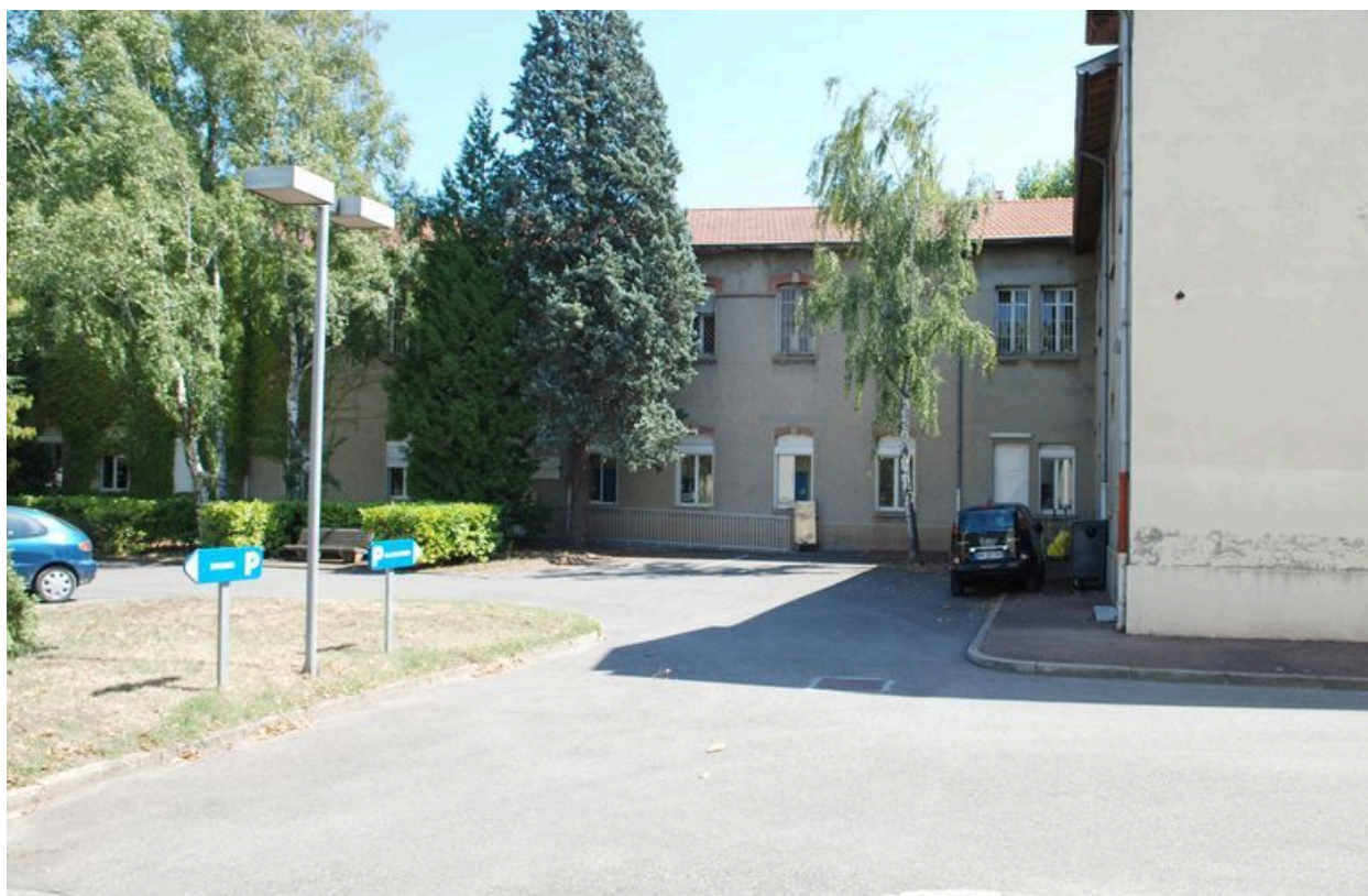
Bâtiment 456-457, façade principale (ouest), corps principal sud
