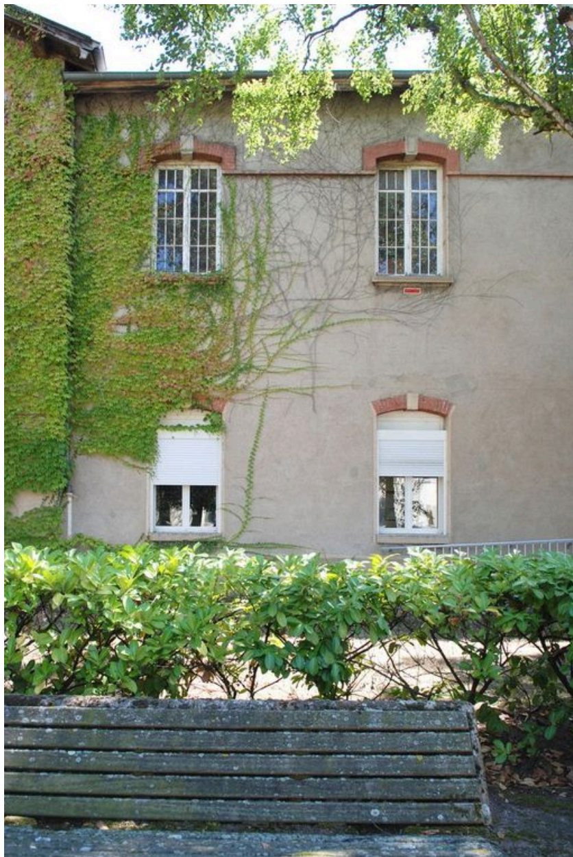
Bâtiment 456-457, façade principale (ouest), détail des baies : arcs segmentaires en briques et clés en pierre
