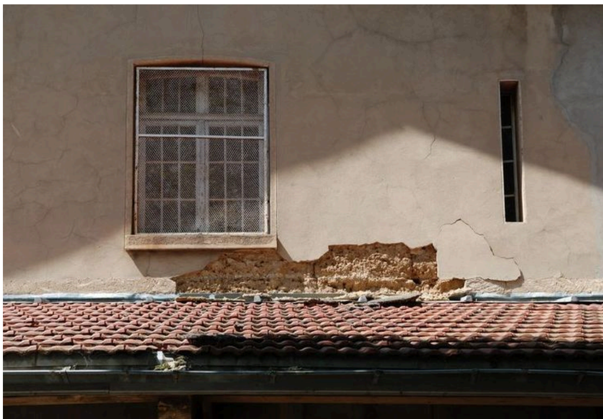
Bâtiment 456-457, façade postérieure (est) : mur en pisé
