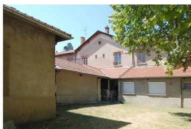
Bâtiment 456-457, façade postérieure (est), détail du pignon central : baies avec arcs segmentaire et oculus en briques Phot. Catherine Guégan IVR82_20096904437NUCA
