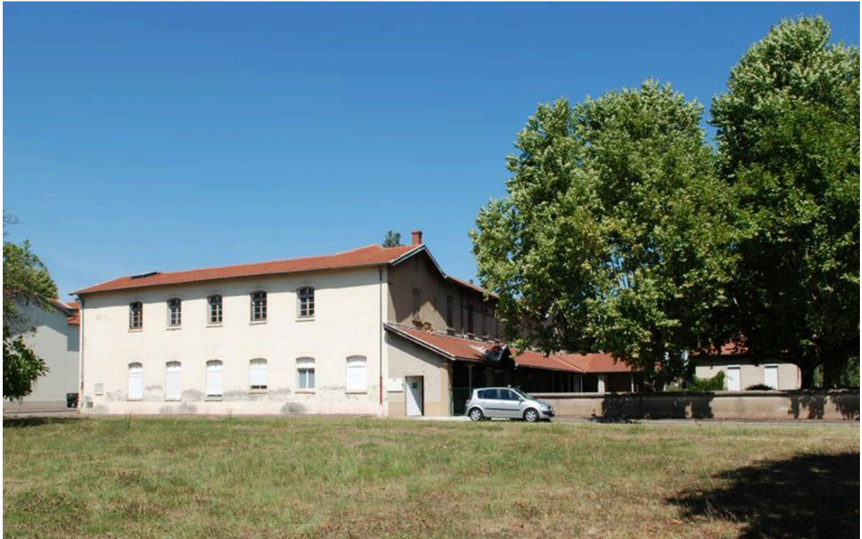
Bâtiment 456-457, aile sud, façade sud
