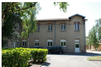
Bâtiment 456-457, façade principale (ouest), aile sud Phot. Catherine Guégan IVR82_20096904428NUCA
