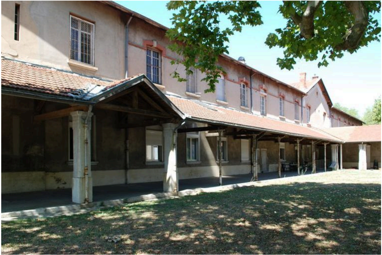
Bâtiment 456-457, façade postérieure (est), portique sud : piliers en pierre de taille et colonnettes en fonte
