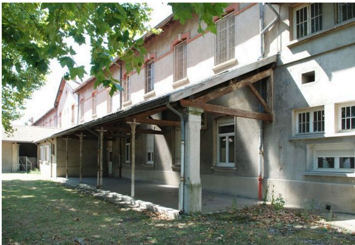
Bâtiment 456-457, façade postérieure (est), détail du portique sud
