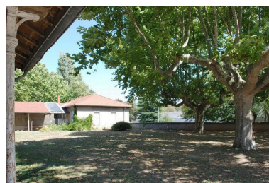
Bâtiment 456-457, façade postérieure (est) : l'ancienne buanderie remaniée Phot. Catherine Guégan IVR82_20096904501NUCA
