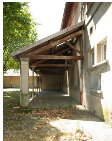
Bâtiment 456-457, façade postérieure (est), détail de la charpente du portique nord Phot. Catherine Guégan IVR82_20096904436NUCA
