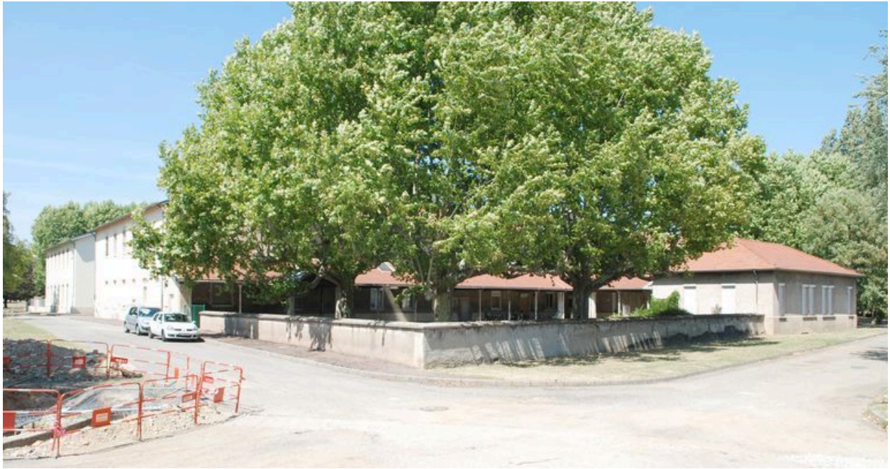
Bâtiment 456-457, vue d'ensemble depuis le sud-est
