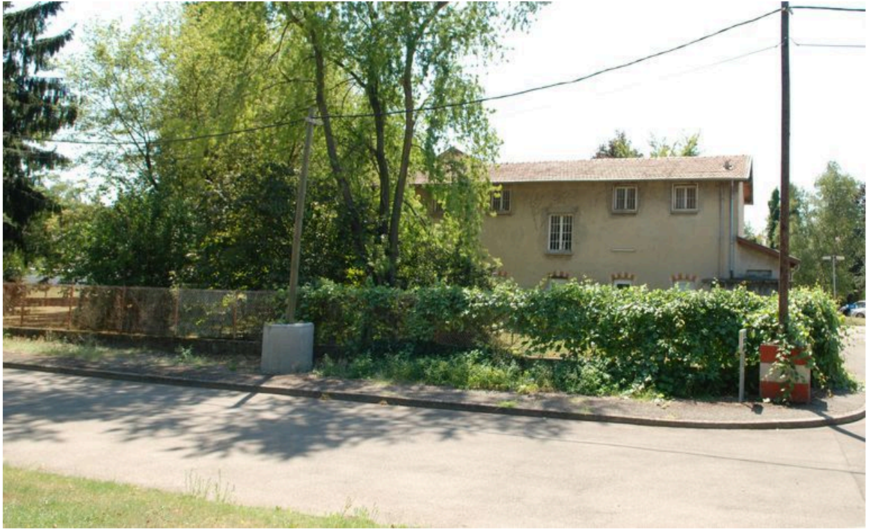
Bâtiment 456-457, aile nord, façade nord
