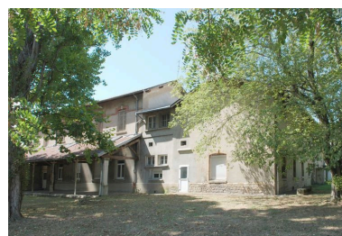
Bâtiment 456-457, façade postérieure (est) vue du nord-est. L'aile nord et le corps principal ont été reliés par un bâtiment à une date inconnue Phot. Catherine Guégan IVR82_20096904433NUCA
