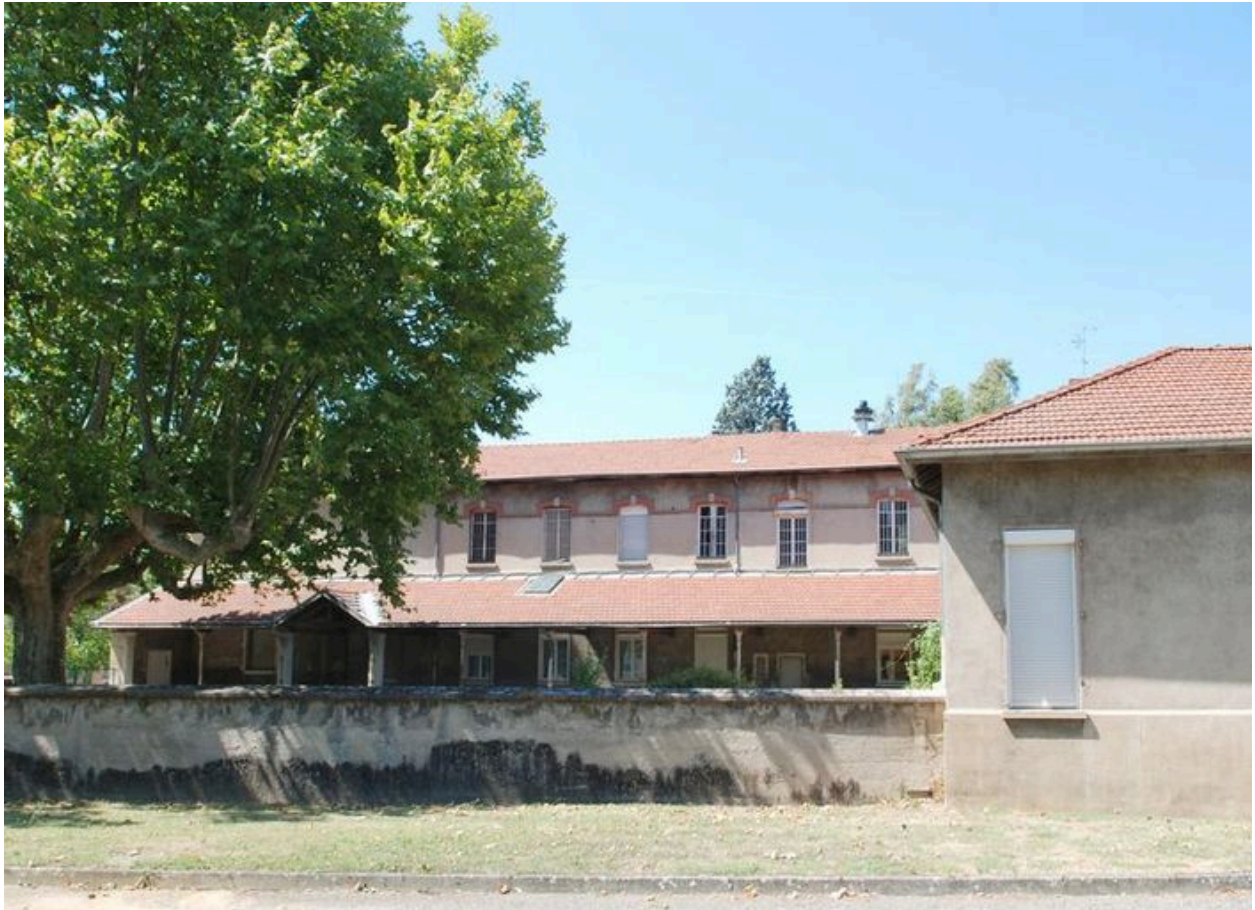
Bâtiment 456-457, façade postérieure (est), partie sud. A droite, ancien bâtiment de la buanderie
