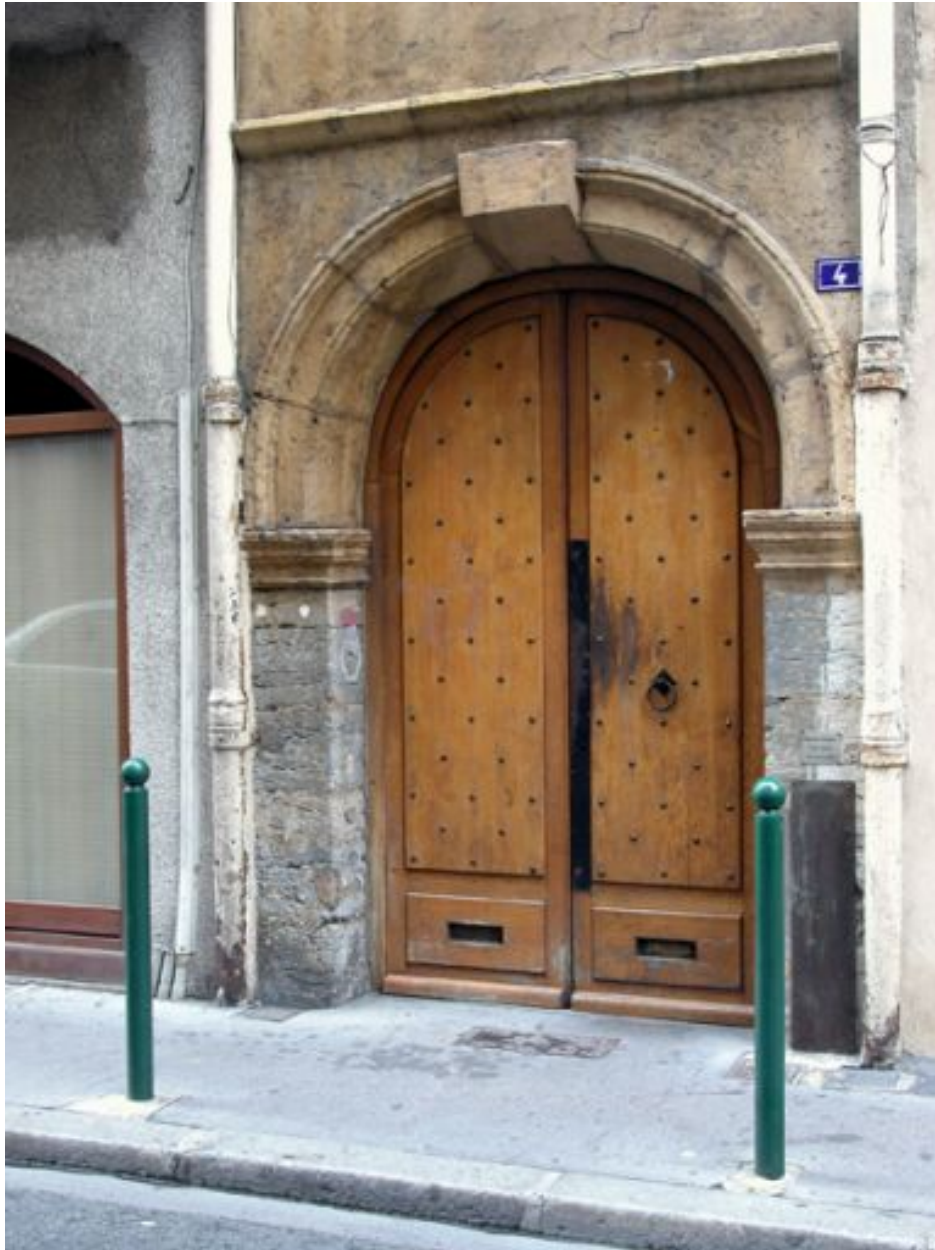
Façade principale rue Dubois, porte
