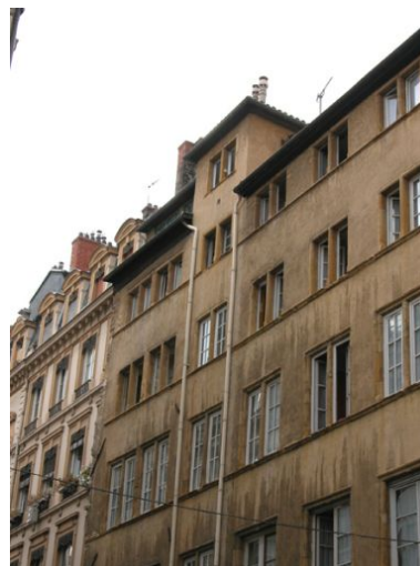
Façade principale rue Dubois, partie supérieure et pavillon d'escalier Phot. Bernard Ducouret IVR82_20046905742NUCA
