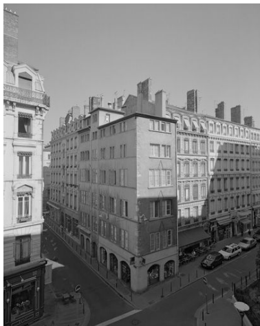
Vue générale des façades à mi-hauteur Phot. Eric Dessert IVR82_20056901744V
