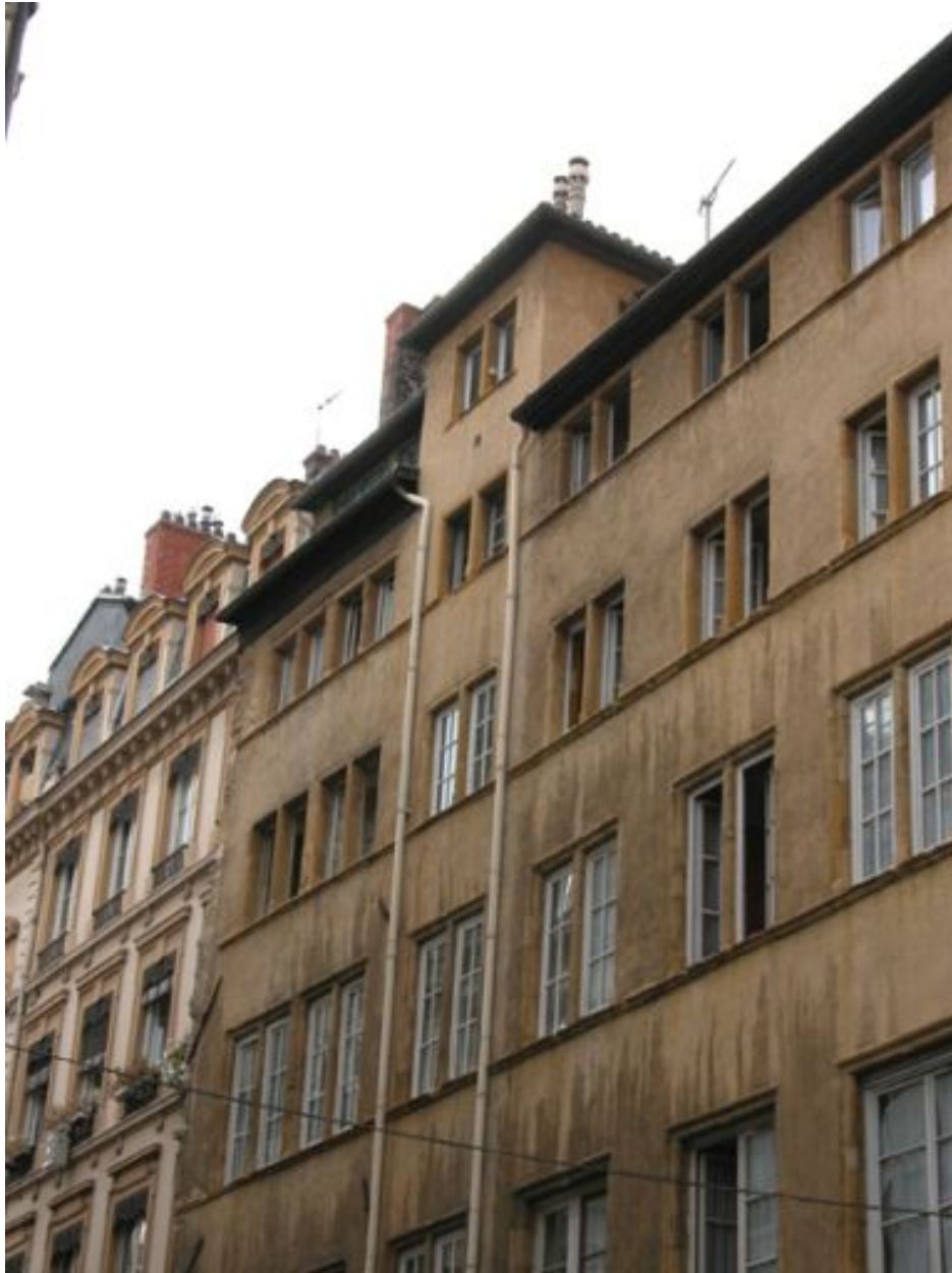
Façade principale rue Dubois, partie supérieure et pavillon d'escalier
