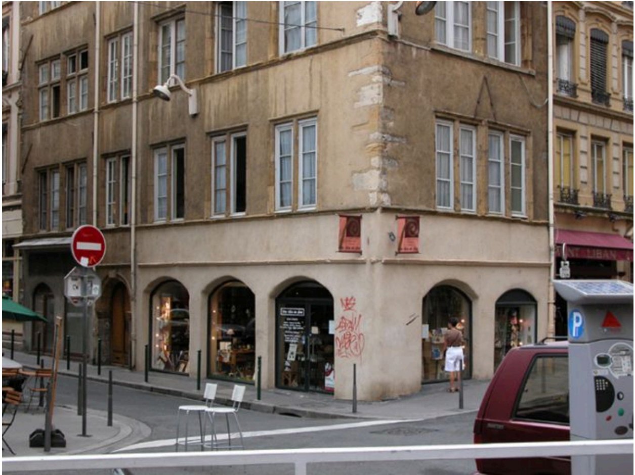
Façades sur rue, niveaux 1 et 2
