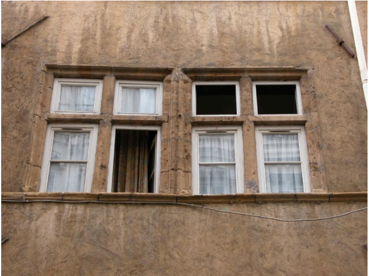
Façade principale rue Dubois, 2e niveau, 1ère et 2e fenêtres
