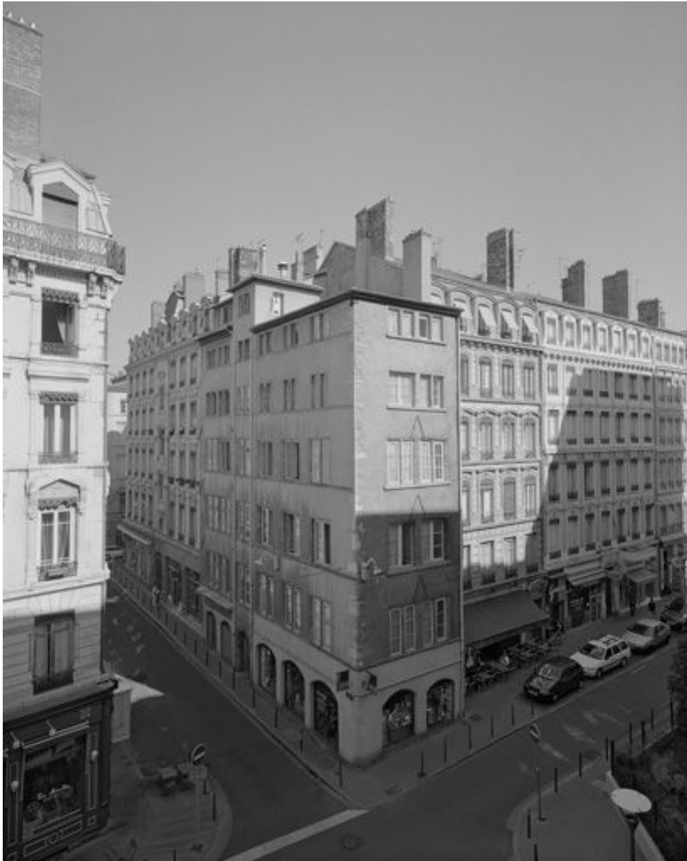
Vue générale des façades à mi-hauteur
