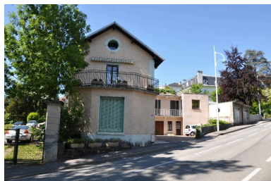
Vue d'ensemble prise depuis le sud-ouest Phot. Denys Harreau IVR82_20137300180NUCA
