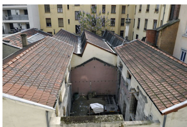
Bâtiments sur cours devant être démolis à moitié Phot. Julien Defillon IVR82_20106901003NUCA
