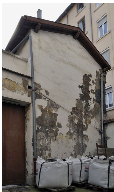
Bâtiment sur cour, à droite, devant être à moitié démolé. Phot. Julien Defillon IVR82_20106901002NUCA
