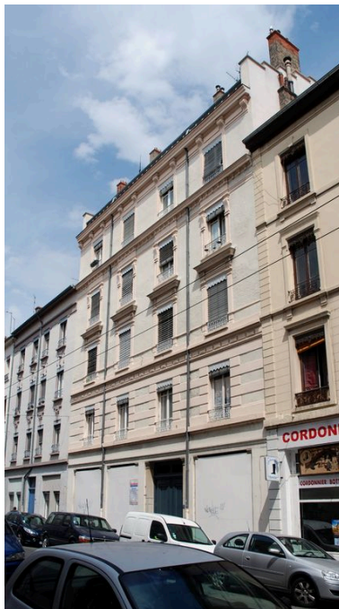
Élévation antérieure Phot. Catherine Guégan IVR82_20096900773NUCA
