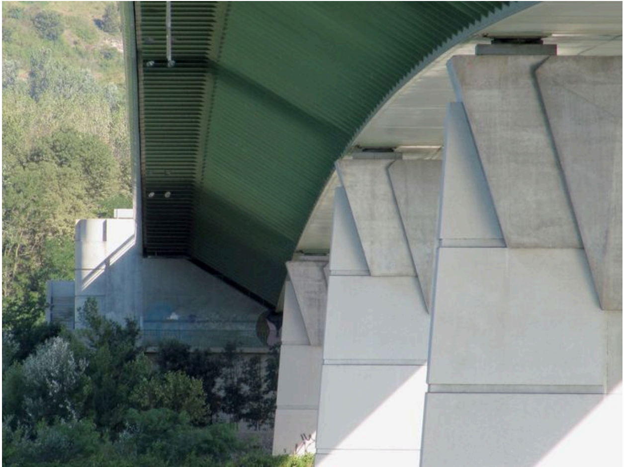
Tablier et piles, de côté, face aval, vue partielle (depuis la rive gauche)
