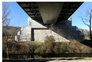
Culée droite, de dessous, vue générale (depuis la rive droite) Phot. G. Gellert IVR82_20100700280NUCA
