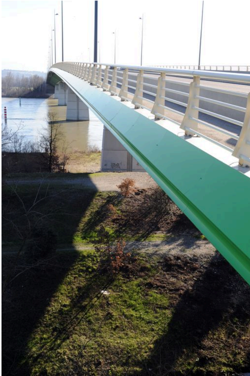
Vue partielle, de côté, tablier et parapet, face amont (depuis la rive droite)
