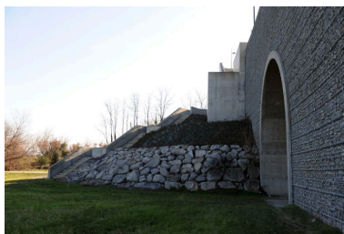
Culée droite, de côté, face amont, vue partielle : escalier d'accès (depuis la rive droite) Phot. G. Gellert IVR82_20100700282NUCA
