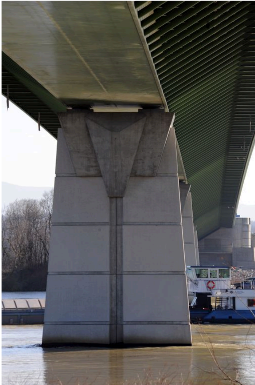
Pile, de côté, face aval, vue générale (depuis la rive droite)
