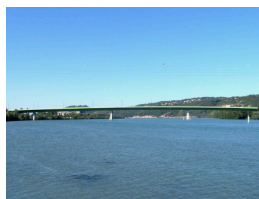
Vue générale, face amont (depuis la rive gauche) Phot. I. Havard IVR82_20100700110NUCA
