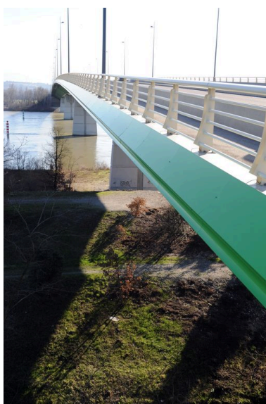
Vue partielle, de côté, tablier et parapet, face amont (depuis la rive droite) Phot. G. Gellert IVR82_20100700284NUCA
