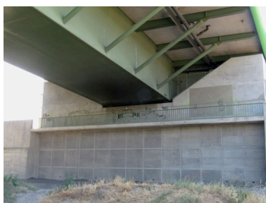
Culée gauche, de dessous, vue partielle : jonction avec le tablier (depuis la rive gauche) Phot. I. Havard IVR82_20100700118NUCA
