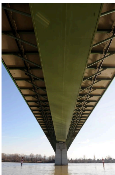
Vue partielle, de dessous, tablier et pile (depuis la rive droite) Phot. G. Gellert IVR82_20100700113NUCA
