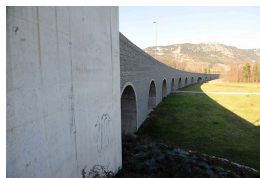
Rampe d'accès droite, face amont, vue générale (depuis la rive droite) Phot. G. Gellert IVR82_20100700112NUCA
