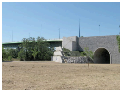
Culée droite, face amont, vue générale (depuis la rive droite) Phot. I. Havard IVR82_20100700111NUCA
