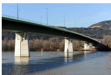
Vue partielle, face amont (depuis la rive gauche) Phot. G. Gellert IVR82_20100700114NUCA
