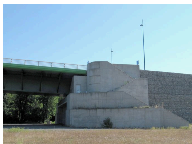
Culée gauche, face aval, vue générale (depuis la rive gauche) Phot. I. Havard IVR82_20100700281NUCA
