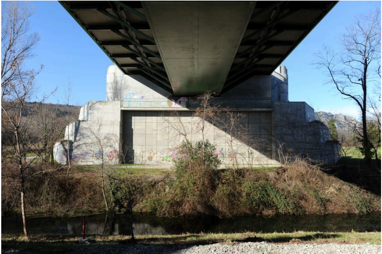
Culée droite, de dessous, vue générale (depuis la rive droite)
