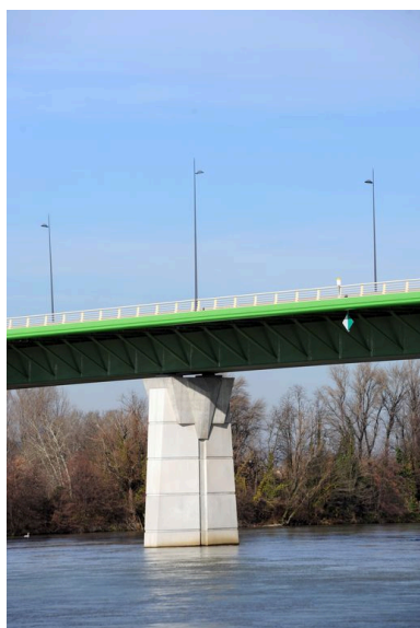
Pile, face aval, vue générale (depuis la rive gauche) Phot. G. Gellert IVR82_20100700115NUCA
