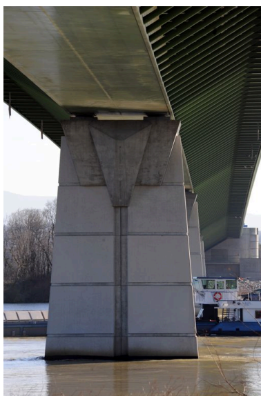
Pile, de côté, face aval, vue générale (depuis la rive droite) Phot. G. Gellert IVR82_20100700283NUCA
