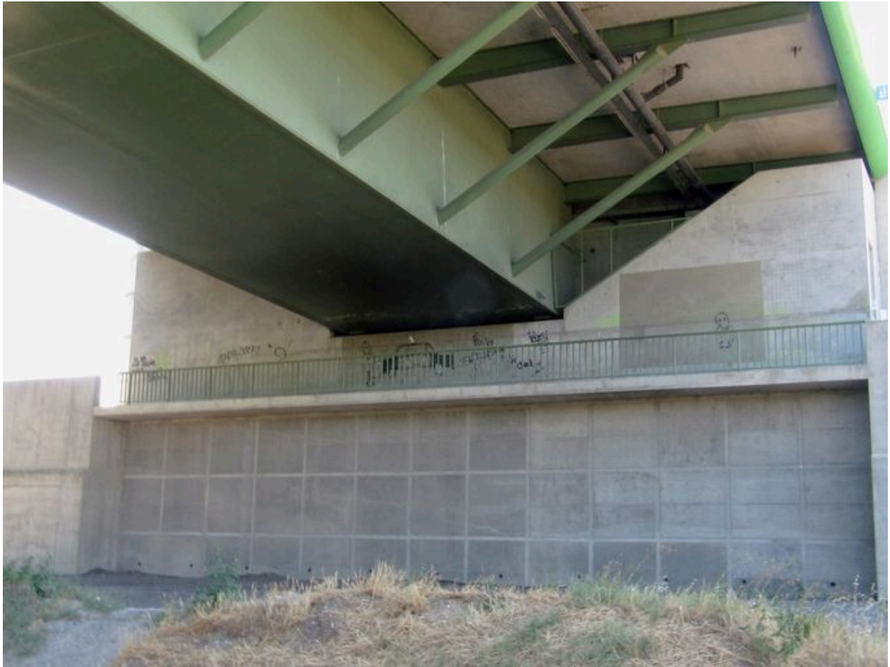
Culée gauche, de dessous, vue partielle : jonction avec le tablier (depuis la rive gauche)
