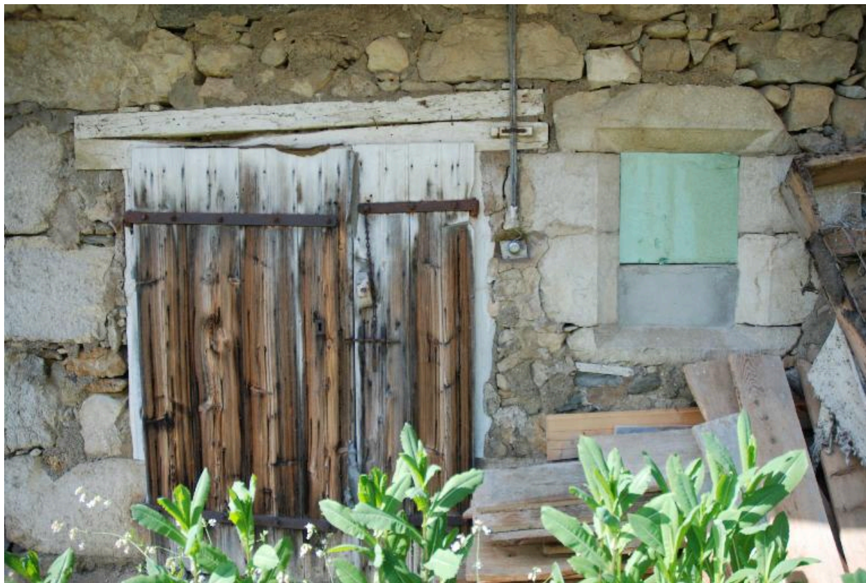
Les Vauthiers, vue de la ferme 2013 B4 466, non repérée. Détail des ouvertures.
