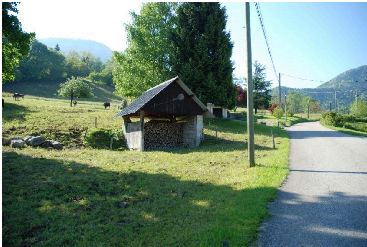
Les Granges, vue d'un ancien hangar à four à pain (four alsacien), puis bûcher (2013 B1 19), non repéré.
