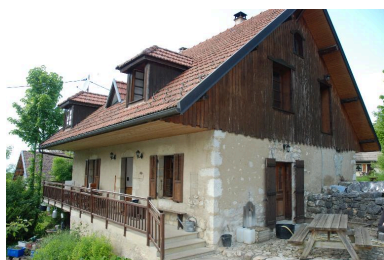
Les Vauthiers, vue du logis de la ferme 2013 B4 465 (non repérée), façade sur cour. Phot. Thierry Monnet IVR82_20147302414NUCA
