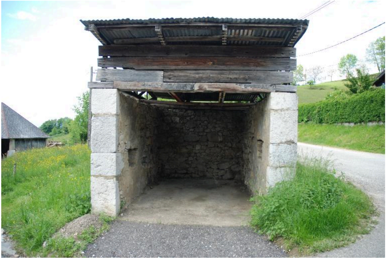
Les Vauthiers, vue du hangar de l'ancien four à pain (2013 B4 494).
