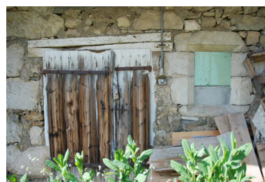
Les Vauthiers, vue de la ferme 2013 B4 466, non repérée. Détail des ouvertures. Phot. Thierry Monnet IVR82_20147302416NUCA
