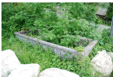
Les Vauthiers, vue de la fontaine-abreuvoir (2013 B4 382). Phot. Caroline Guibaud IVR82_20147302410NUCA
