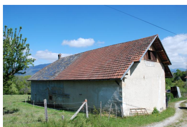
Vue arrière. Phot. Thierry Monnet IVR84_20207400705NUCA
