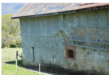
Vue arrière. Phot. Thierry Monnet IVR84_20207400706NUCA
