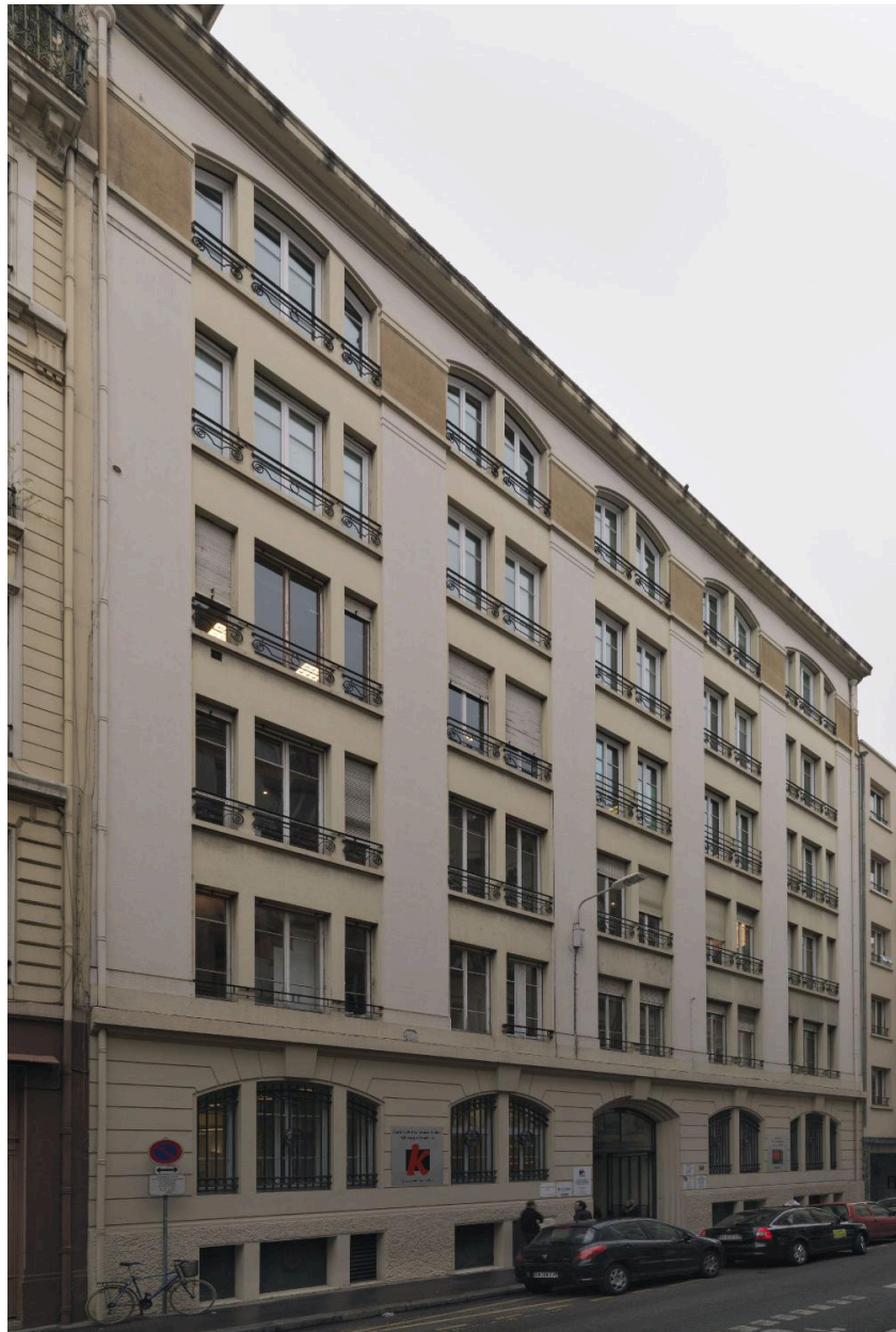
Façade rue de Sèze vue ouest
