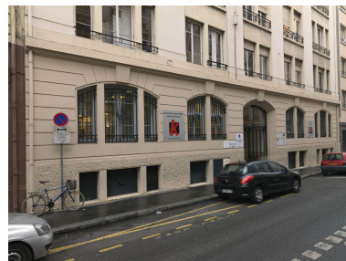
Détail rez-de-chaussée Phot. Didier Gourbin IVR82_20116905320NUCA
