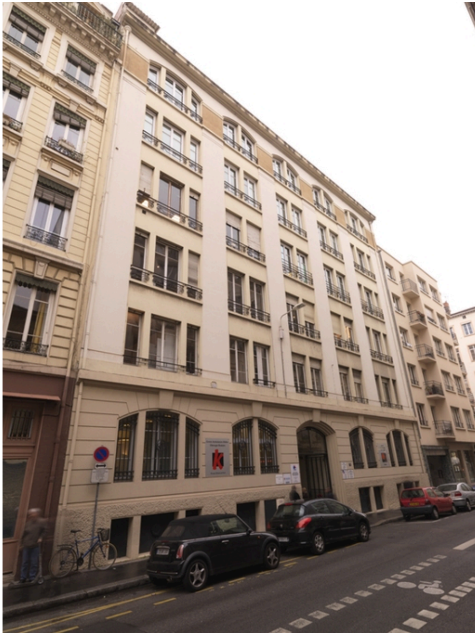
Vue générale rue de Sèze
