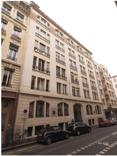
Vue générale rue de Sèze Phot. Didier Gourbin IVR82_20116905322NUCA
