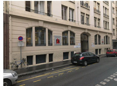
Détail rez-de-chaussée Phot. Didier Gourbin IVR82_20116905320NUCA
