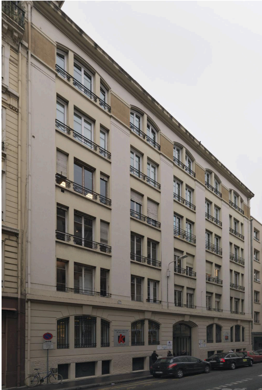
Façade rue de Sèze vue ouest
