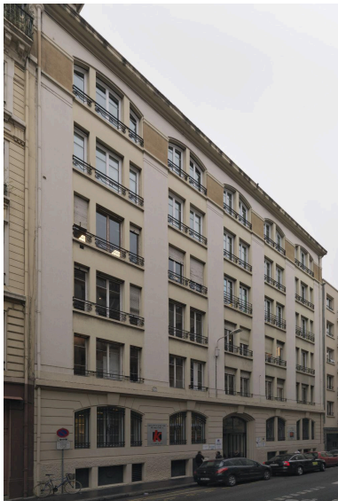
Façade rue de Sèze vue ouest Phot. Didier Gourbin IVR82_20116905321NUCA
