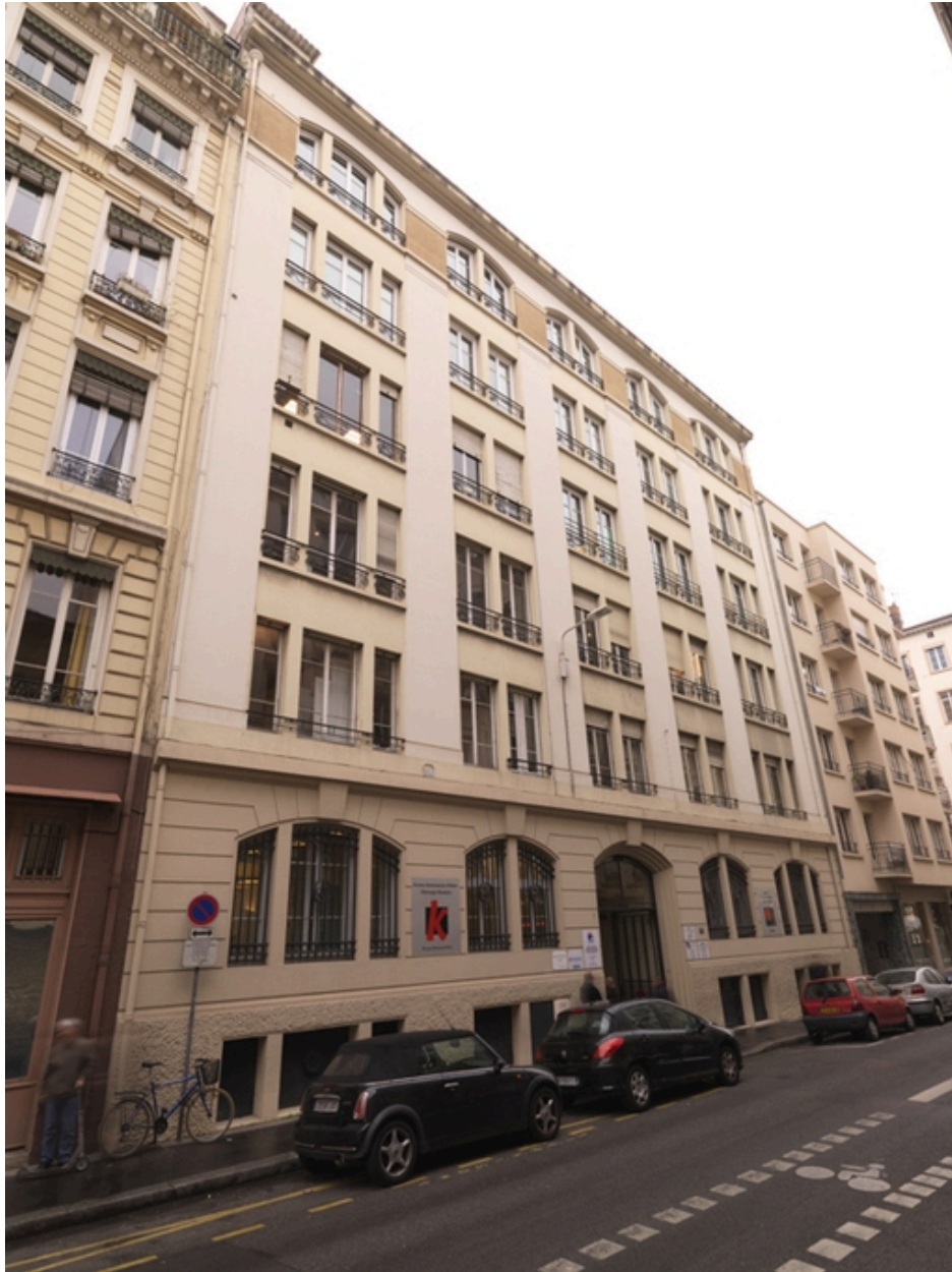
Vue générale rue de Sèze
