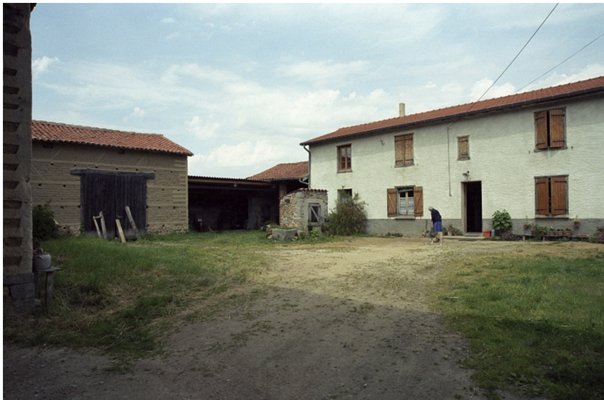
Vue d'ensemble de la cour : logis, hangar, grange.
