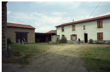
Vue d'ensemble de la cour : logis, hangar, grange.
