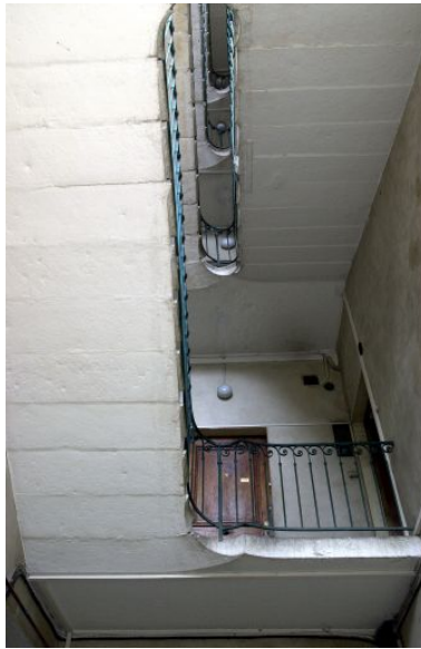
Vue de la cage d'escalier Phot. Maryannick Chalabi IVR82_20016902105NUCA
