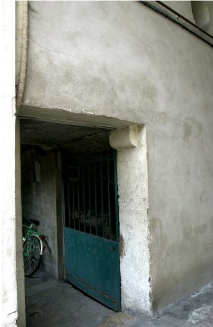
Détail de l'entrée de cave sous le passage couvert
