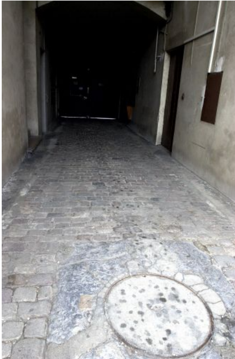
Vue du passage couvert depuis la cour à l'est
