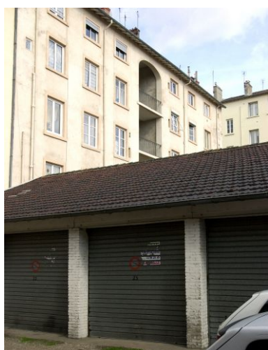
Vue de la cage ouverte de l'escalier depuis le sud Phot. Maryannick Chalabi
