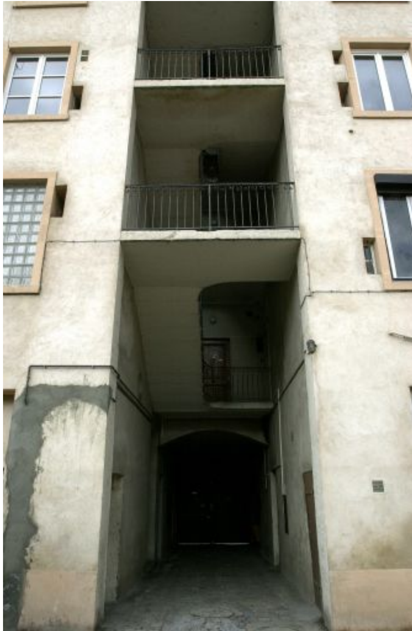
Vue de la cage ouverte de l'escalier depuis la cour à l'est
