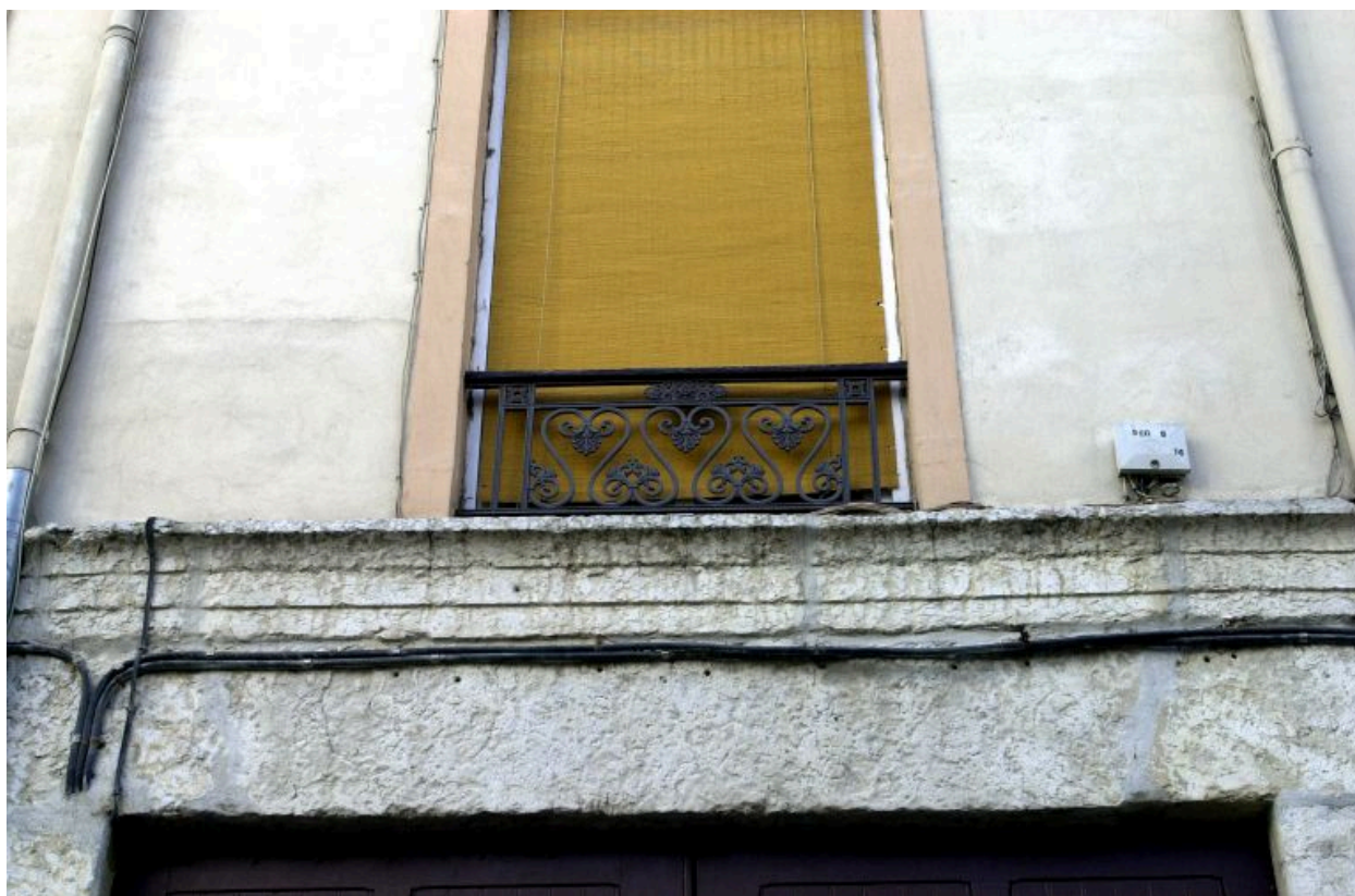
Détail d'un garde-corps
