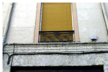
Détail d'un garde-corps Phot. Maryannick Chalabi IVR82_20016902100NUCA
