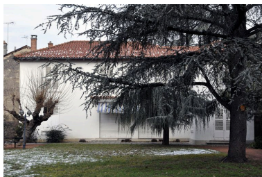
Façade antérieure Phot. Julien Defillon IVR82_20106900853NUCA
