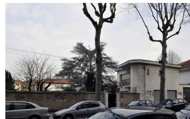
Vue depuis la rue Phot. Julien Defillon IVR82_20106900855NUCA
