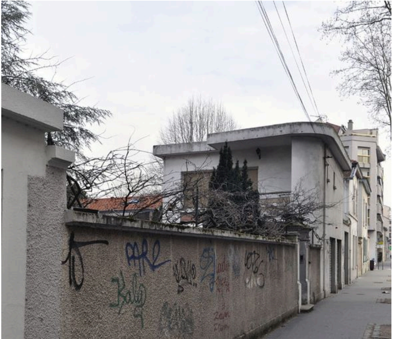
Façade latérale de la maison sur rue et mur de clôture
