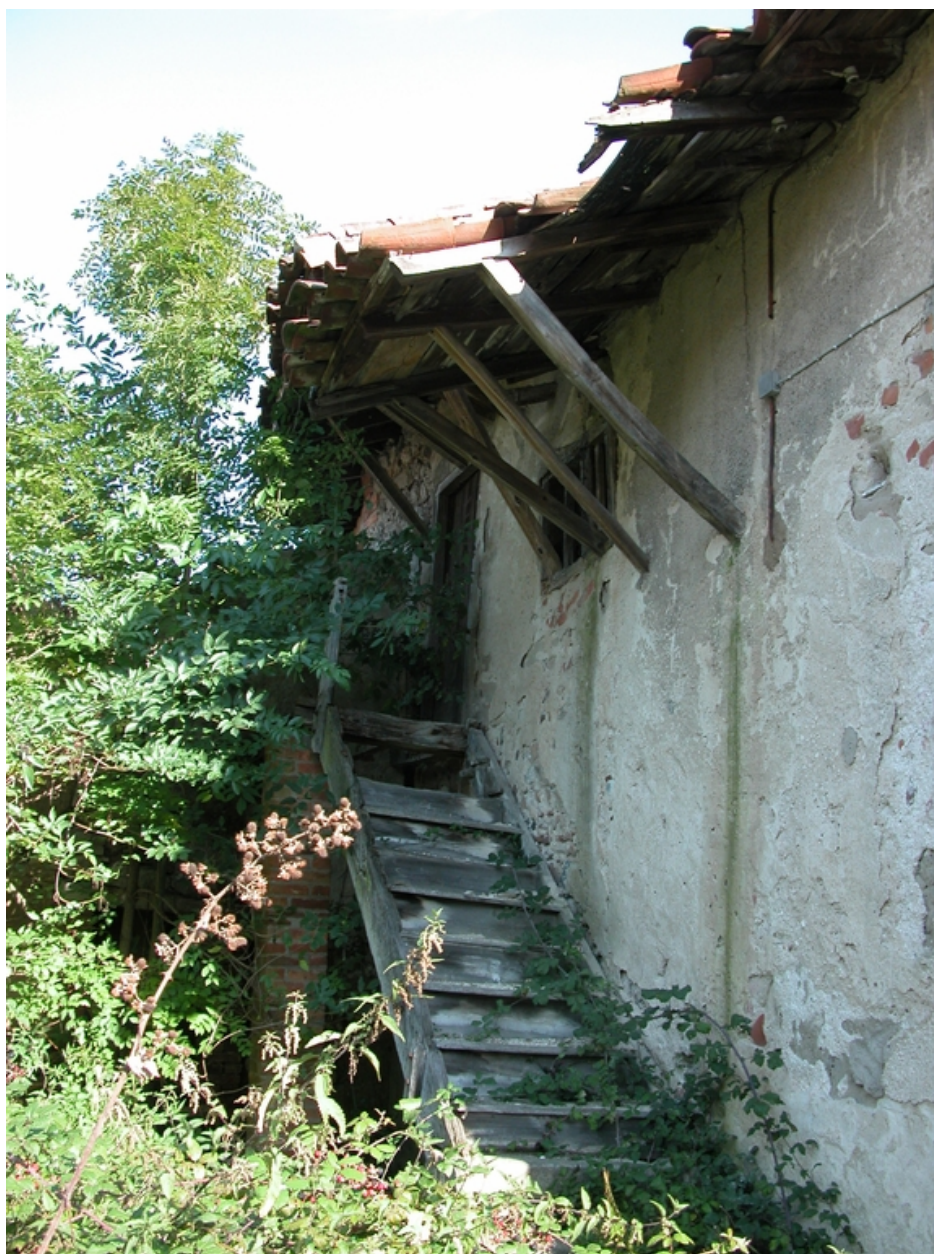
Elévation nord du logis : escalier extérieur.
