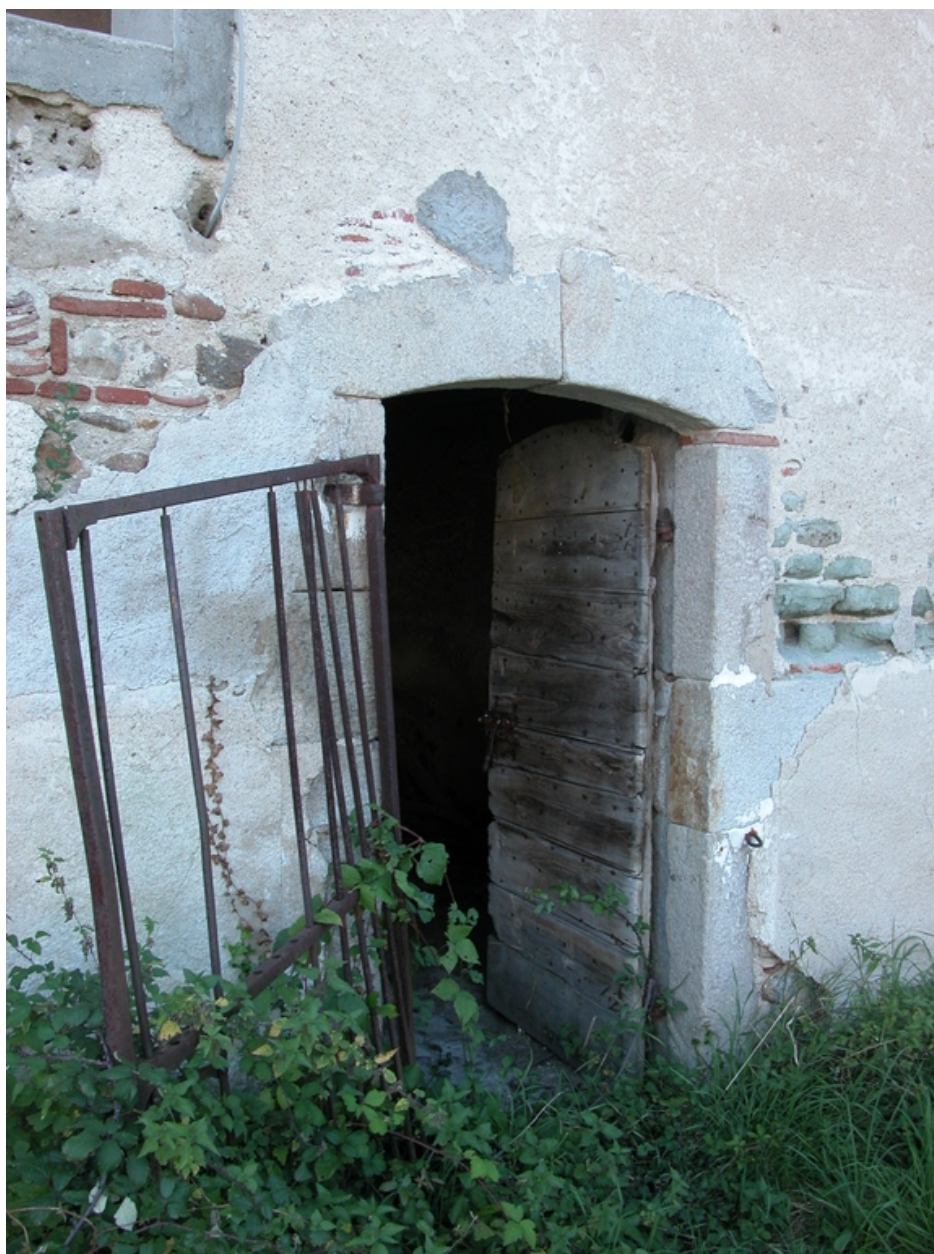
Détail de la porte nord de l'étable ou écurie ouest.
