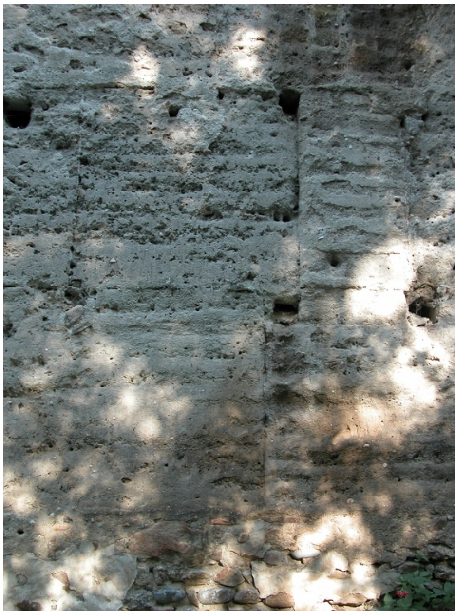
Détail de pisé (mur extérieur ouest, jonction entre le bâtiment ouest et le bâtiment nord).
