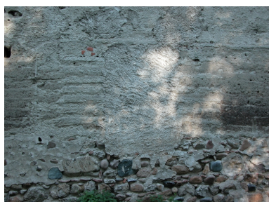
Détail de pisé (mur extérieur ouest). Phot. Thierry Monnet IVR82_20134202792NUCA
