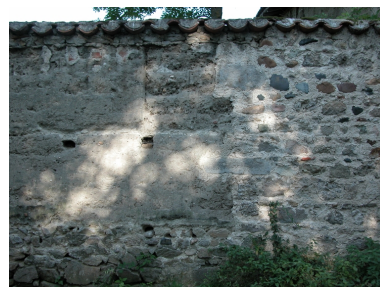
Détail de pisé (mur de clôture ouest). Phot. Thierry Monnet IVR82_20134202791NUCA
