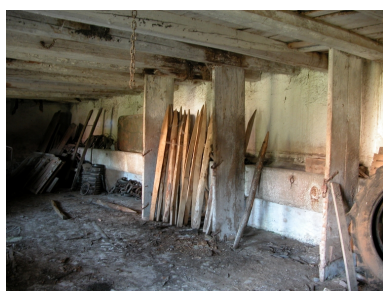
Vue intérieure de l'étable ou écurie ouest. Phot. Thierry Monnet IVR82_20134202779NUCA
