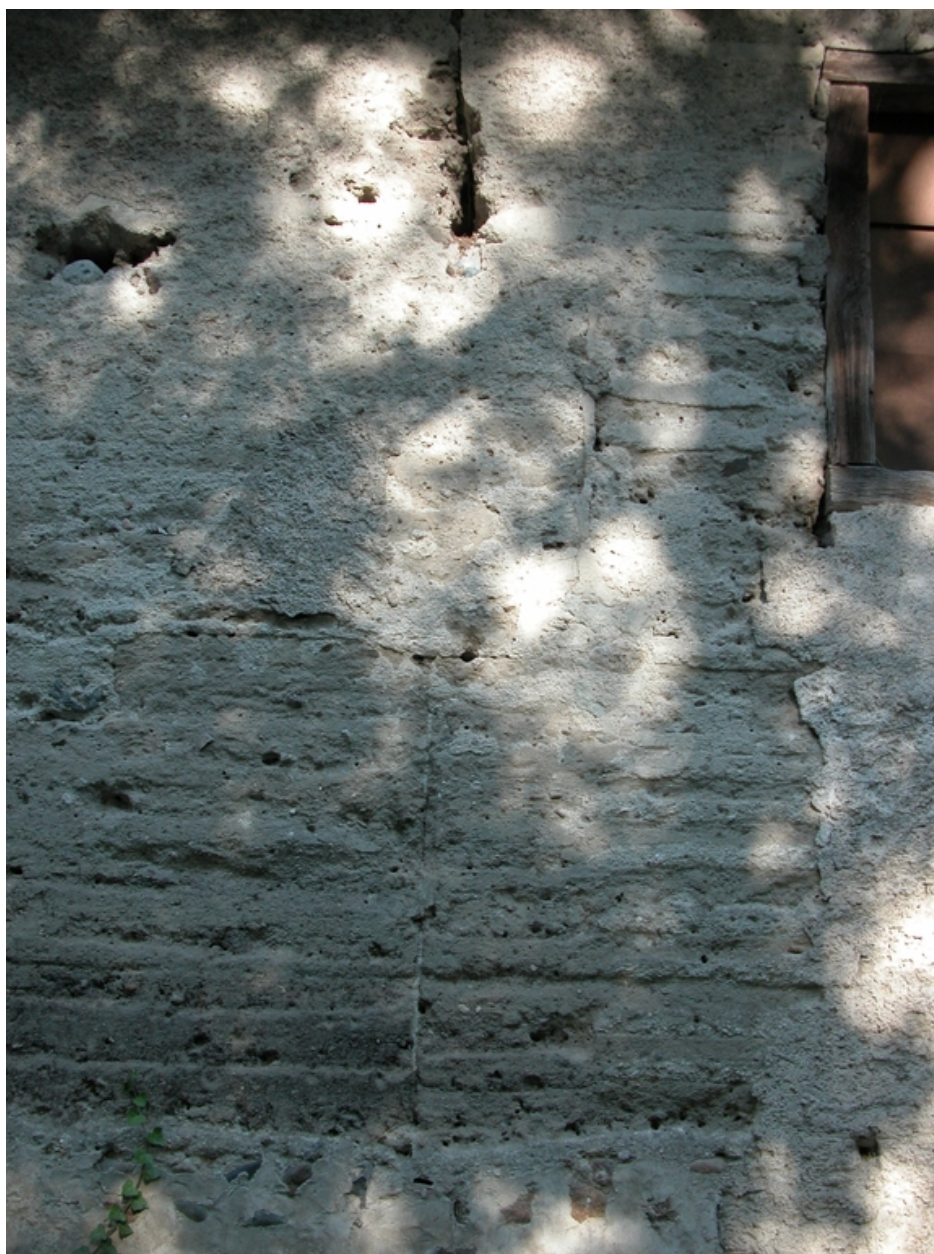
Détail de pisé (mur extérieur ouest).
