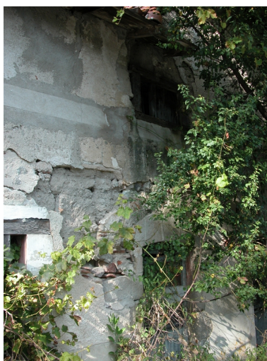
Elévation sud du logis : porte d'entrée. Phot. Thierry Monnet
