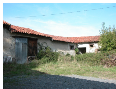
Vue de l'angle nord-est de la cour. Phot. Thierry Monnet IVR82_20134202781NUCA
