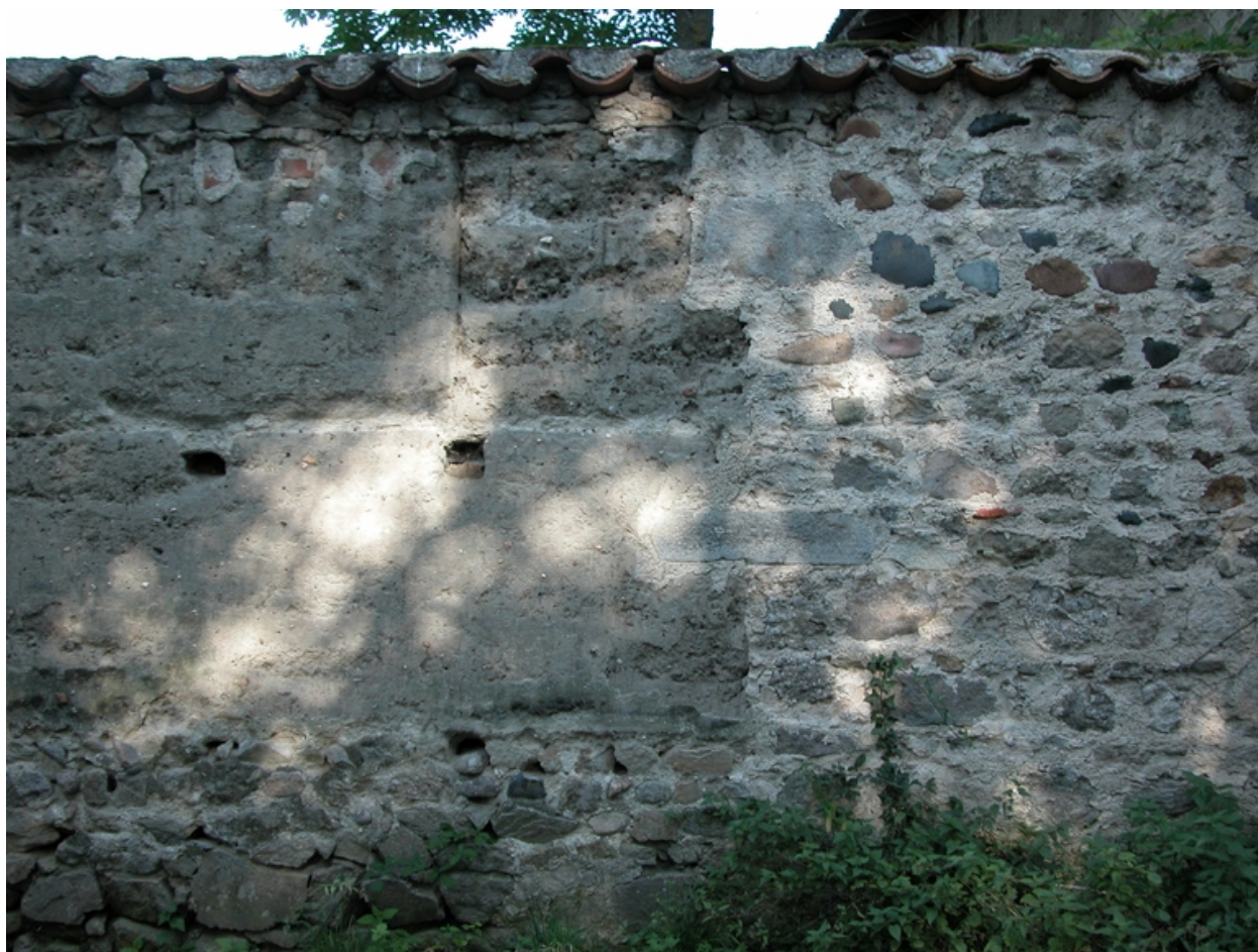
Détail de pisé (mur de clôture ouest).
