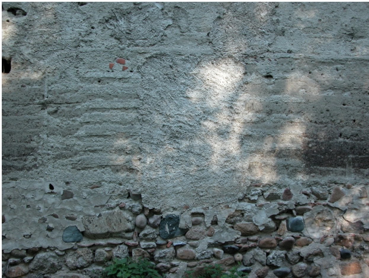
Détail de pisé (mur extérieur ouest).
