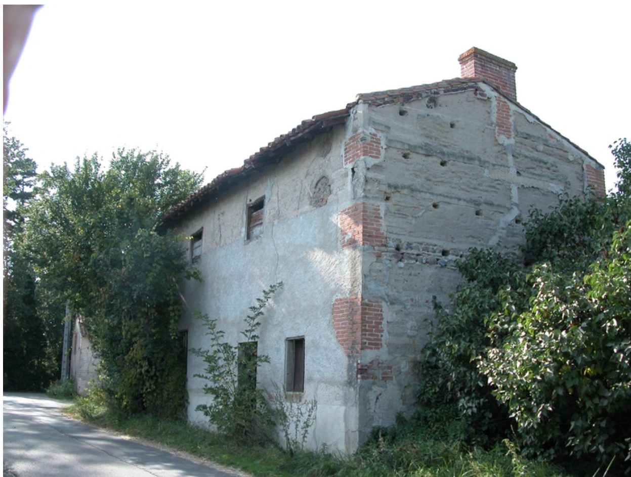
Vue d'ensemble du logis depuis le sud-est.
