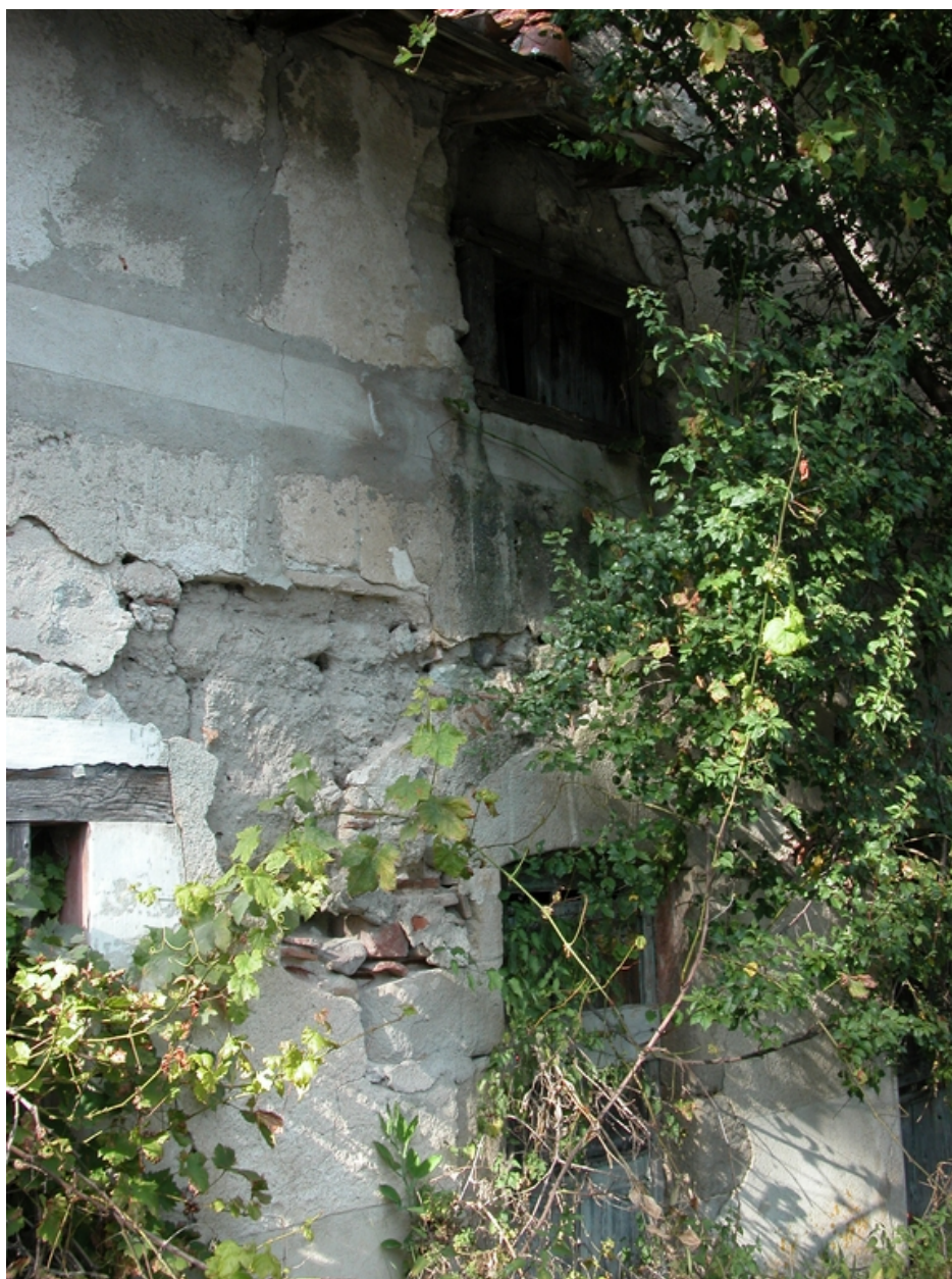
Elévation sud du logis : porte d'entrée.
