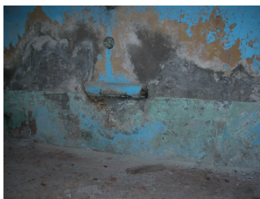
Vue intérieure du logis : vestiges du four à pain. Phot. Thierry Monnet IVR82_20134202784NUCA
