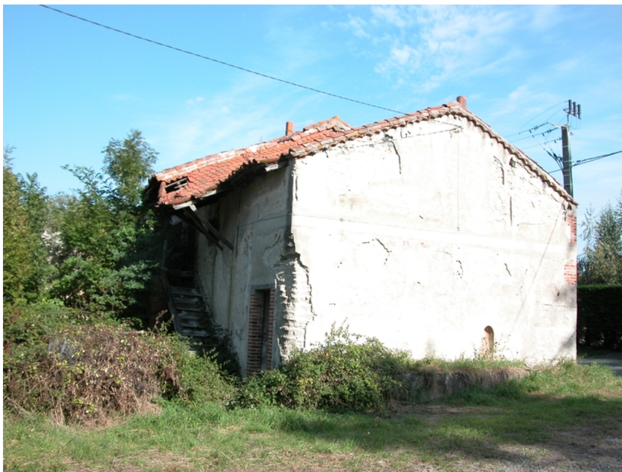
Vue d'ensemble du logis depuis le nord-ouest.
