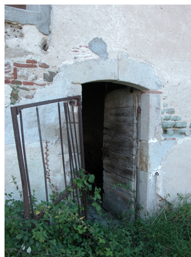
Détail de la porte nord de l'étable ou écurie ouest. Phot. Thierry Monnet IVR82_20134202778NUCA
