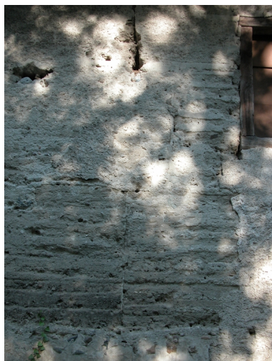
Détail de pisé (mur extérieur ouest). Phot. Thierry Monnet IVR82_20134202789NUCA
