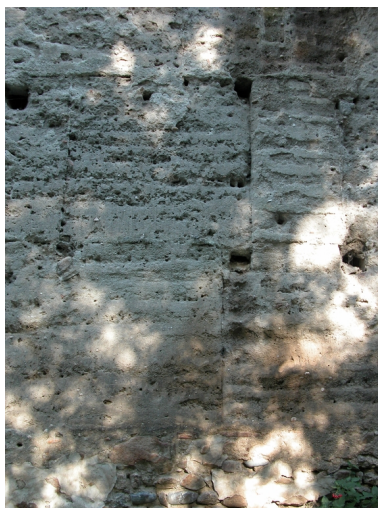
Détail de pisé (mur extérieur ouest, jonction entre le bâtiment ouest et le bâtiment nord). Phot. Thierry Monnet IVR82_20134202790NUCA
