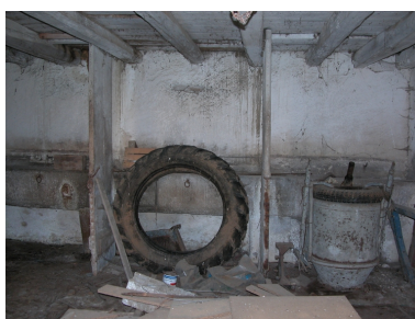
Vue intérieure de l'étable ou écurie ouest. Phot. Thierry Monnet IVR82_20134202780NUCA
