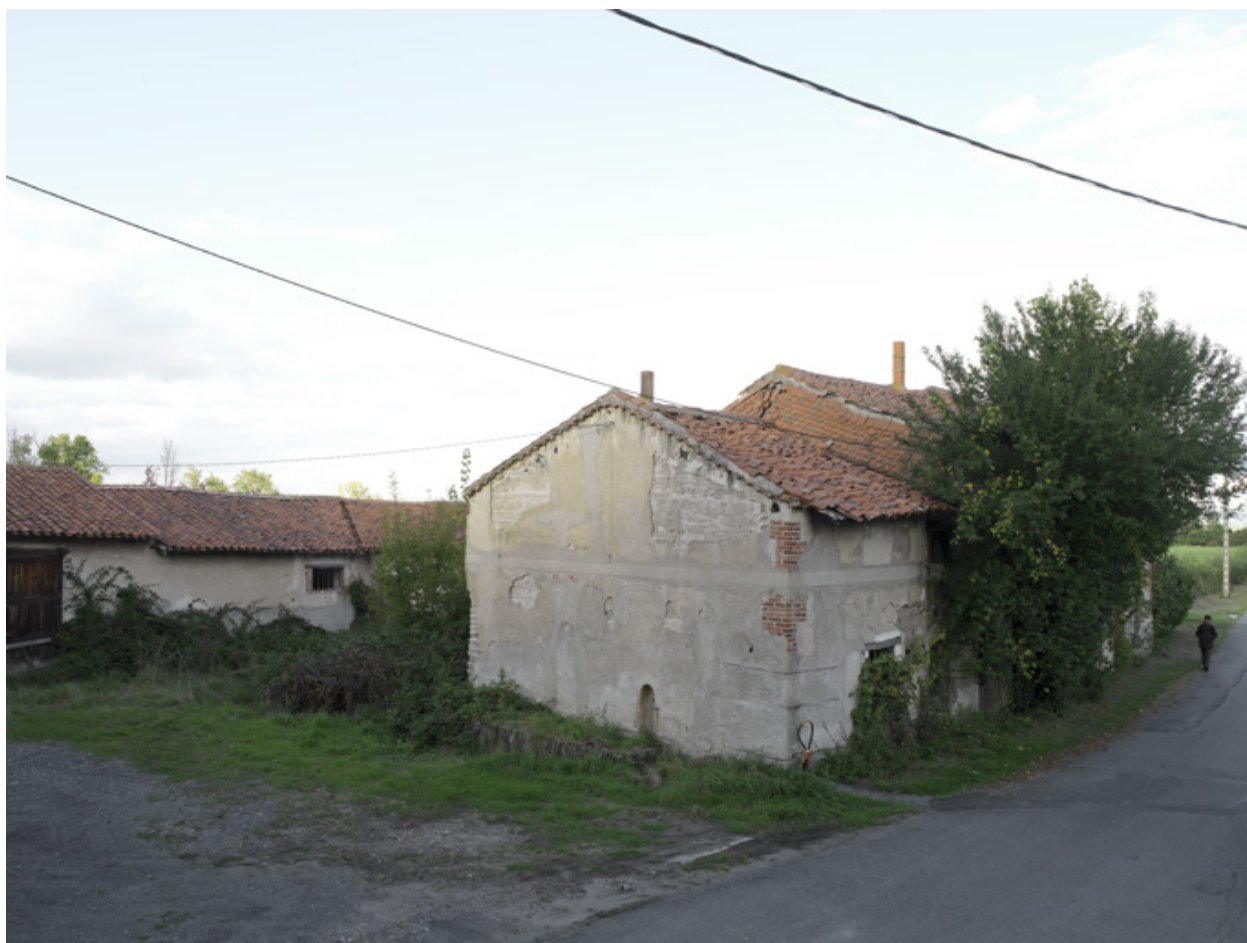
Vue générale depuis le sud-ouest.
