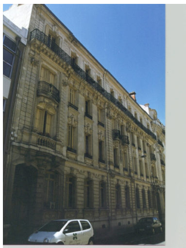
Façade principale Phot. Cendrine Sanquer IVR82_19974202010ZE
