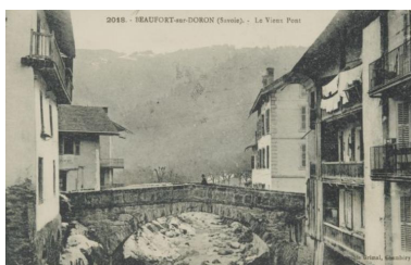
Vue ancienne du pont de Beaufort franchissant le Doron. A gauche, des bâtiments sous lesquels passe la bialière. IVR84_20187300168NUCA
