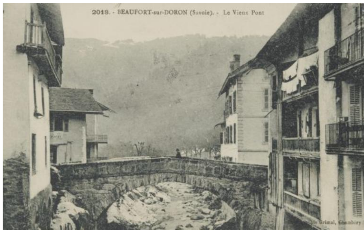
Vue ancienne du pont de Beaufort franchissant le Doron. A gauche, des bâtiments sous lesquels passe la bialière.
