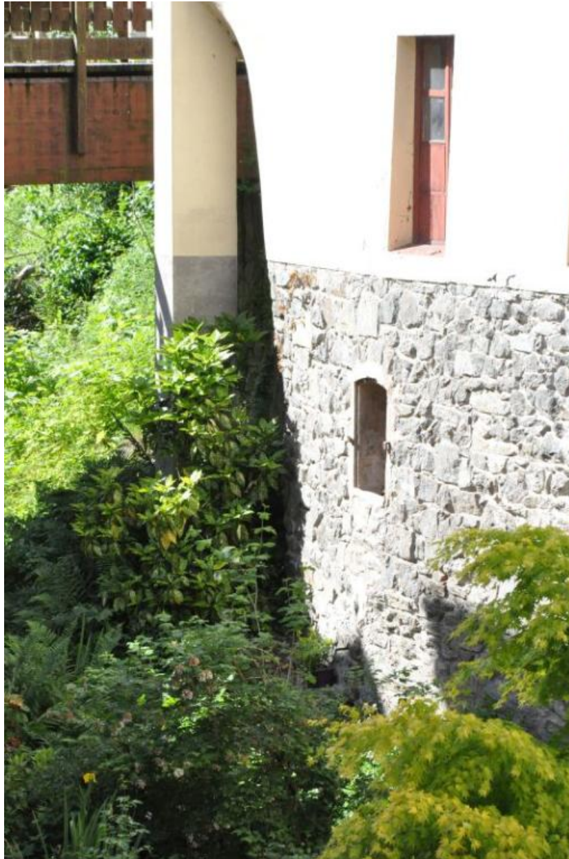
Détail de l'un des murs de maisons sous laquelle passe la bialière.
