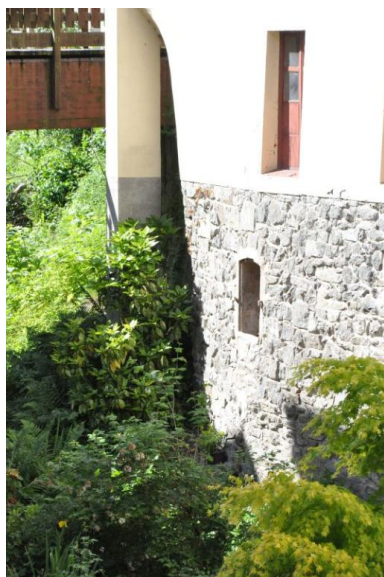
Détail de l'un des murs de maisons sous laquelle passe la bialière. Phot. Odile Gaboriau IVR84_20187300077NUCA
