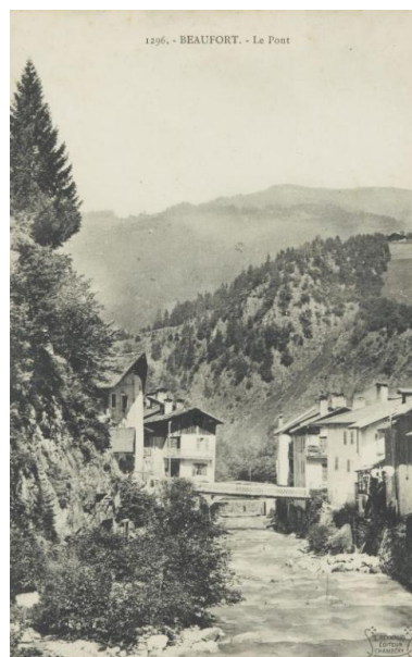
Vue de l'emplacement où se trouvait la prise d'eau de la bialière. IVR84_20187300169NUCA
