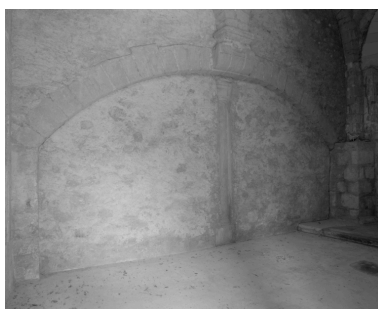
Elévation intérieure, mur nord : structure d'un arc de décharge latéral s'étendant sur deux travées. Phot. Alain Franchella IVR82_20002600301X
