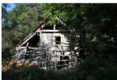
Vue générale du moulin Phot. Yannick Milleret IVR82_20107300744NUCA
