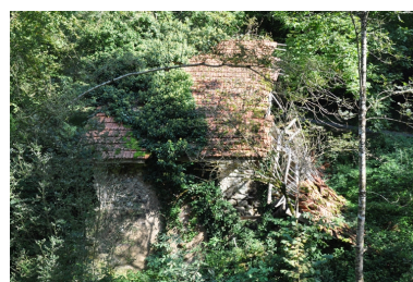
Vue ouest du moulin Phot. Yannick Milleret IVR82_20107300745NUCA
