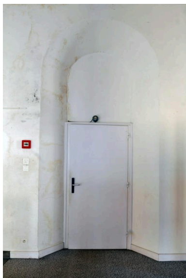
Salle des professeurs : ancienne fenêtre transformée ? ; porte donnant accès au premier étage du corps de bâtiment séparant les deux cours Phot. Catherine Guégan IVR84_20201500061NUCA
