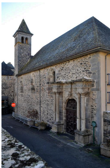
Elévation principale Phot. Catherine Guégan IVR84_20201500013NUCA
