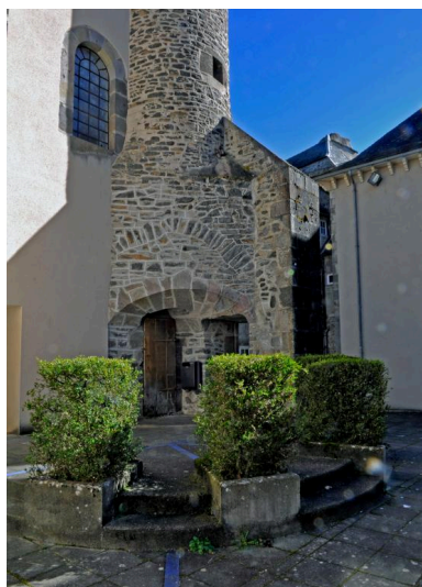
Base de la tour d'escalier menant au comble Phot. Catherine Guégan IVR84_20201500053NUCA
