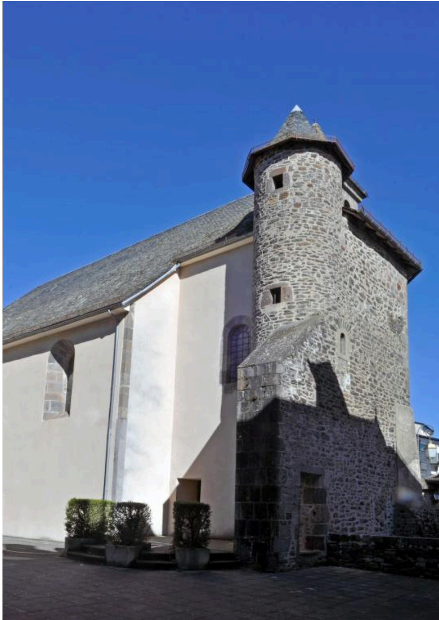
Vue du chevet et tour d'escalier
