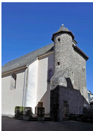
Vue du chevet et tour d'escalier Phot. Catherine Guégan IVR84_20201500025NUCA
