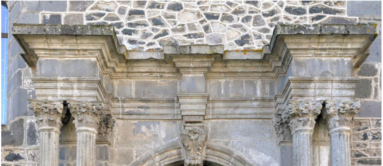
Portail : détail de la partie supérieure
