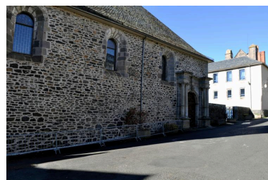
Elévation principale, depuis le sud Phot. Catherine Guégan IVR84_20201500065NUCA
