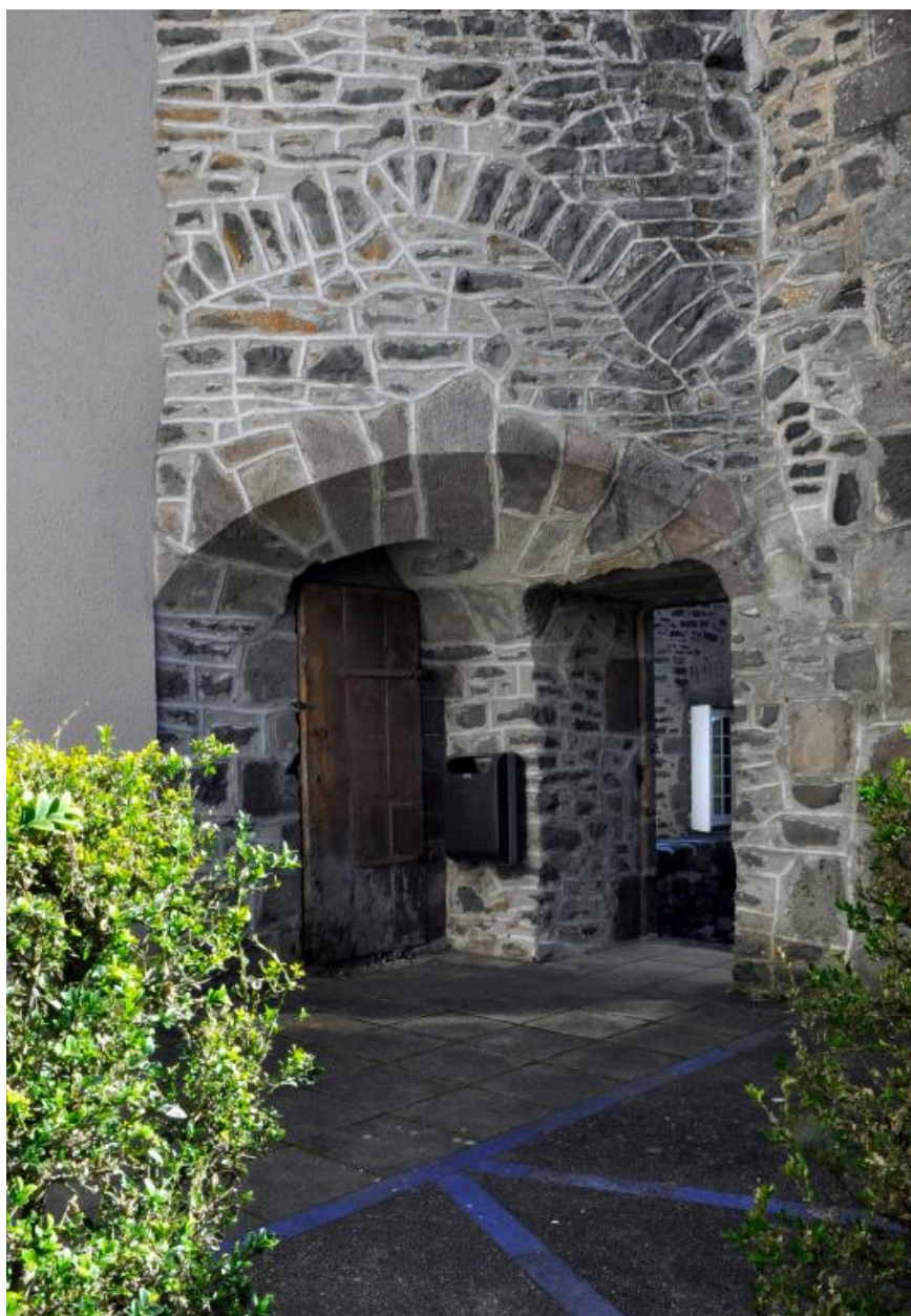
Tour d'escalier : détail de la trompe, porte de la tour (à gauche) et baie ouverte (vestige d'un ancien passage ?)
