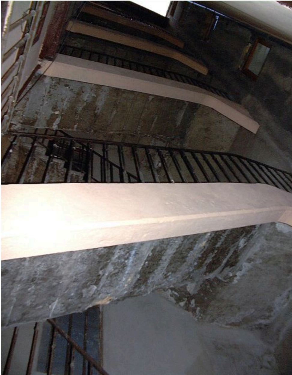
Escalier commun aux 12 rue Ferrachat et 9 rue Bellière
