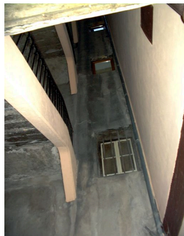
Escalier commun aux 12 rue Ferrachat et 9 rue Bellière, élévation sur cour du corps de bâtiment est Phot. Maryannick Chalabi IVR82_20006900162NUCA
