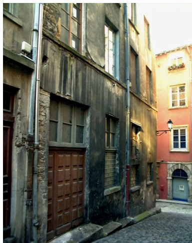
Elévation ouest, rez-de-chaussée Phot. Maryannick Chalabi IVR82_20006900172NUCA
