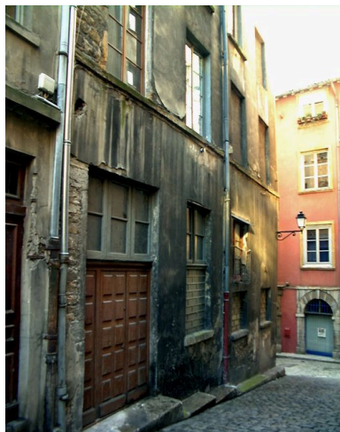
Elévation ouest, rez-de-chaussée Phot. Maryannick Chalabi IVR82_20006900172NUCA
