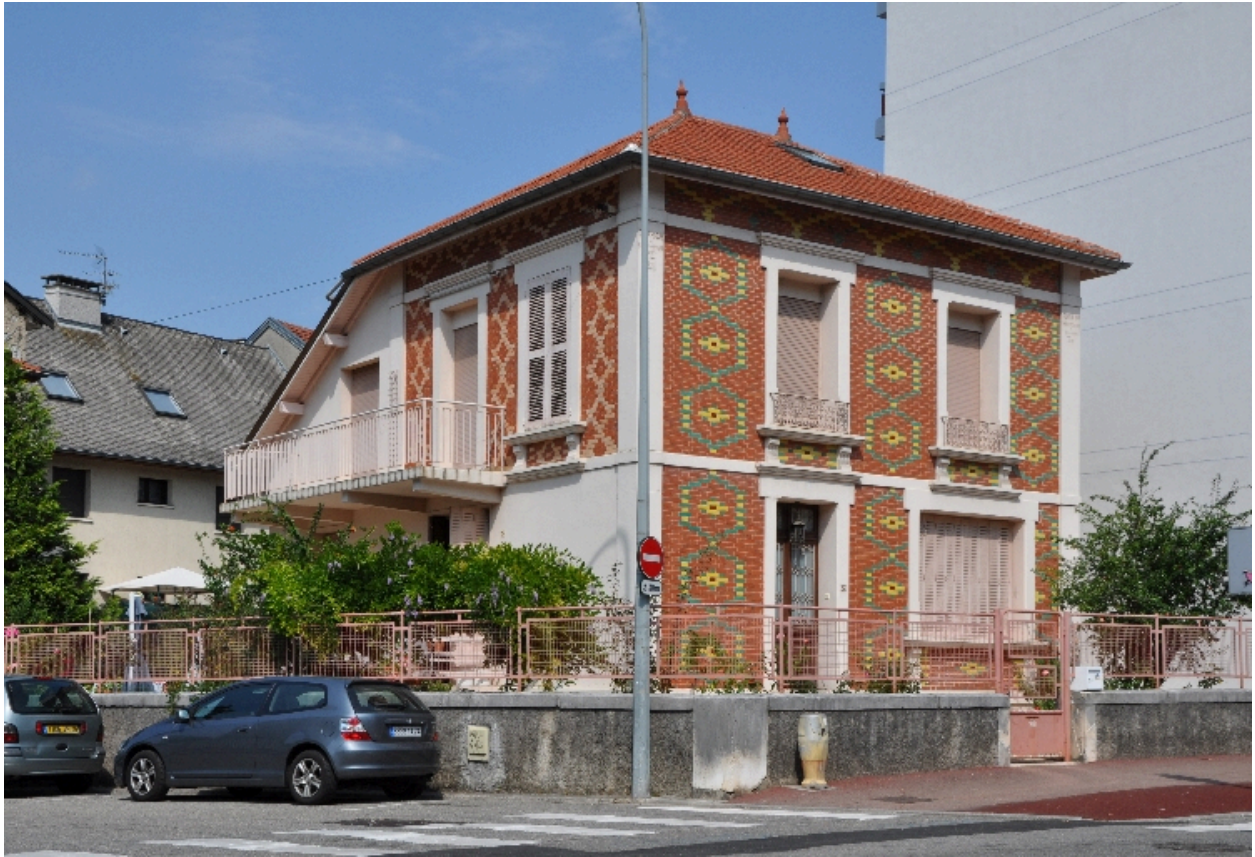
Vue depuis le sud-est
