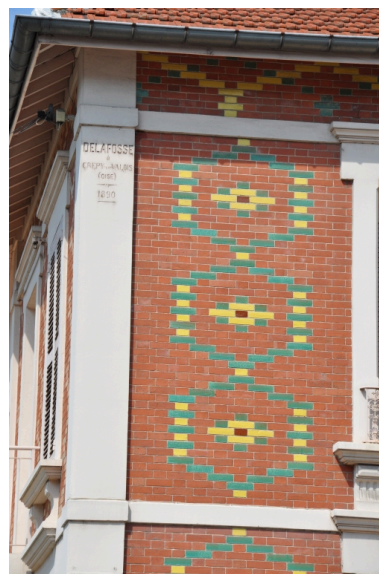
Détail du parement de brique Phot. François Fouger IVR82_20117300523NUCA
