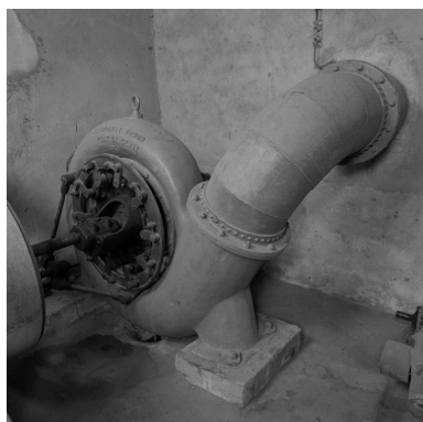
Turbine hydraulique. Phot. Jean-Marie Refflé IVR82_19920100573X
