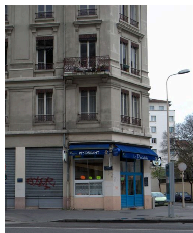
Elévation principale, détail de l'angle Phot. Maryannick Chalabi IVR82_20106905101NUCA
