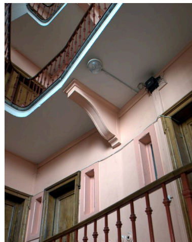
Corbeau supportant une coursière Phot. Maryannick Chalabi IVR82_20106905114NUCA
