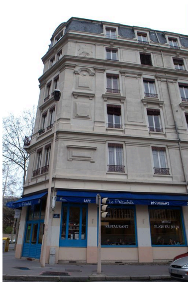
Elévation latérale, vue partielle, depuis l'ouest Phot. Maryannick Chalabi IVR82_20106905103NUCA
