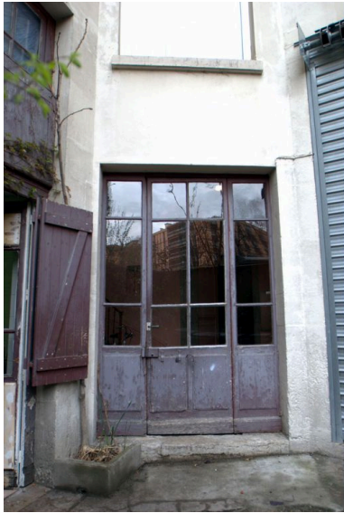
Porte sur cour, donnant accès à la cage d'escalier Phot. Maryannick Chalabi IVR82_20106905106NUCA
