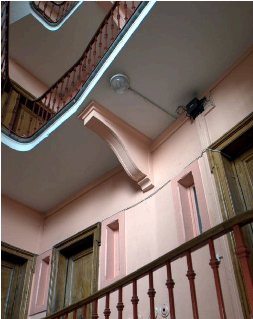
Corbeau supportant une coursière
