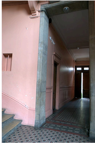
Vestibule, depuis la cage d'escalier Phot. Maryannick Chalabi IVR82_20106905107NUCA
