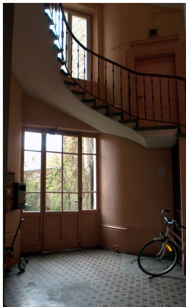
Escalier, détail de la première volée et des baies éclairant la cage Phot. Maryannick Chalabi IVR82_20106905112NUCA
