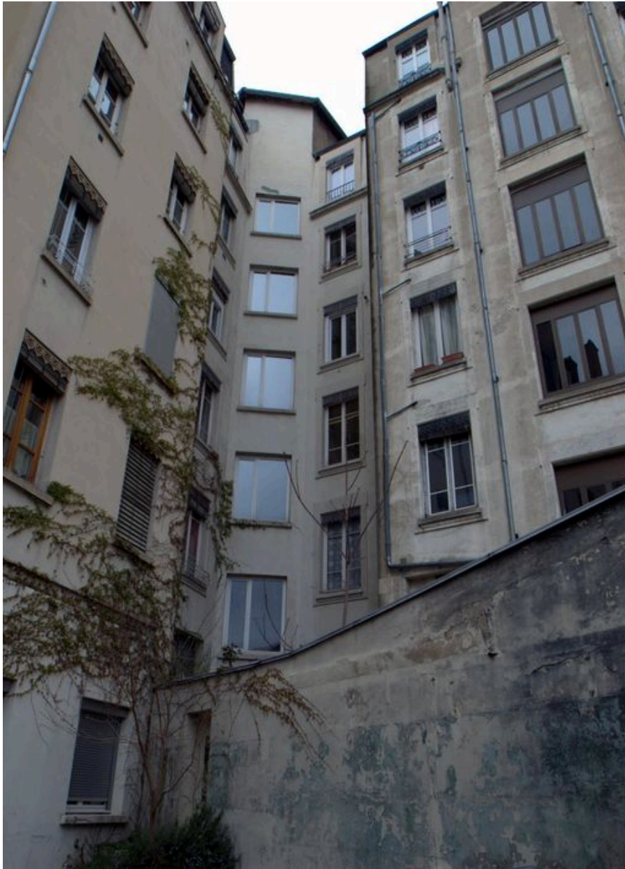
Elévation postérieure ; au centre, la tour d'escalier
