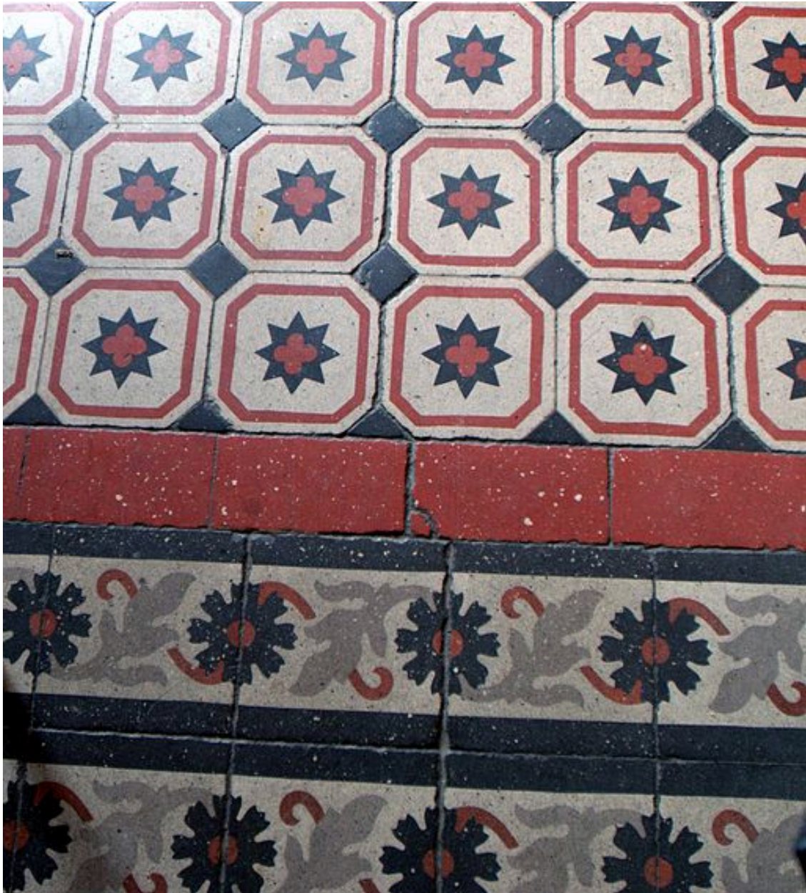
Vestibule, carrelage en carreaux de ciment
