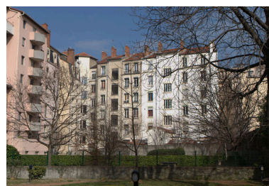
Elévations postérieures des immeubles 3 rue Nicolaï et 144, 146 et 148 cours Gambetta Phot. Maryannick Chalabi IVR82_20126902447NUCA
