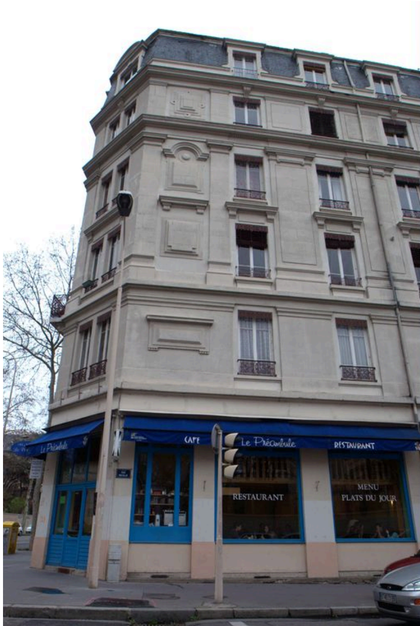
Elévation latérale, vue partielle, depuis l'ouest
