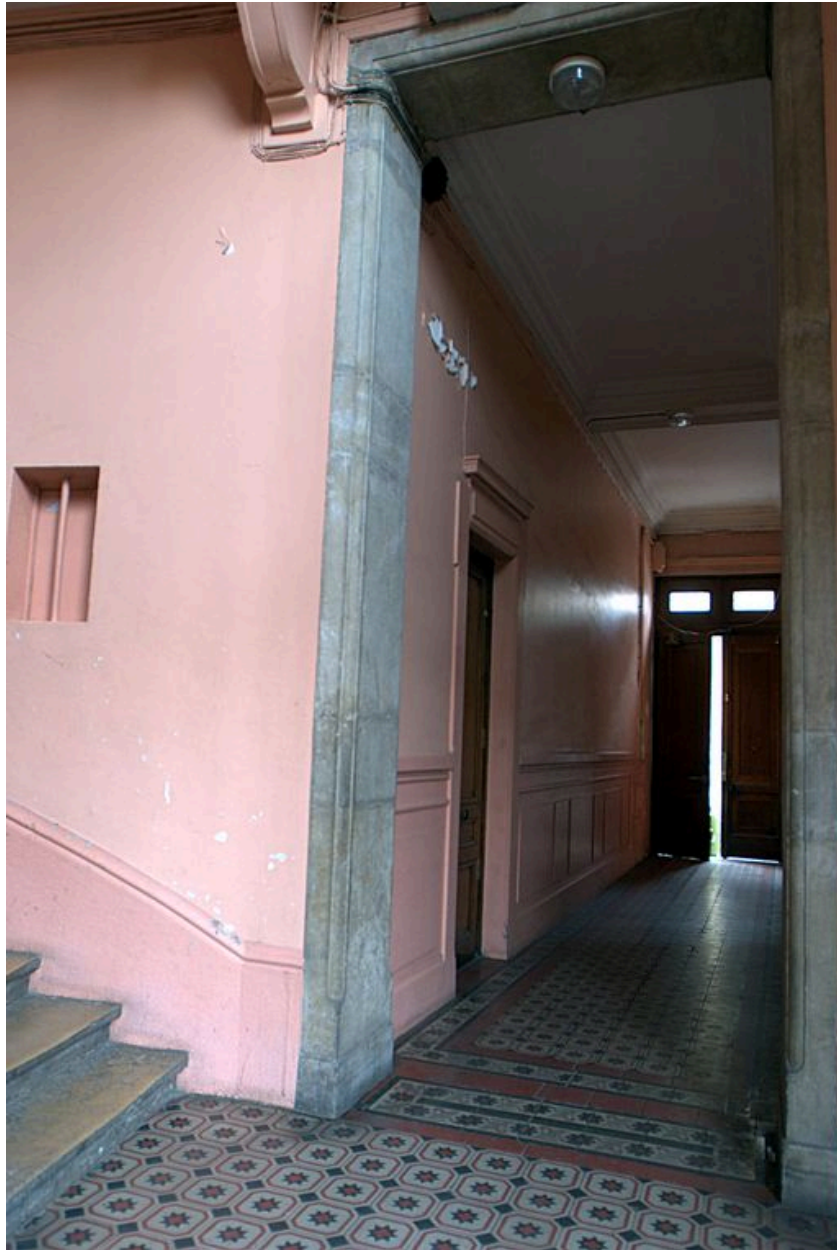
Vestibule, depuis la cage d'escalier
