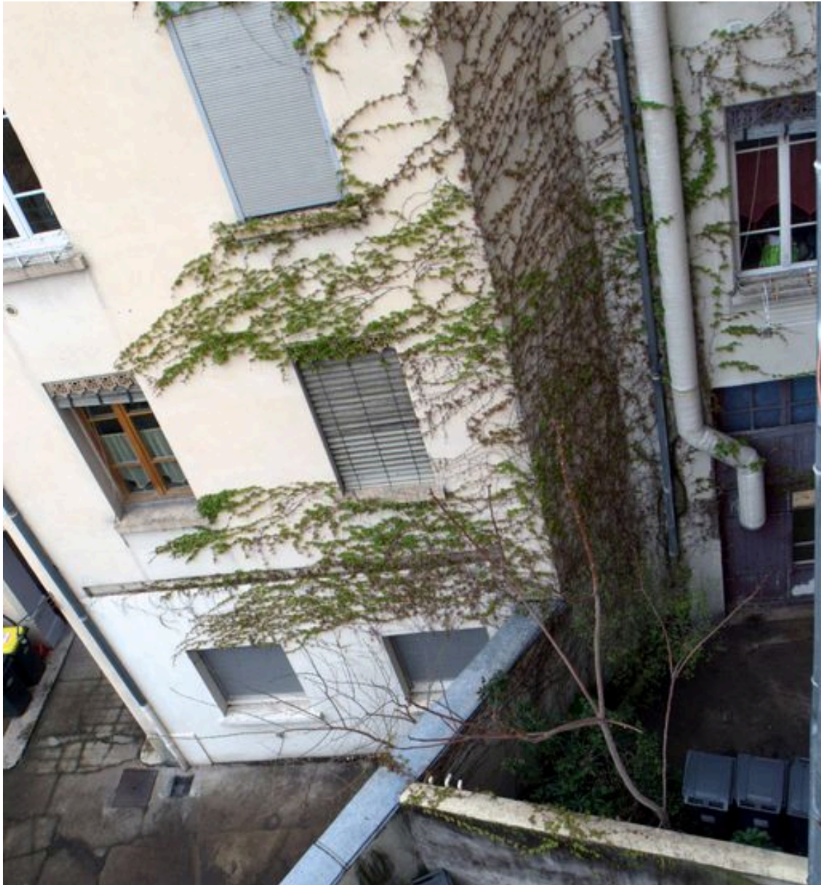
Vue de la cour, depuis le haut
