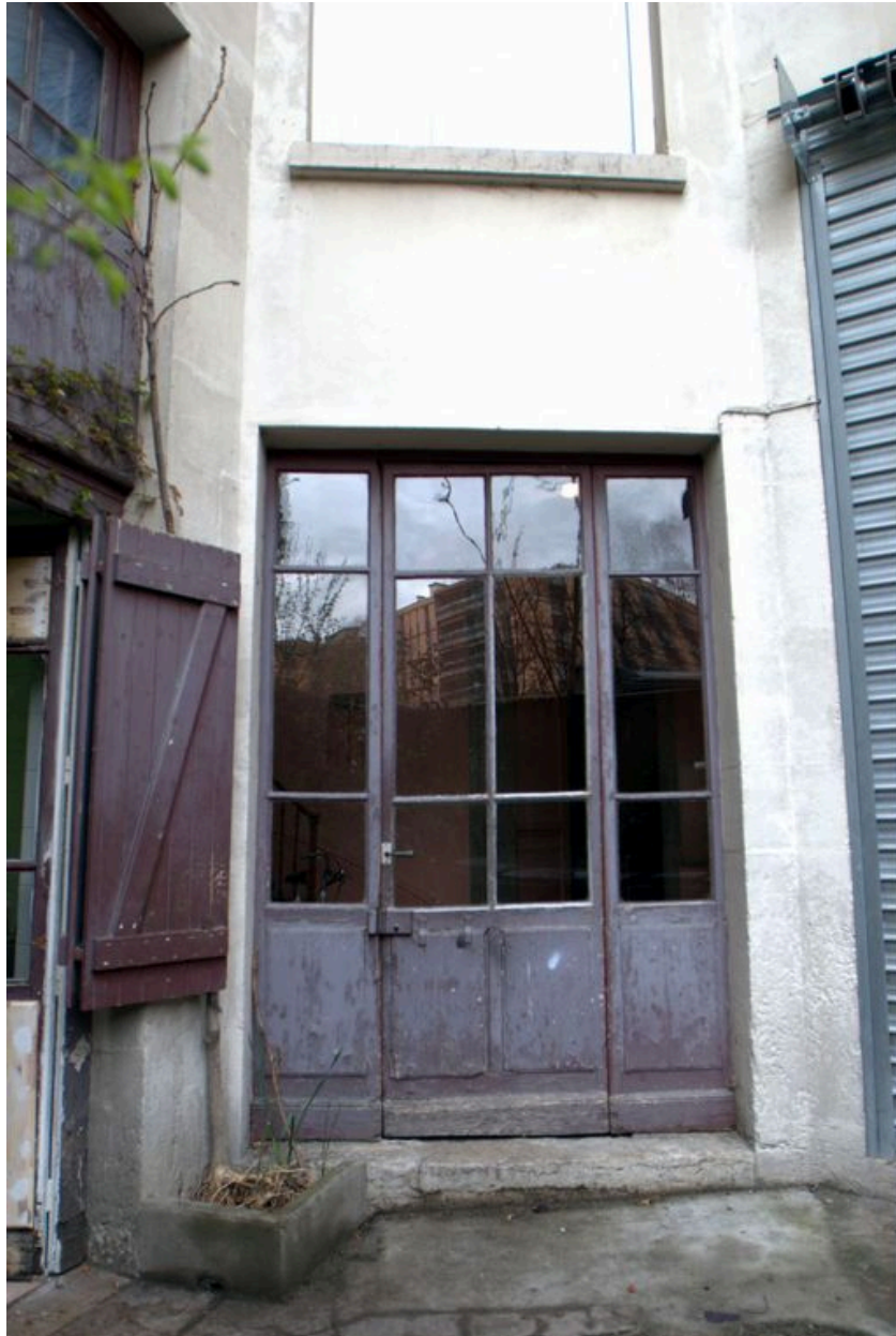
Porte sur cour, donnant accès à la cage d'escalier
