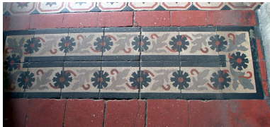
Vestibule, détail de la frise en carreaux de ciment Phot. Maryannick Chalabi IVR82_20106905109NUCA
