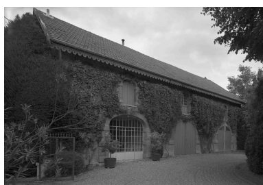
Communs, aile droite sur cour. Phot. Jean-Marie Refflé IVR82_19920100937P
