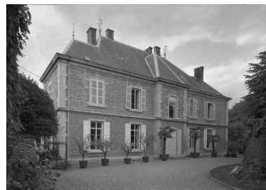
Elévation sur cour. Phot. Jean-Marie Refflé IVR82_19920100936P
