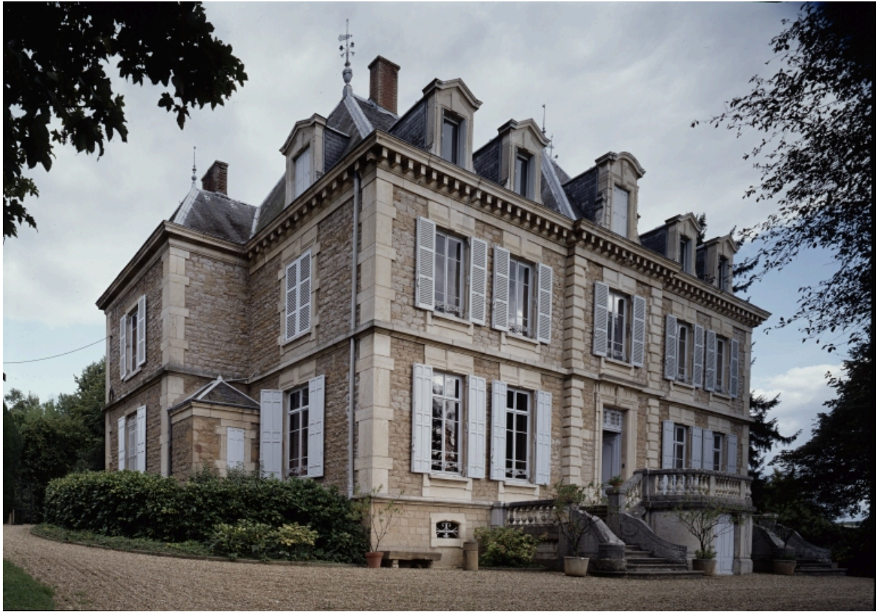
Façade sur parc et élévation latérale gauche.
