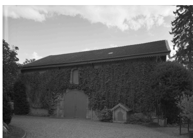
Dépendances : cuvier (aile gauche sur cour). Phot. Jean-Marie Refflé IVR82_19920100938P
