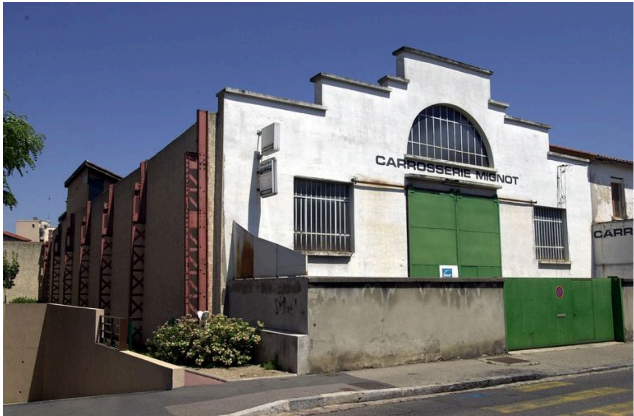
Elévation latérale et façade sur rue
