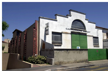
Élévation latérale et façade sur rue Phot. Phot. Inv. M.-C. Mandon IVR82_20026902395NUCA
