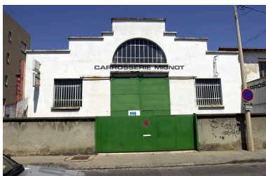
Façade principale sur rue Phot. Phot. Inv. M.-C. Mandon IVR82_20026902394NUCA
