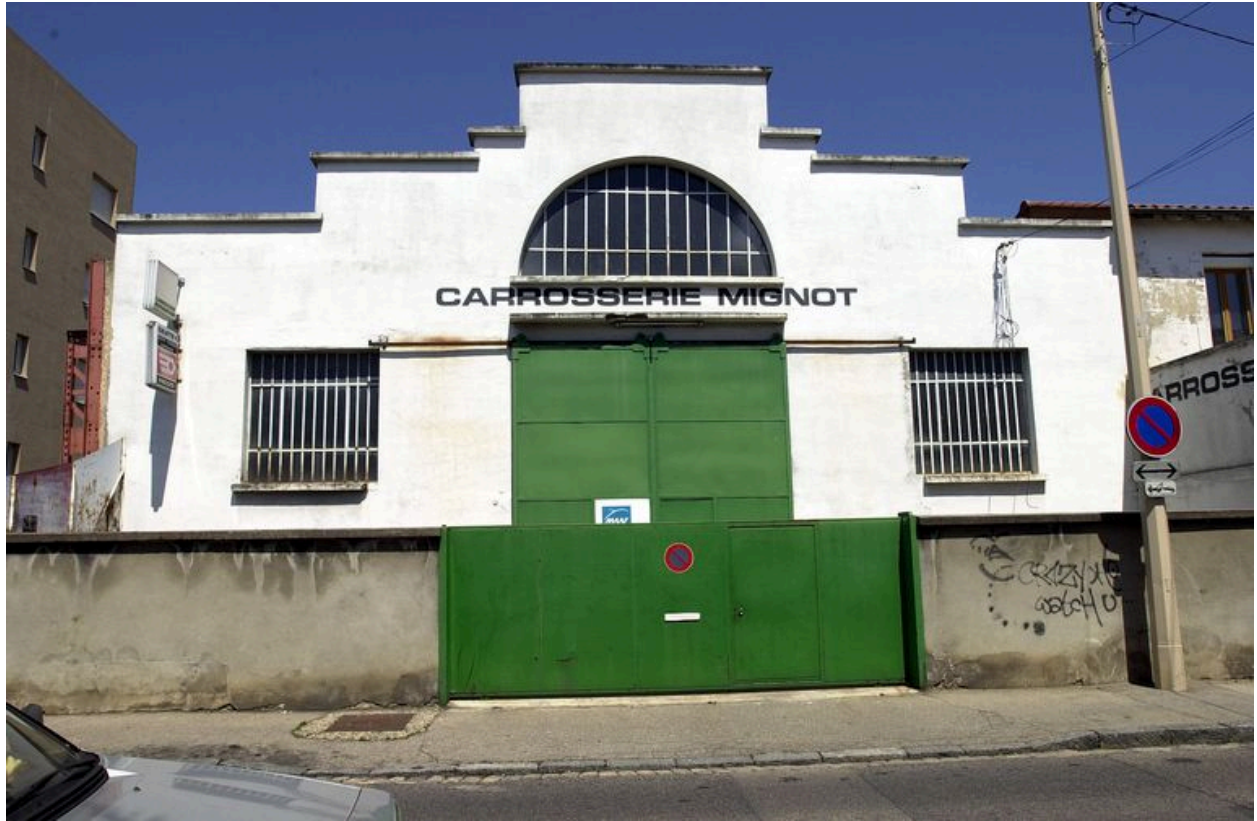
Façade principale sur rue
