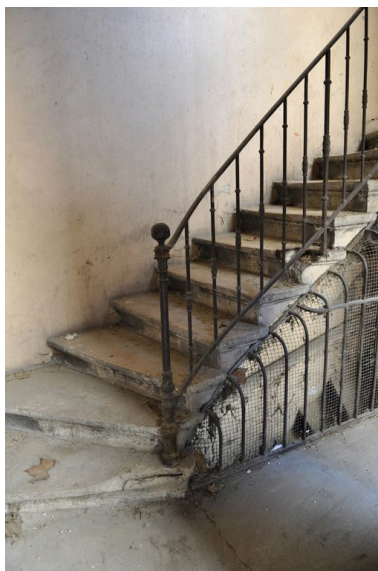
Départ de l'escalier Phot. Catherine Guégan IVR82_20096904307NUCA
