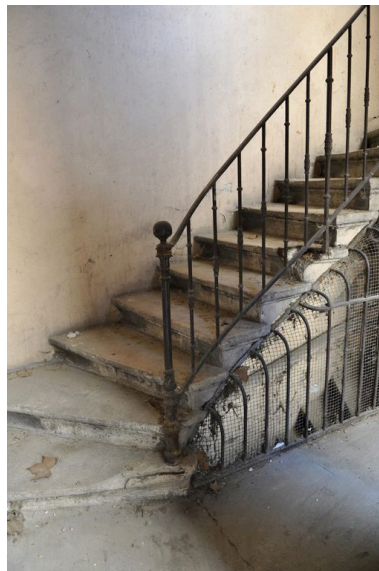
Départ de l'escalier Phot. Catherine Guégan IVR82_20096904307NUCA
