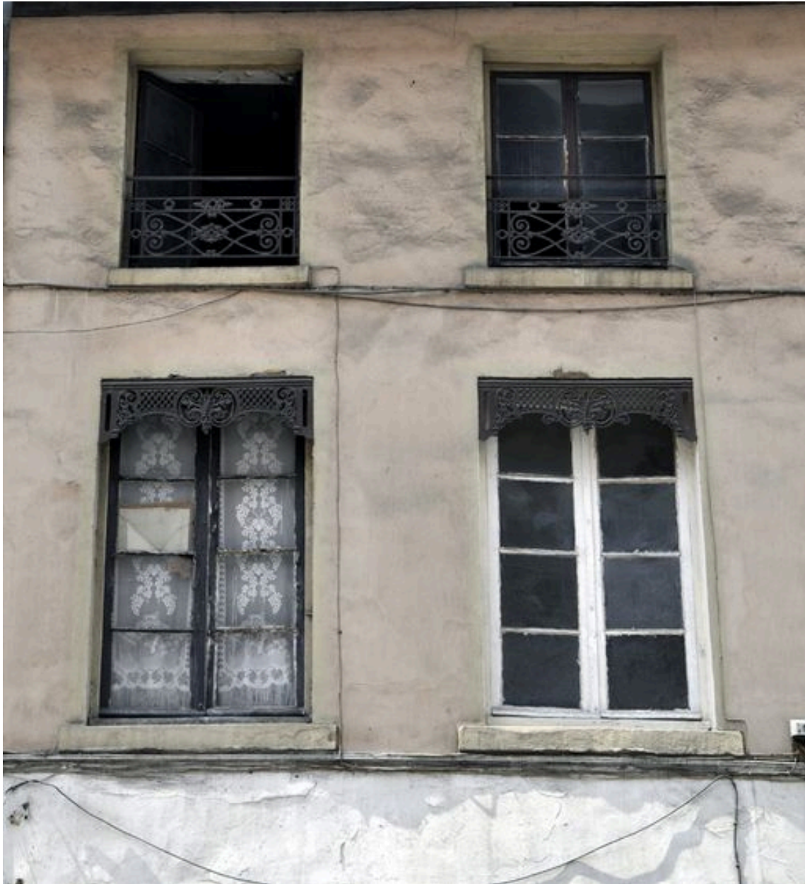
Détail des ouvertures sur rue
