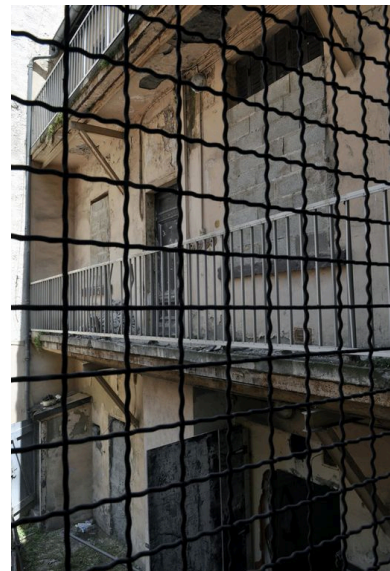
Coursières vues depuis la cage d'escalier Phot. Catherine Guégan IVR82_20096904308NUCA
