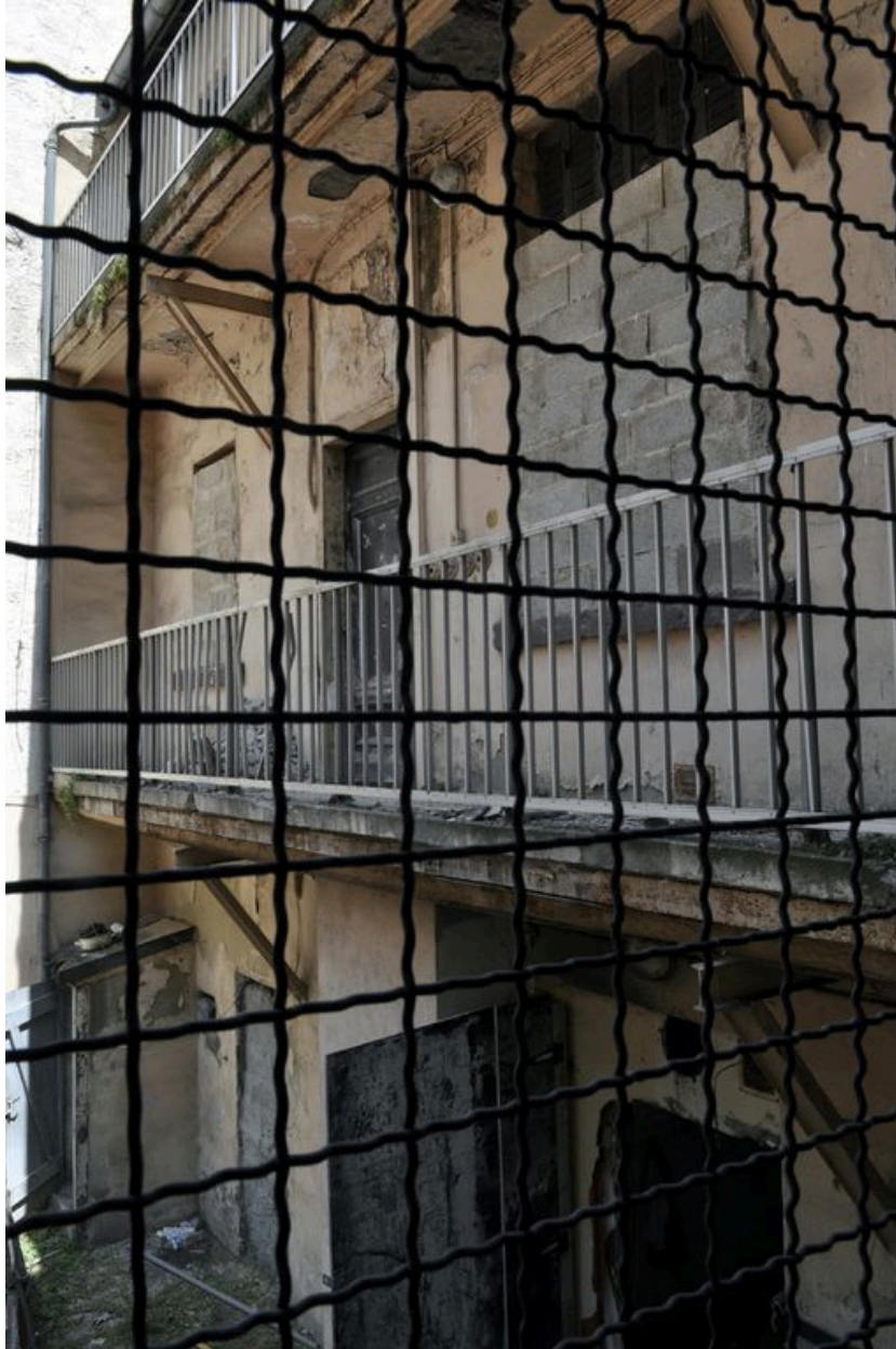
Coursières vues depuis la cage d'escalier
