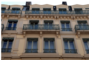
Elévation rue Gasparin : détail Phot. Véronique Belle IVR82_20096904797NUCA
