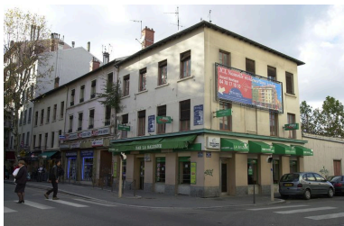
Vue de situation Phot. Bernard Ducouret IVR82_20026901558NUCA
