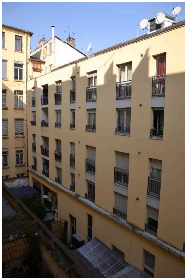
Façade sud Phot. Noémie Caillat IVR82_20156900378NUCA
