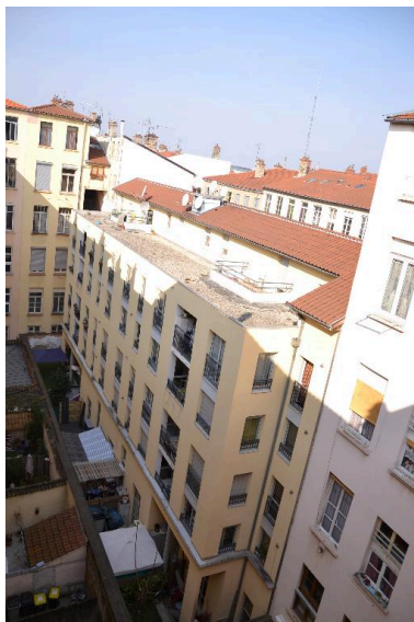
Vue d'ensemble Phot. Noémie Caillat IVR82_20156900364NUCA
