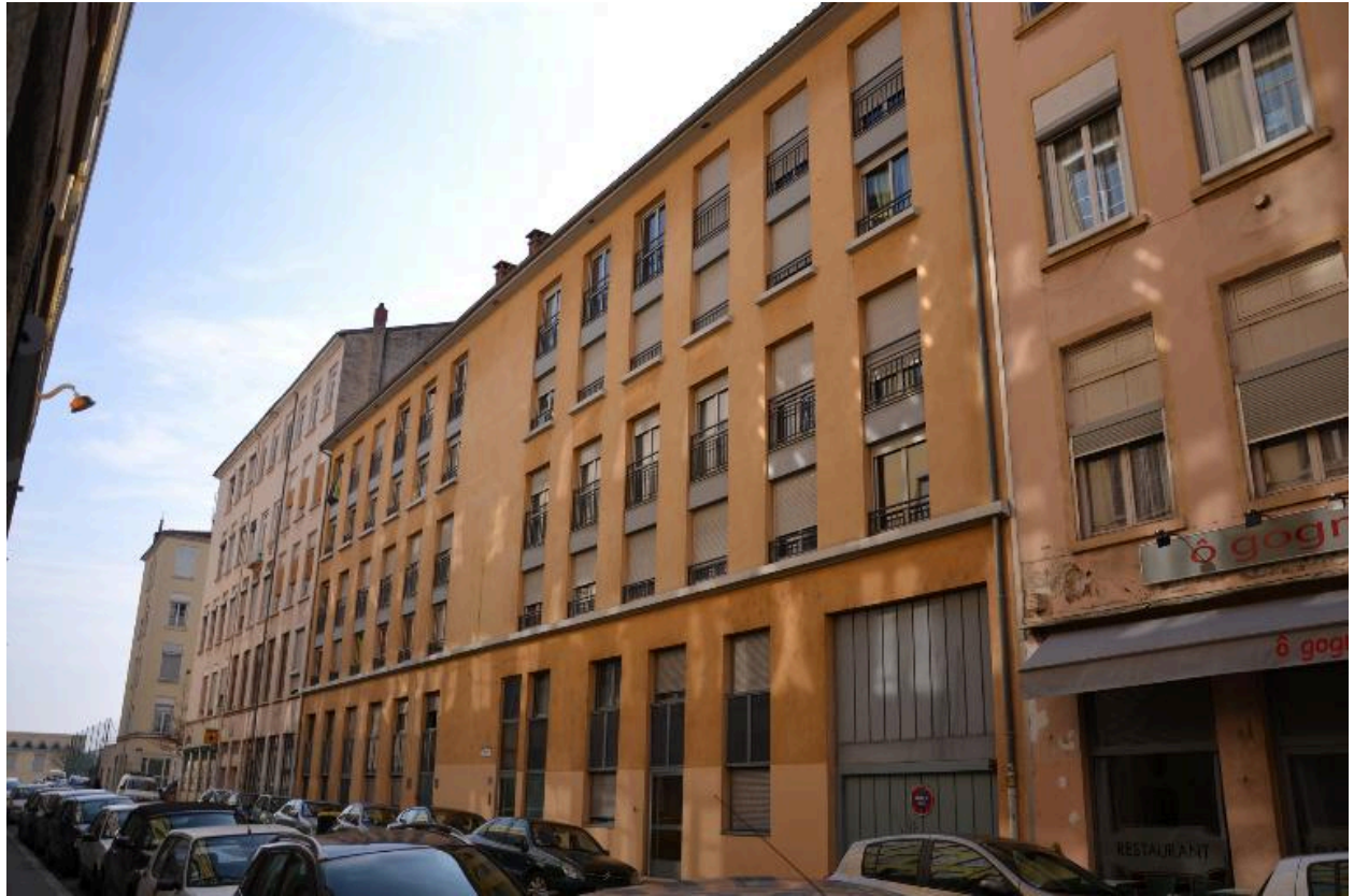
Vue d'ensemble façade nord
