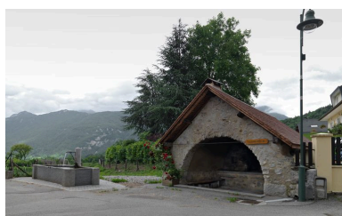
Vue générale après restauration. Phot. Eric Dessert IVR82_20117400139NUCA
