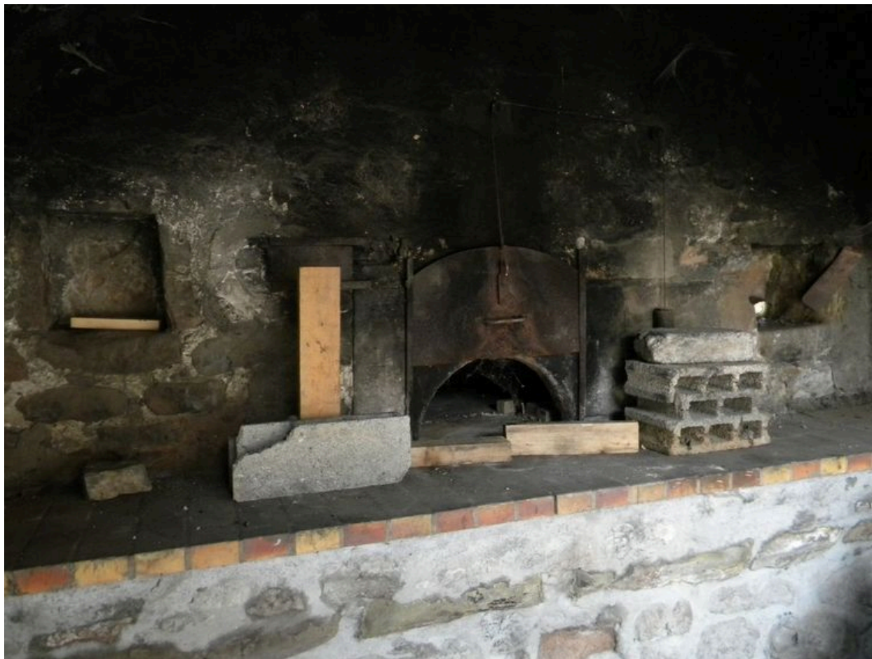
Vue de la bouche du four avant restauration.
