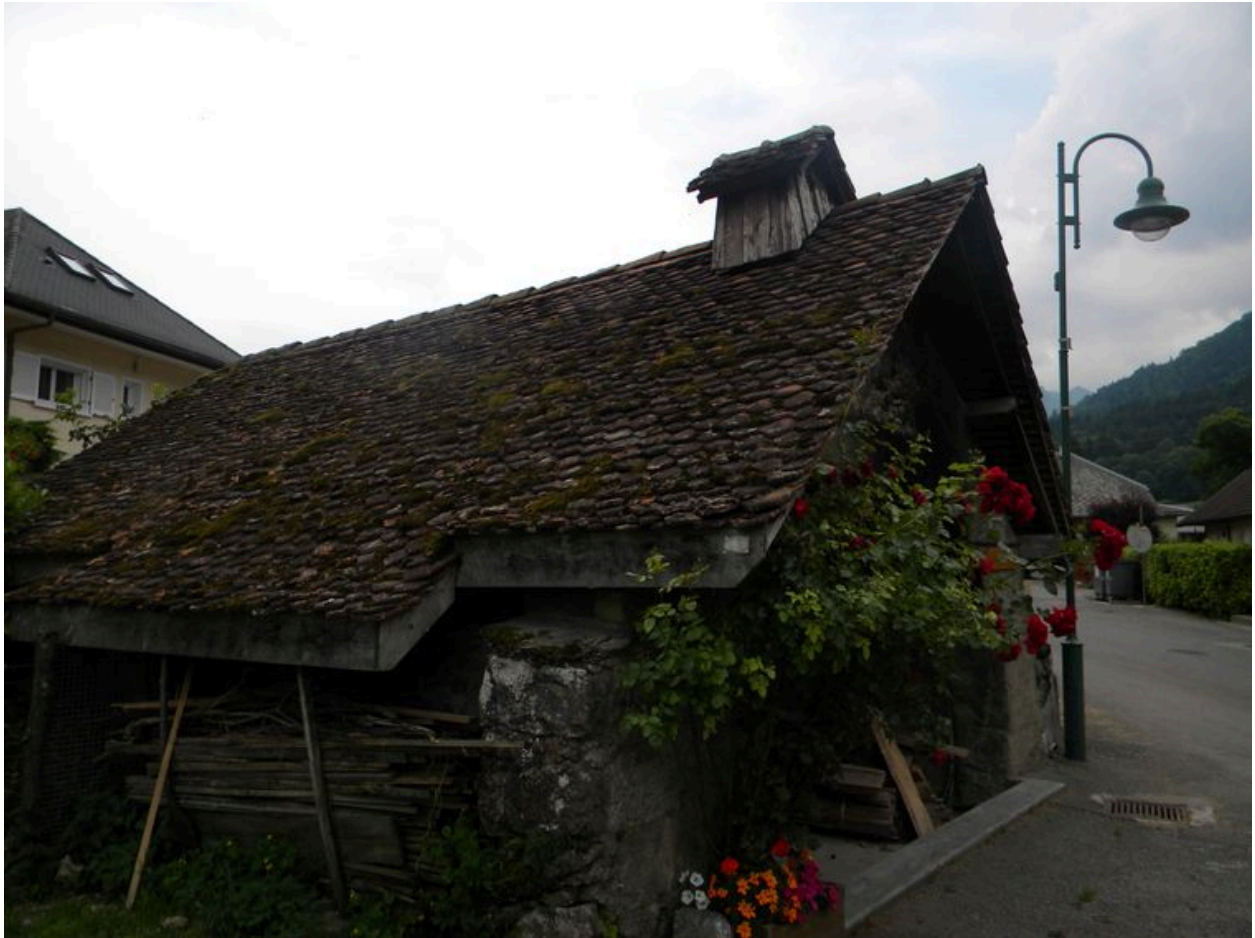
Vue latérale du four avant restauration.
