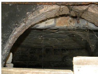
Détail de la voûte de cuisson avant restauration. Phot. Jérôme Daviet IVR82_20127400604NUCA
