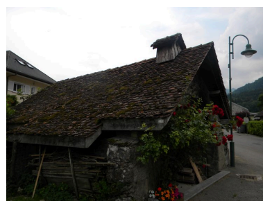
Vue latérale du four avant restauration. Phot. Jérôme Daviet IVR82_20127400602NUCA
