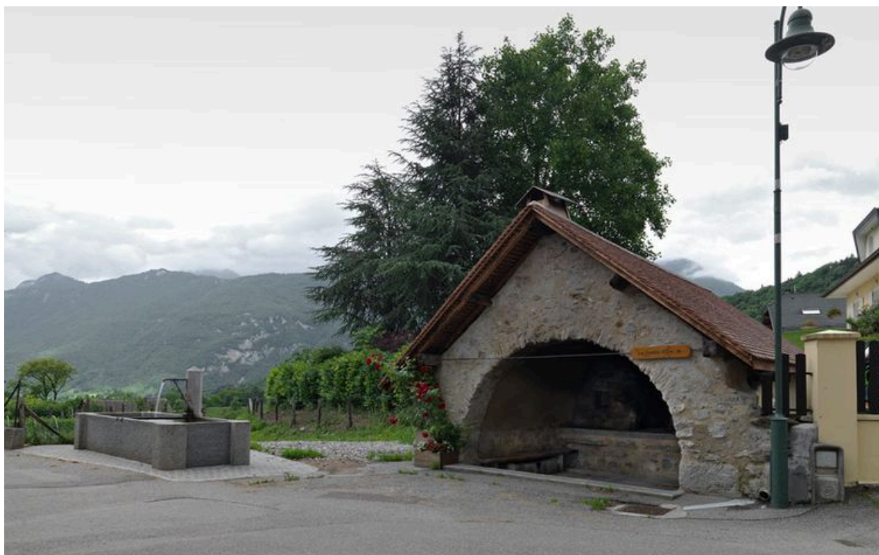
Vue générale après restauration.
