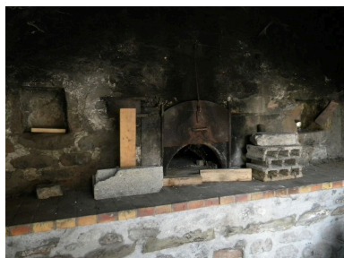
Vue de la bouche du four avant restauration. Phot. Jérôme Daviet IVR82_20127400603NUCA
