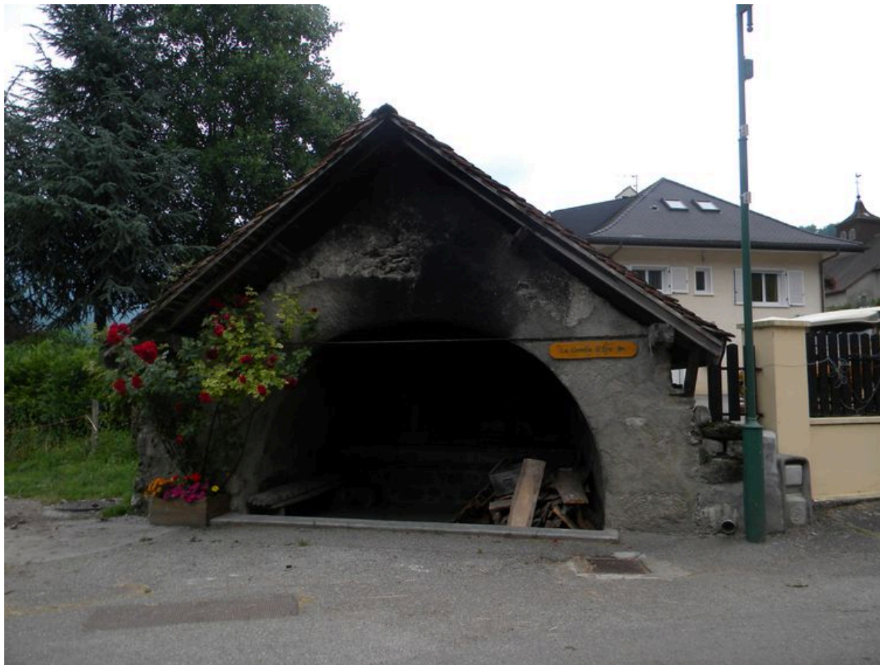
Four avant restauration vue de face.
