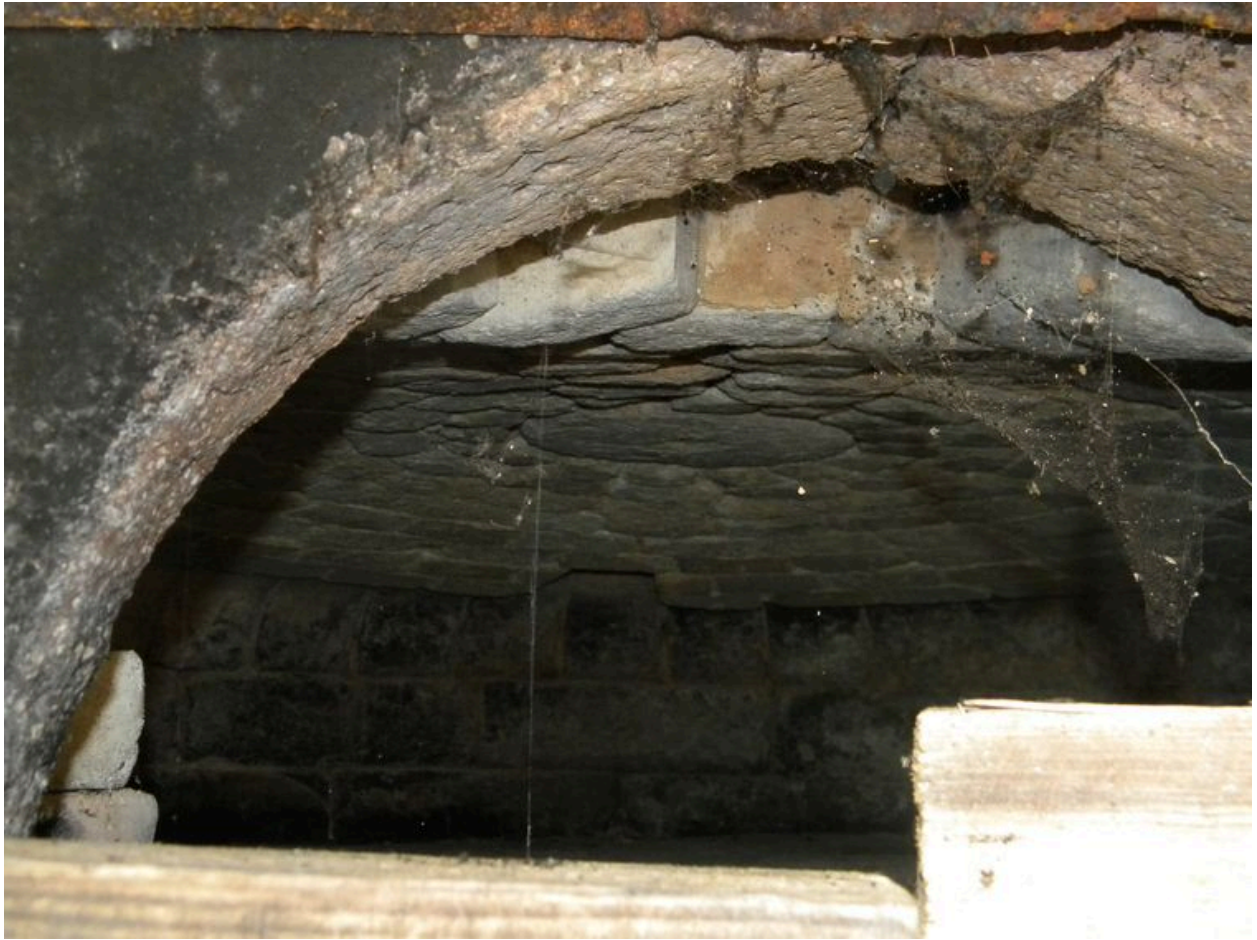
Détail de la voûte de cuisson avant restauration.
