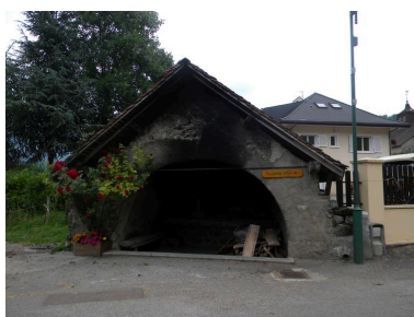
Four avant restauration vue de face. Phot. Jérôme Daviet IVR82_20127400601NUCA
