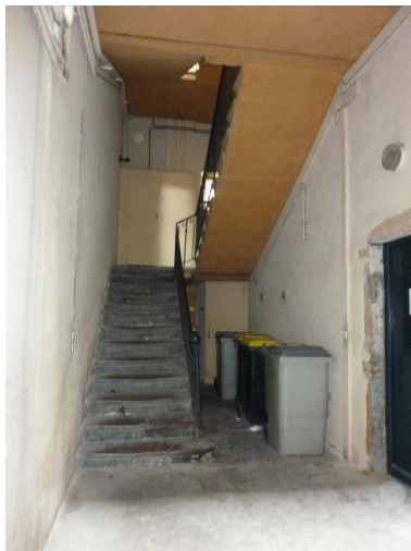
Vue de l'escalier Phot. Nadine Halitim-Dubois IVR84_20186901266NUCA
