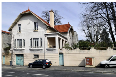
Façade sur rue Phot. Julien Defillon IVR82_20106900962NUCA
