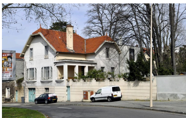
Vue générale Phot. Julien Defillon IVR82_20106900961NUCA
