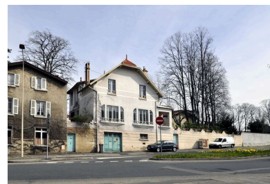
Façade sur rue et façade postérieure Phot. Julien Defillon
