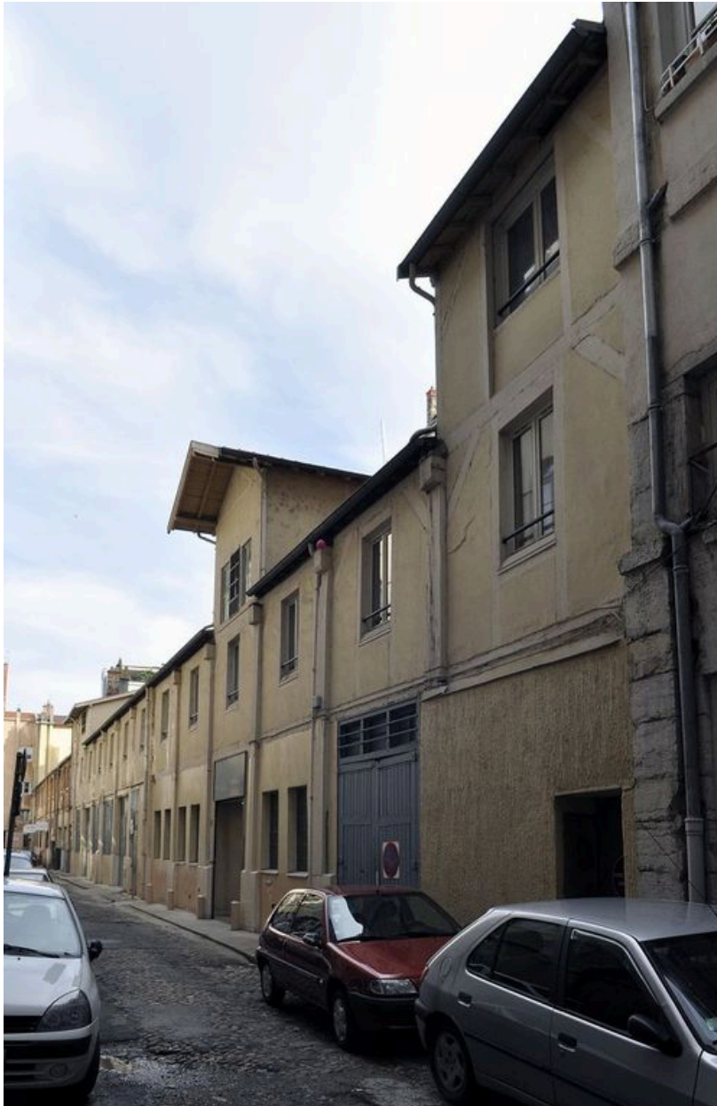
Façade antérieure, vue générale depuis le sud.
