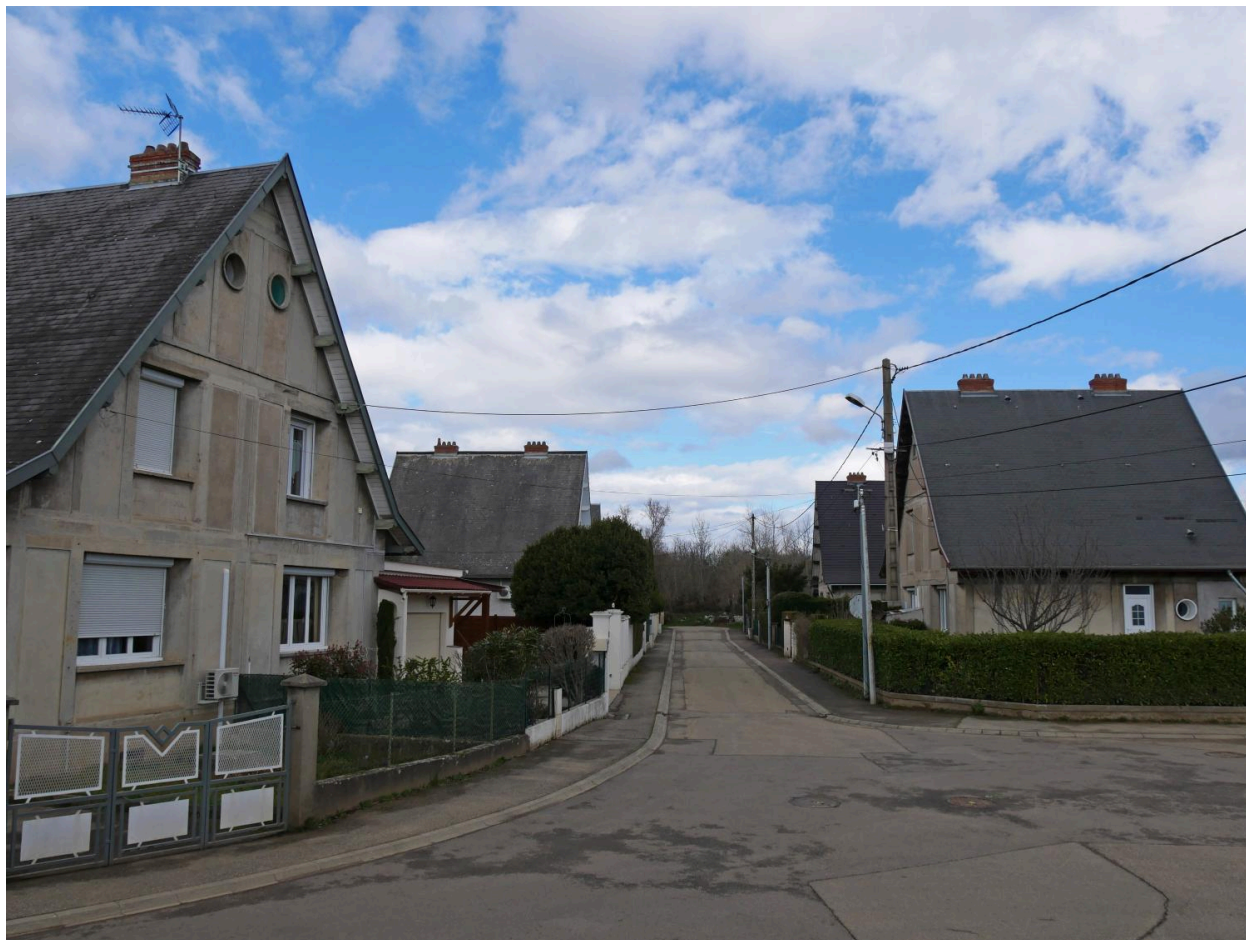
Vue de la cité du Garon (rue du Garon), système Edifico, 1947.
