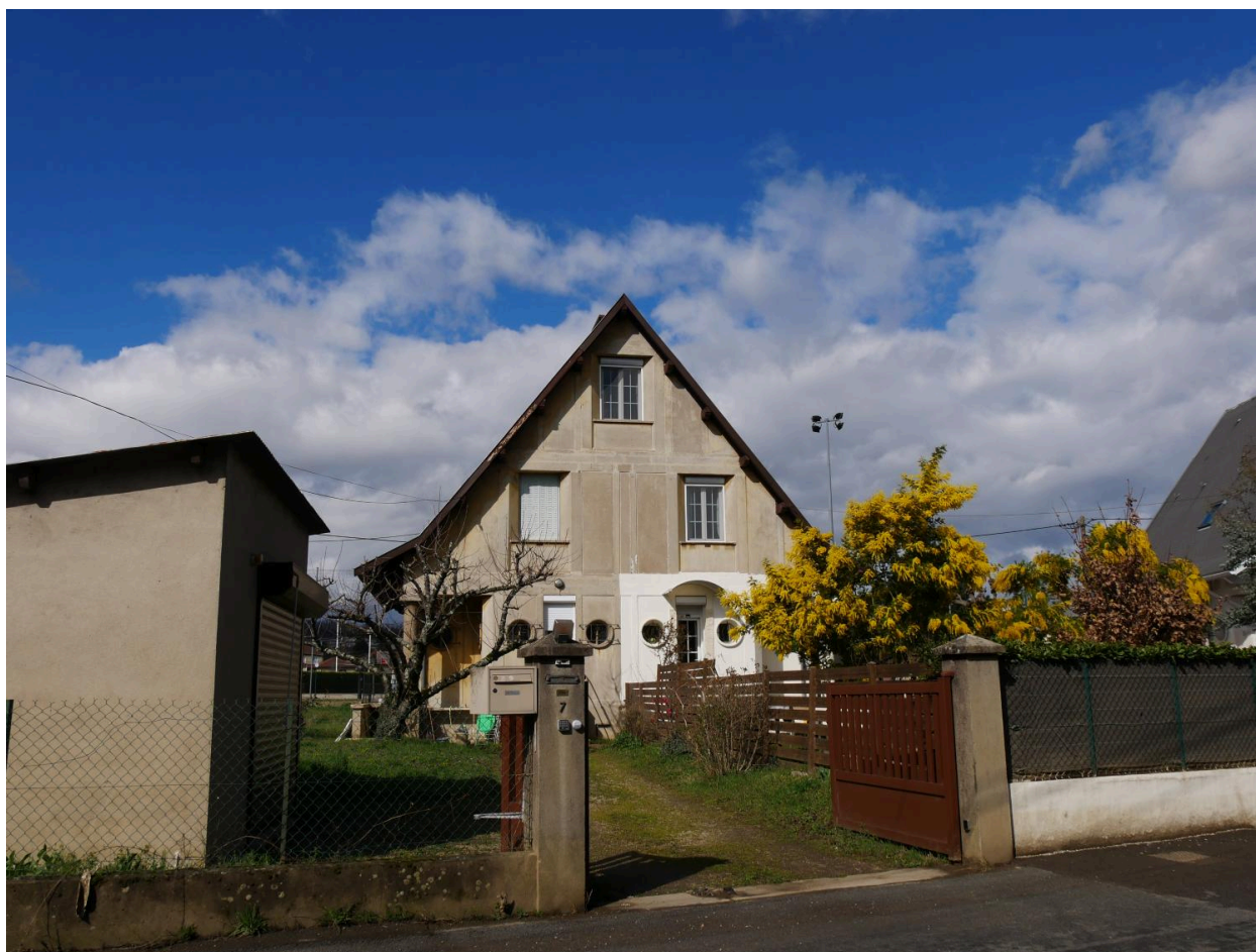
Façade principale maison de la cité du Garon système Edifico, 1947
