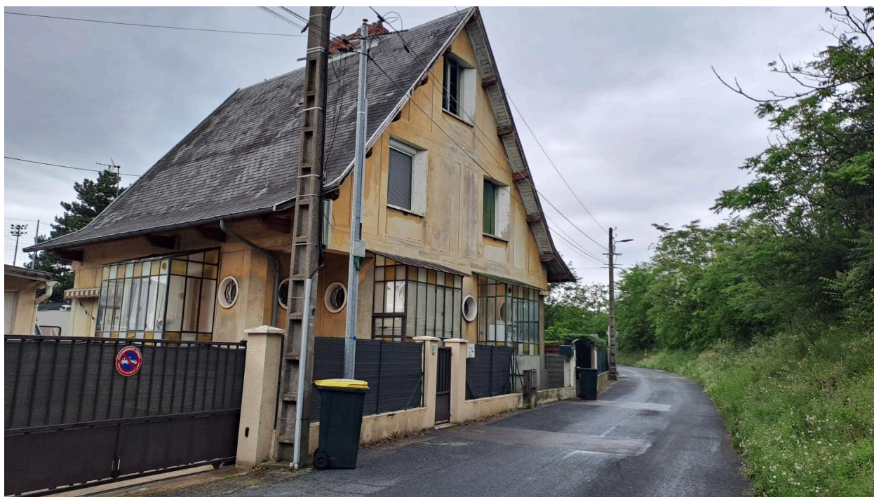
Maison de la cité du Garon système Edifico, 1947
