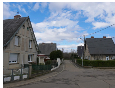
Vue de la cité du Garon (rue du Garon), système Edifico, 1947. Phot. Nadine Halitim-Dubois IVR84_20256900159NUCA
