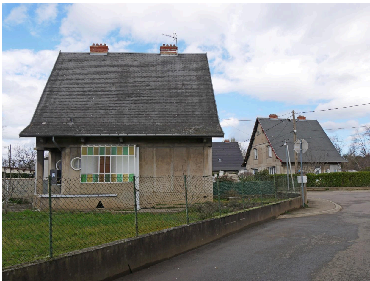
Pignon nord maison, système Edifico, 1947
