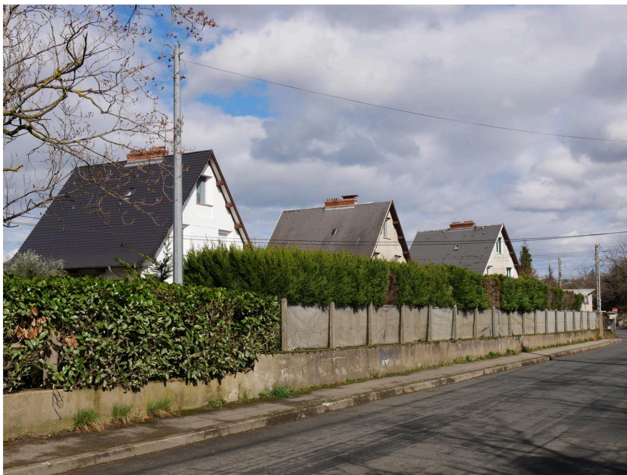
Vue d'ensemble de la cité du Garon rue Delaune
