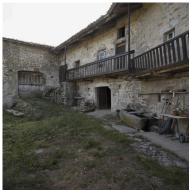
Vue d'ensemble des deux granges-étables, depuis la cour. Phot. Eric Dessert IVR82_20054201006NUCA
