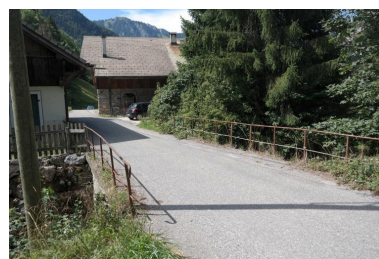
Ponceau de la Plagne, vue de la chaussée et des garde-corps Phot. Pascale Renard IVR84_20207401029NUCA
