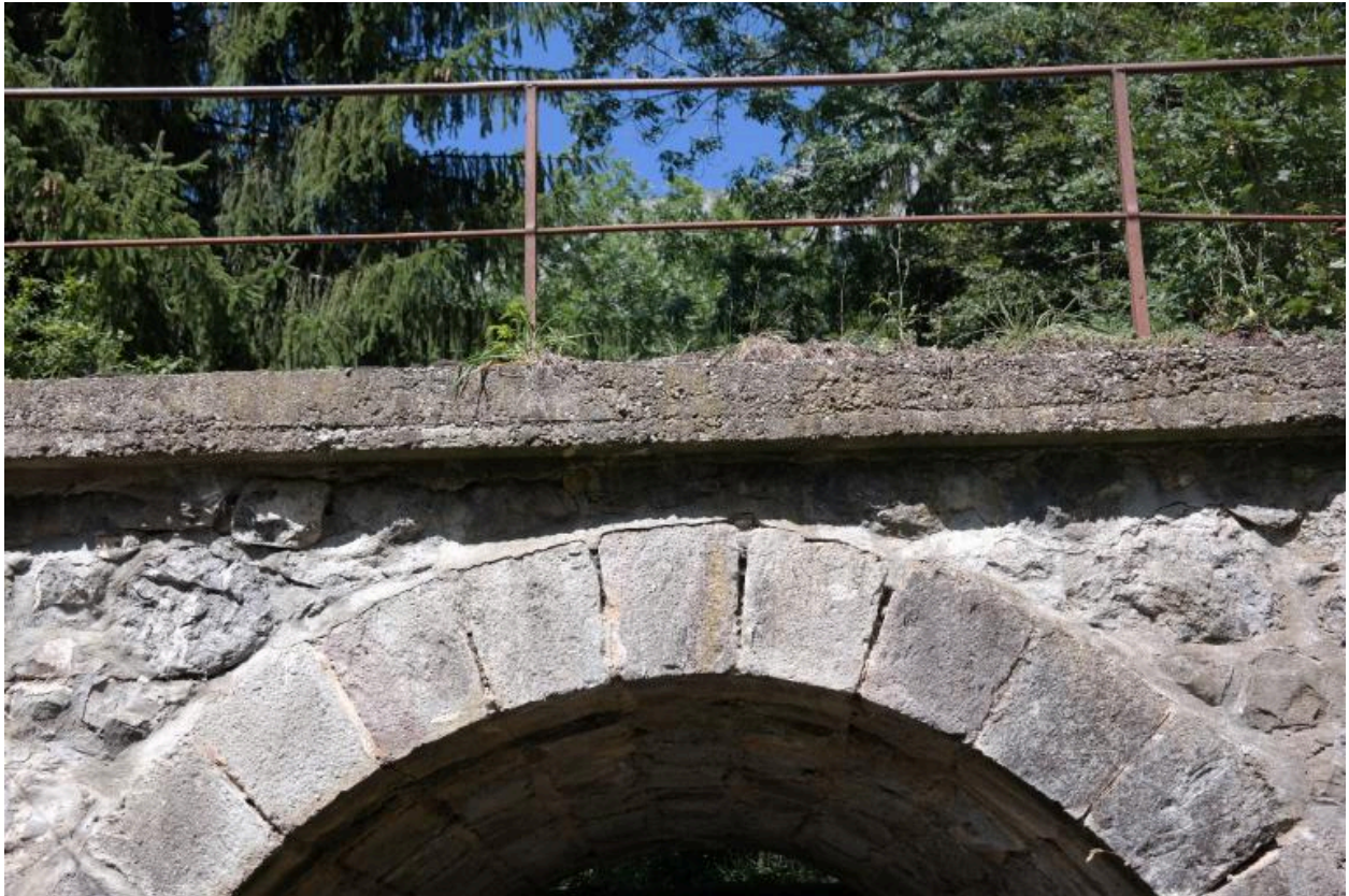
Ponceau de la Plagne, détail de la voûte et du garde-corps
