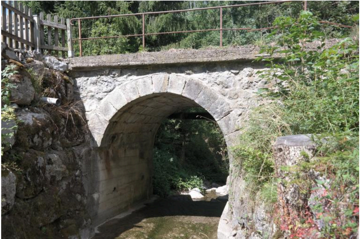
Ponceau de la Plagne, vue de la face amont
