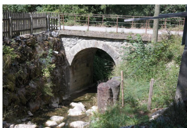
Vue générale du ponceau de la Plagne Phot. Pascale Renard IVR84_20197401211NUCA
