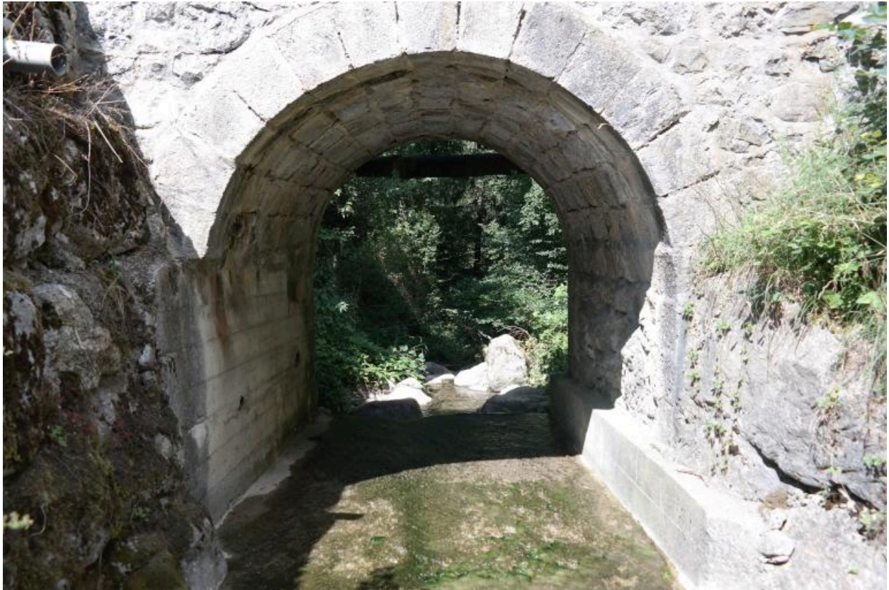
Ponceau de la Plagne, vue du dessous
