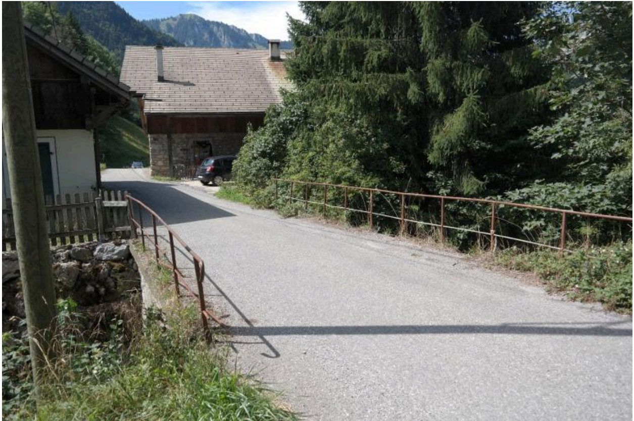
Ponceau de la Plagne, vue de la chaussée et des garde-corps
