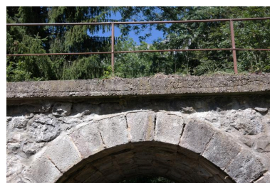
Ponceau de la Plagne, détail de la voûte et du garde-corps Phot. Pascale Renard IVR84_20207401031NUCA
