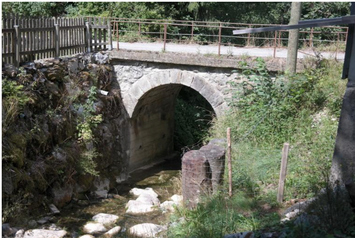
Vue générale du ponceau de la Plagne
