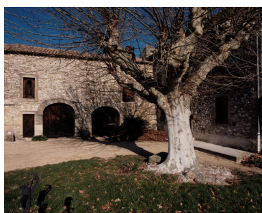
La cour de la ferme, vue partielle. Phot. Alain Franchella IVR82_19982600044XA
