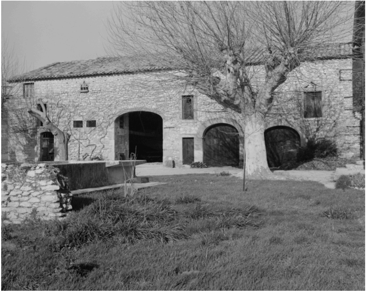
Corps de bâtiment en retour du logis de maître : dépendances agricoles et logis du fermier.
