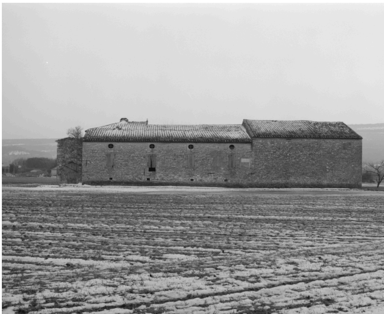
Elévation postérieure du corps principal : dépendances agricoles et logis du fermier.
