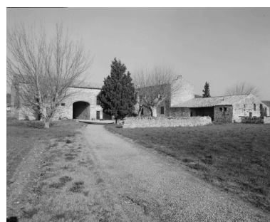
Vue générale de la ferme. Phot. Alain Franchella IVR82_19982600047X
