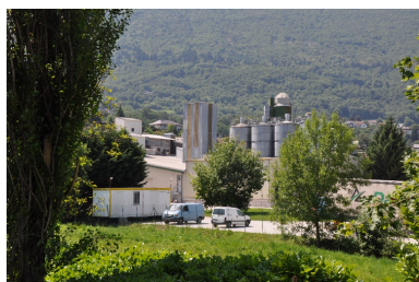
Vue de la minoterie Degrange Phot. Yannick Milleret IVR82_20127301977NUCA
