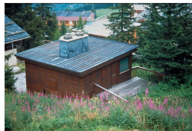
Vue de la toiture Phot. Jean-François Lyon-Caen IVR82_19987300082ZA
