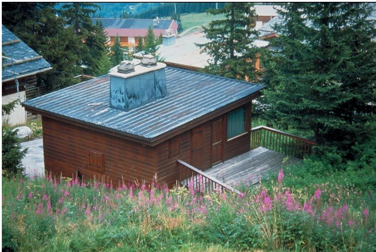
Vue de la toiture
